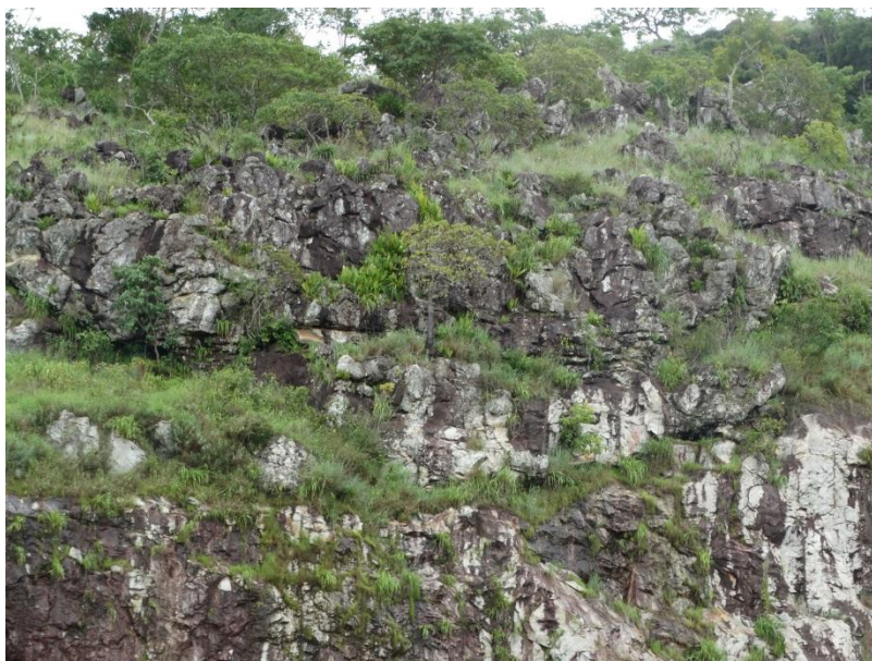
Figura 6.2-82. Zona com tendência ao deslizamento de rochas na Serra do Sereno
