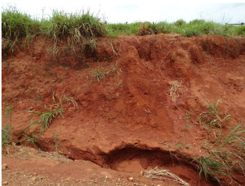
Figura 6.2-110. Aprofundamento de canal de estrada desenvolvendo-se em um Latossolo Vermelho.
