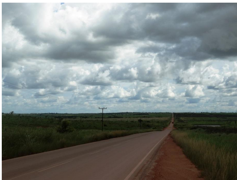
Figura 6.2-74. Superfícies pediplanas da Depressão Periférica do Sul do Pará ao longo da rodovia PA150 (Depressão do Baixo Rio Araguaia, descrita no mapeamento IBGE/2006).
