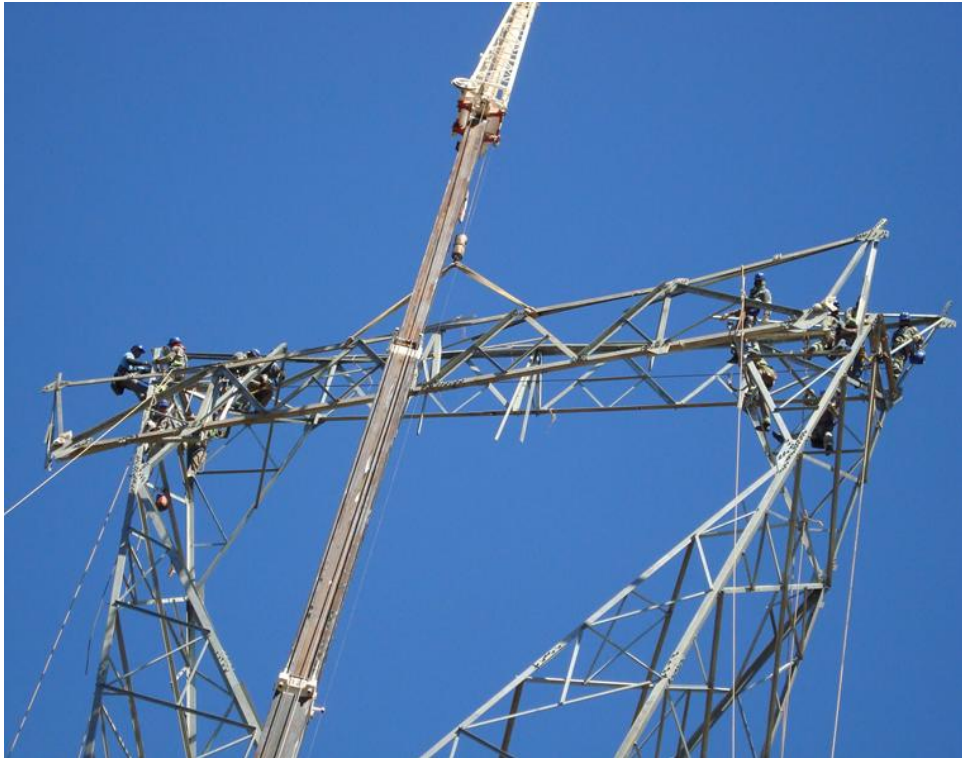
Figura 4.6-3 - Montagem de torres Autoportantes.
