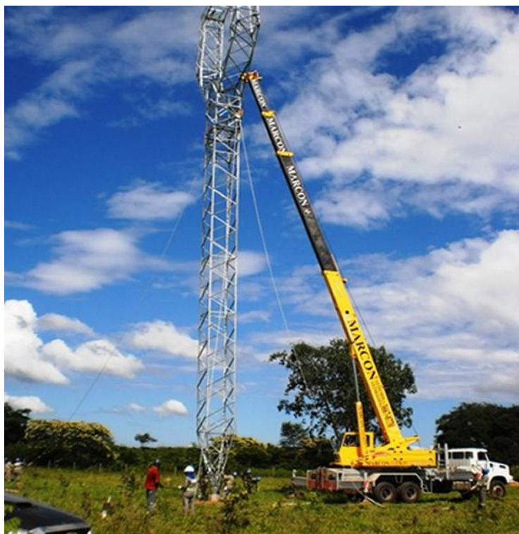
Figura 4.6-2 - Içamento de torres do tipo estaiada
