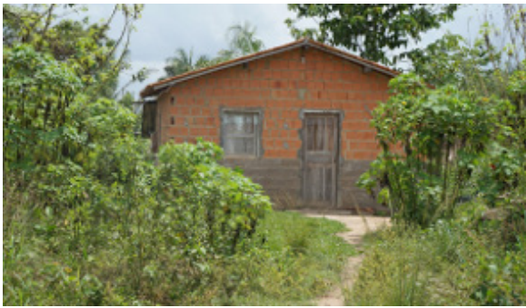
Foto 4.4.8.4-48: Residência de alvenaria em razoáveis condições (9438671.53 m S 682324.57 m E), distante 112m a leste do traçado da futura LT. Uso do Solo: mata secundária
