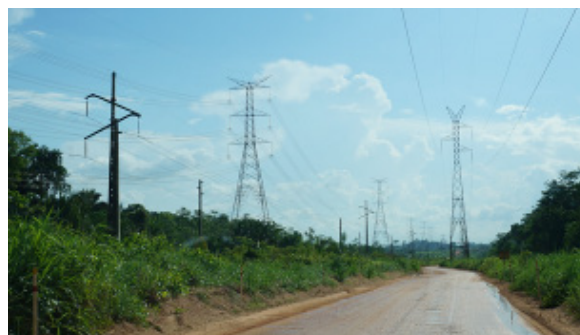
Foto 4.4.8.4-76: Torres de transmissão da SE Itacaiúnas (9399524.53 m S 708636.25 m E) distância de 2,7km a oeste da diretriz da LT
