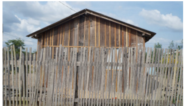
Foto 4.4.8.4-140: Residência de madeira no bairro Castanhal
