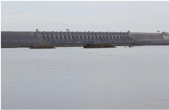
Foto 4.2.2-3: Visão frontal da Usina Hidrelétrica de Tucuruí (Ponto TC-86, Tabela 4.2-1)
