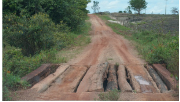
Foto 4.4.8.4-93: Ponte rudimentar na estrada vicinal, em condições ruins de trafegabilidade (9224974.87 m S 752139.99 m E), distante 1,2 km a oeste do traçado da futura LT. Uso do Solo: Pasto e mata secundária
