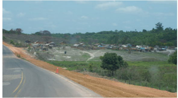
Foto 4.4.8.4-27: Acampamento de Trabalhadores Rurais São Sebastião, às margens da Rodovia PA – 150 (9559491.60 m S 715991.41 m E), distante 500m a leste do traçado da futura LT
