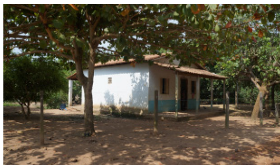
Foto 4.4.8.4-156: Residência de alvenaria em razoáveis condições em uma propriedade rural (9407646.98 m S 692802.64 m E), distante 540m a oeste do traçado da futura LT
