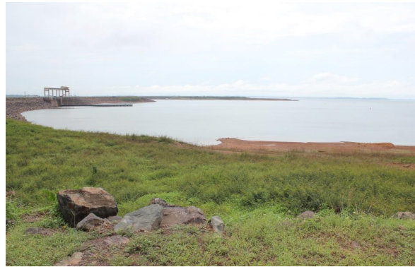
Foto 4.2.2-4: Visão da Usina Hidrelétrica de Tucuruí (Ponto TC-88, Tabela 4.2-1)
