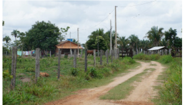
Foto 4.4.8.4-47: Residência de alvenaria em estado regular (9438782.73 m S 682349.62 m E), distante 120m a leste do traçado da futura LT. Uso do Solo: Pasto e vegetação secundária
