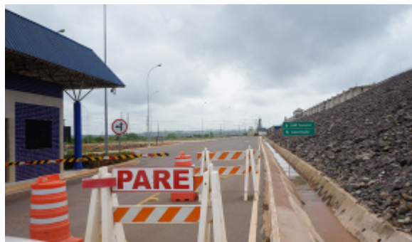
Foto 4.4.8.4-2: Entrada da Subestação de Tucuuruí (9576172.14 m S 649118.23 m E)
