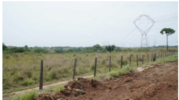
Foto 4.4.8.4-213: Cruzamento do traçado da futura LT com a Rodovia PA – 150, a montante (9541617.92 m S 716627.71 m E). Uso do Solo: Pasto
