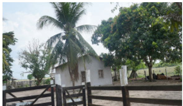
Foto 4.4.8.4-235: Cruzamento do traçado da futura LT com estrada vicinal, a montante (9585319.60 m S 669029.29 m E), residência próxima ao paralelo – 70m ao norte paralelo às LTs instaladas.
