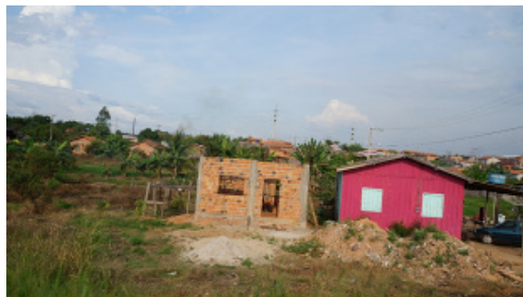
Foto 4.4.8.4-150: Residência de madeira em razoável estado e ao lado uma casa em construção de alvenaria no município de Jacundá – PA.
