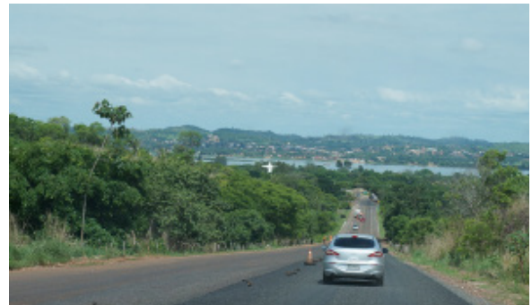
Foto 4.4.8.4-86: Obras de recapeamento na BR – 153, município de Xambioá/TO (9288705.51 m S 773729.71 m E).
