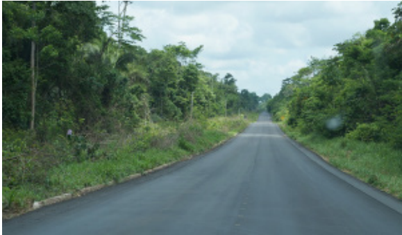
Foto 4.4.8.4-83: Obras de recapeamento na BR – 153 na área da Reserva Indígena Aldeia Itahy, (9337295.36 m S 761949.29 m E). Uso do solo: mata preservada
