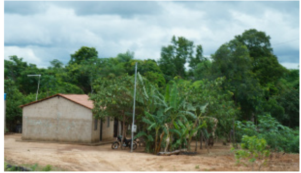
Foto 4.4.8.4-112: Residência de alvenaria em razoáveis condições, em pequena propriedade rural (9169839,35m S- 783557,39m E) distância 16,5km a oeste do traçado da futura LT
