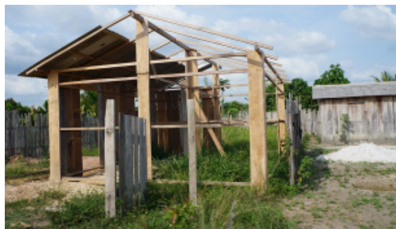
Foto 4.4.8.4-130: Construção de uma residência de madeira no bairro Batateiras
