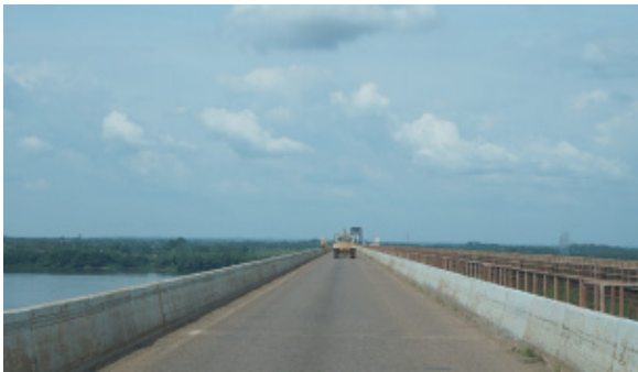
Foto 4.4.8.4-42: Ponte sobre o rio Tocantins na PA - 150, em Marabá/PA, (9411850.96 m S 712660.51 m E).
