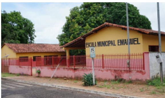
Foto 4.4.8.4-183: Escola Municipal Emanuel, construída em alvenaria, apresentando razoáveis condições de estrutura, no povoado quilombola Cocalinho.
