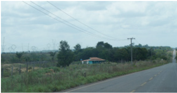
Foto 4.4.8.4-14: Residência às margens da rodovia PA-263, que apresenta boas condições de tráfego (9583038.48 m S 692210.37 m E), a uma distância de 300m ao sul do traçado da futura LT
