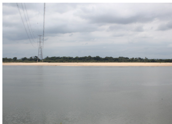
Figura 4.2.10-3: Travessia Rio Araguaia
