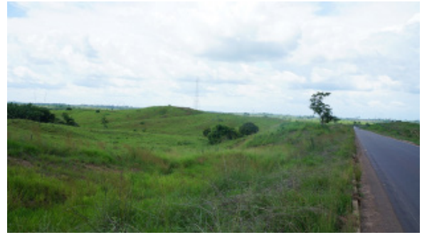
Foto 4.4.8.4-219: Cruzamento da futura LT com a Rod PA-150, a montante (9367011.91 m S 705759.57 m E) paralelo às LTs instaladas. Uso do Solo: Pasto
