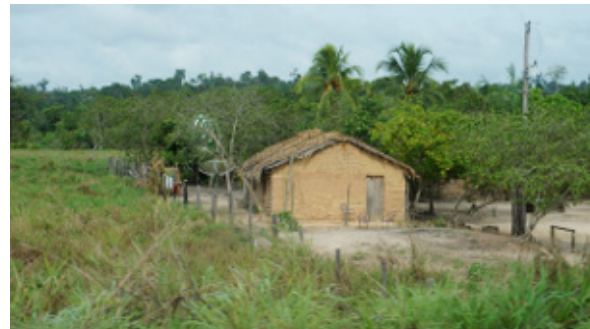
Foto 4.4.8.4-35: Residência de taipa em péssimas condições às margens da Rodovia PA-150 (9491032.56 m S 710683.56 m E), distante 52m a leste do traçado da futura LT
