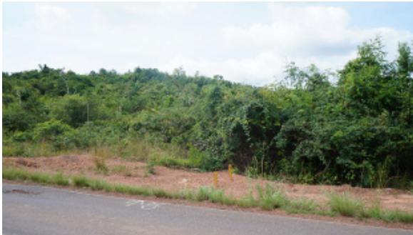
Foto 4.4.8.4-206: Cruzamento do traçado da futura LT com a Rodovia PA – 263, a montante (9583246.35 m S 682537.17 m E). Uso do Solo: Pasto e Mata
