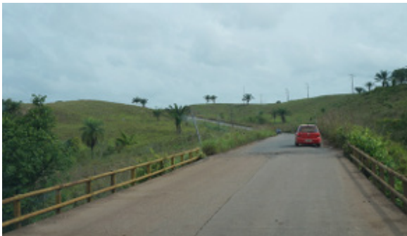
Foto 4.4.8.4-34: Ponte na Rodovia PA-150, estrada apresentando péssimas condições (9543959.67 m S 716921.19 m E), distante 500m a oeste do traçado da futura LT.
