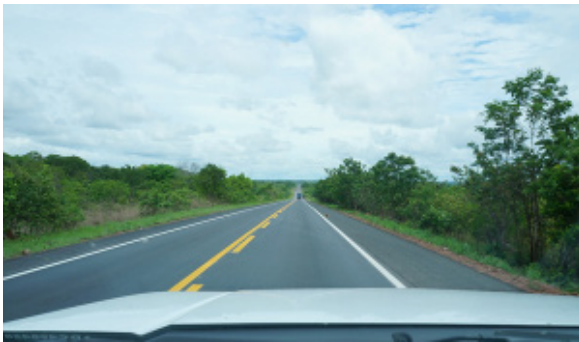
Foto 4.4.8.4-119: Ótimas condições da BR-153 nos trechos reformados (9131436,44m S 780245,28 m E) distância 1,9 km a leste do traçado da futura LT
