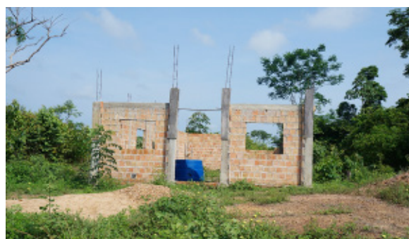
Foto 4.4.8.4-63: Construção de alvenaria (9406738.44 m S 693787.11 m E), distante 450m a oeste do traçado da futura LT.
