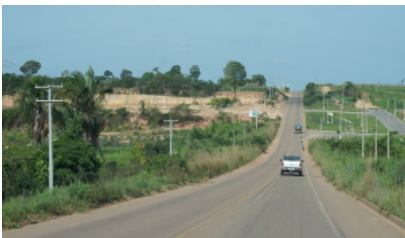
Foto 4.4.8.4-72: Boas condições de tráfego na BR-230, em Marabá/PA (9405530,01 m S 704514,313 m E), distante 2,2 km do traçado da futura LT.
