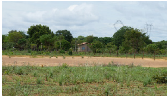
Foto 4.4.8.4-195: Residência de alvenaria em razoáveis condições, em pequena propriedade rural na Comunidade PA-2 (9123431.98 m S - 780492.39 m E) distante 300m a leste do traçado da futura LT. Uso do solo: Pasto
