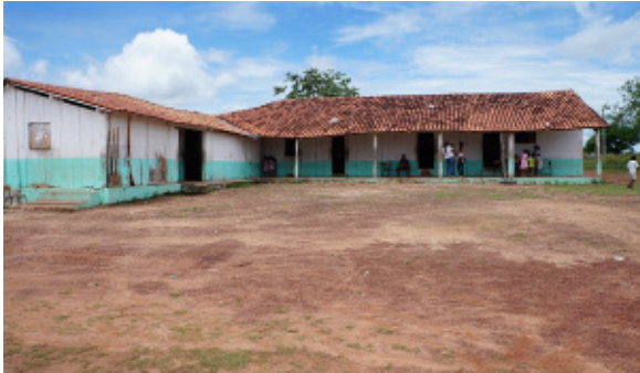
Foto 4.4.8.4-169: Escola construída em madeira, com estrutura em estado ruim, na Agrovila do P.A. Reunidas em Aragominas/TO
