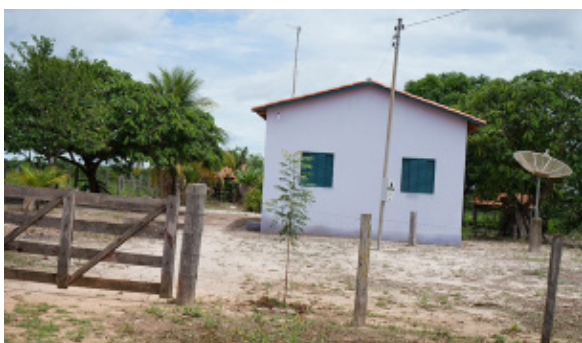
Foto 4.4.8.4-165: Residência de alvenaria, em bom estado, na Agrovila do P.A. Reunidas, em Aragominas/TO (9239979.61 m S 751429.29 m E) distante 60m a leste do traçado da futura LT
