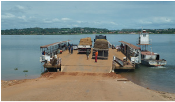
Foto 4.4.8.4-85: Balsa de travessia do Rio Araguaia na BR – 153, município de Xambioá/TO - São Geraldo do Araguaia (9290729.07 m S 771740.91 m E).
