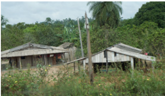
Foto 4.4.8.4-36: Residência de madeira em péssimo estado, às margens da Rodovia PA – 150 (9491032.56 m S 710683.56 m E), distante 60m a leste do traçado da futura LT
