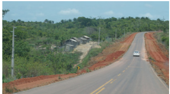
Foto 4.4.8.4-29: Rodovia PA-150 em razoáveis condições, apresentando trechos em obras de recapeamento e construção de acostamento (E 9567531.92 m S 713731.84 m)
