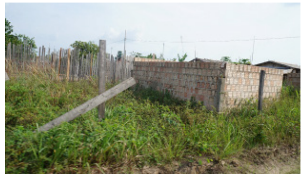
Foto 4.4.8.4-136: Construção de uma residência no bairro Batateiras
