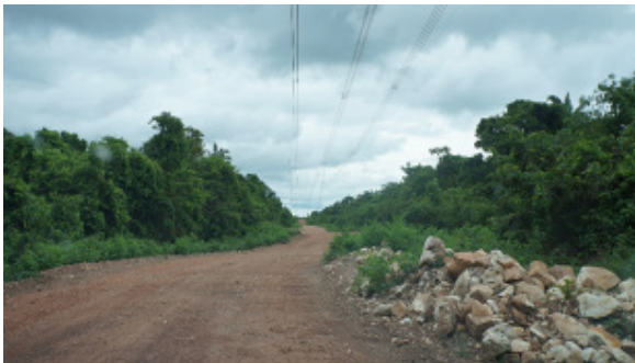
Foto 4.4.8.4-224: Cruzamento do traçado da futura LT com TO-226, a jusante (9174562.35 m S - 767232.43 m E) paralelo as LTs instaladas. Uso do solo: Mata
