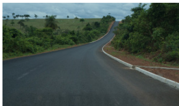
Foto 4.4.8.4-109: Trecho da TO-226 em pavimentação sem a sinalização horizontal; pasto com bovinos à direita (9175015,75m S 771900,22m E) distância de 7km a leste do traçado da futura LT
