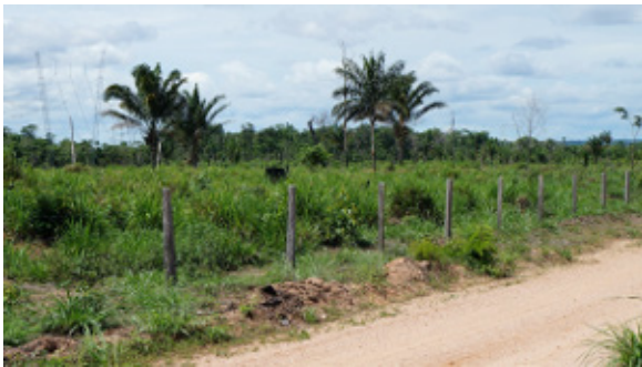
Foto 4.4.8.4-268: Cruzamento do traçado da futura LT com estrada vicinal, a montante (9252701.01 m S 746582.09 m E) paralelo às LTs instaladas. Uso do Solo: Pasto e mata secundária
