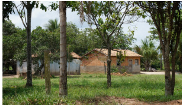
Foto 4.4.8.4-49: Residência de alvenaria em razoáveis condições (9436794.00 m S 681932.00 m E), distante 120m a leste do traçado da futura LT
