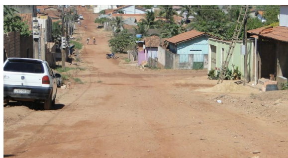
Foto 4.4.8.4 163: Ruas sem pavimentação na área urbana do município de Piçarra –TO. (PMP)
