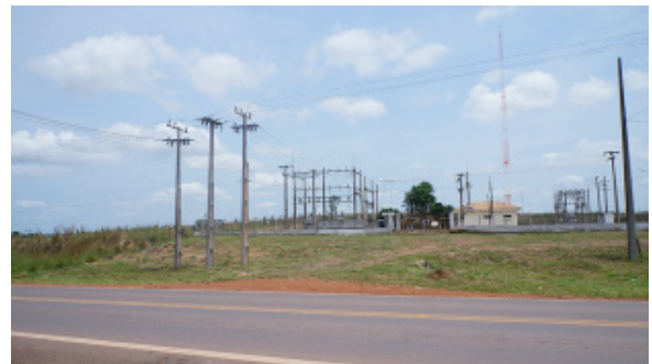
Foto 4.4.8.4-209: Cruzamento do traçado da futura LT com a Rodovia PA – 150, a jusante (E9577250.66 m S 711458.16 m) Uso do Solo: Pasto e urbano
