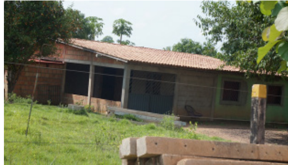
Foto 4.4.8.4-158: Casa de alvenaria em boas condições na propriedade rural (9408755.24 m S692773.10 m E), distante 171m a leste do traçado da futura LT
