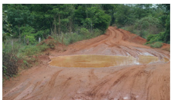
Foto 4.4.8.4-97: Estrada vicinal sem pavimentação e com condições de trafegabilidade ruins em diversos pontos, em Santa Fé do Araguaia/TO (9218267.15 m S 753284.70 m S) distante 337m a oeste do traçado da futura LT
