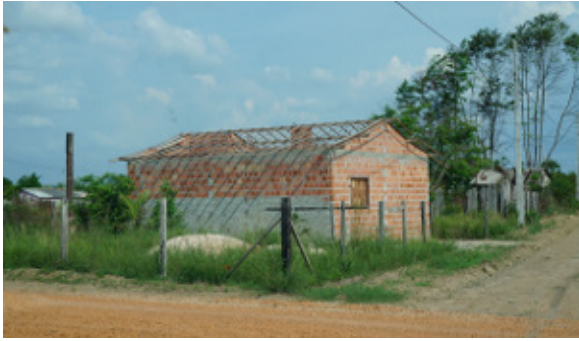
Foto 4.4.8.4-137: Construção de uma residência no bairro Castanhal (9583086.00 m S 656800.00 m E), distância de 770m a oeste do traçado da futura LT
