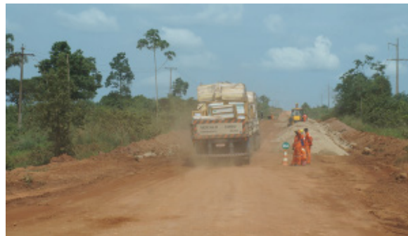
Foto 4.4.8.4-59: Tráfego de caminhões pesados na BR-230, rodovia em pavimentação.
