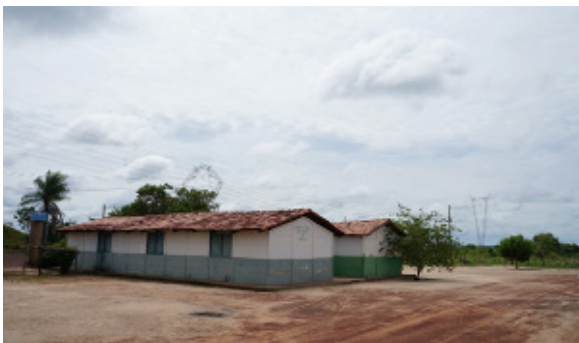
Foto 4.4.8.4-196: Escola Municipal São Tomaz de Aquino desativada e utilizada como residência na Comunidade PA-2, localizada sob as LTs existentes (9123730.35 m S - 779890.96 m E) distante 200m a oeste do traçado da futura LT. Uso do solo: solo exposto
