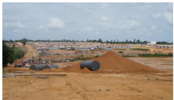
Foto 4.4.8.4-57: Canteiro de obras do Programa "Minha Casa Minha Vida" (9431257.88 m S 681839.62 m E), distante 1,0km a oeste do traçado da futura LT, em Itupiranga/PA
