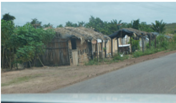
Foto 4.4.8.4-30: Acampamento do MST, com barracos de madeira em péssimas condições, às margens da Rodovia PA-150 (9517995.31 m S 711768.36 m E), distante 1,6km a leste do traçado da futura LT
