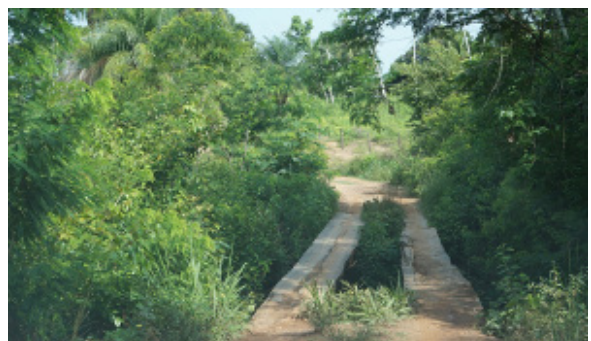
Foto 4.4.8.4-69: Ponte rudimentar de madeira em condições ruins (9405662.06 m S 695400.66 m E), distante 500m a oeste do traçado da futura LT. Uso do Solo: mata secundária
