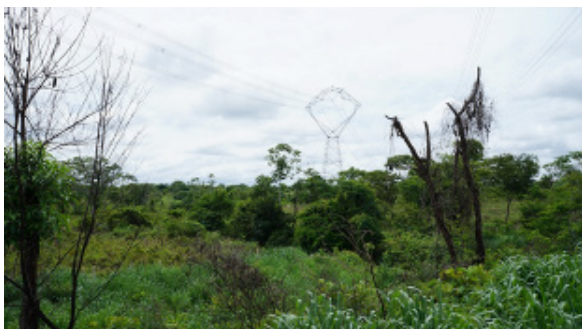
Foto 4.4.8.4-228: Cruzamento do traçado da futura LT com BR 153, a montante (9125327.79 m S - 779763.60 m E) paralelo às LTs instaladas. Uso do solo: Pasto sujo
