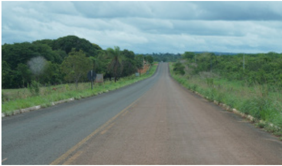
Foto 4.4.8.4-113: Boas condições da TO-226. (9169782,77 m S 785206,06 m E), distância de 17km a leste do traçado da futura LT
