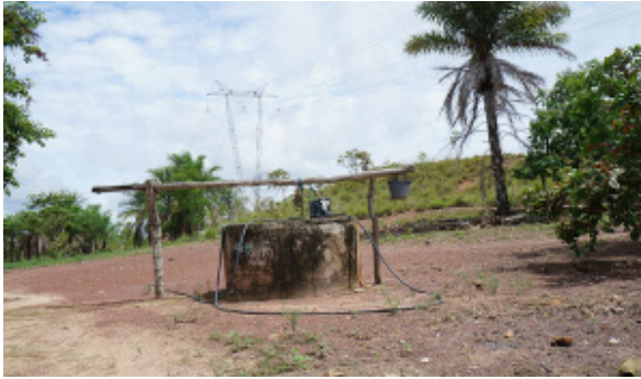
Foto 4.4.8.4-198: Poço seco na Escola Municipal São Tomaz de Aquino, que está desativada, servindo como residência na Comunidade MPA-2.
