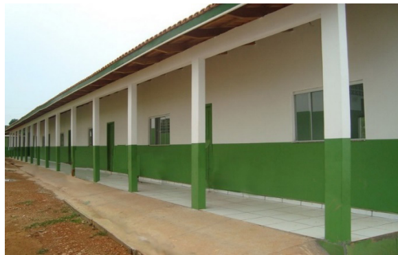
Foto 4.4.8.4-162: Escola Municipal Januária Vaz da Costa localizada na Vila Novo Paraíso. (PMSGa)
