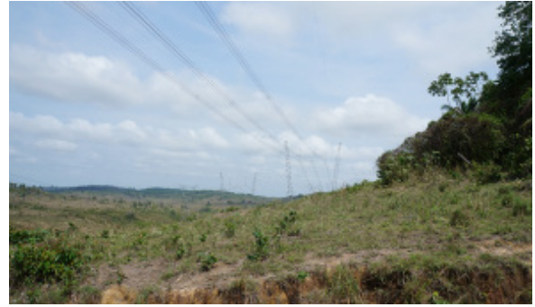
Foto 4.4.8.4-243: Cruzamento do traçado da futura LT com estrada vicinal, a montante (9547467.90 m S 715988.11 m E) paralelo às LTs Instaladas. Uso do Solo: Pasto
