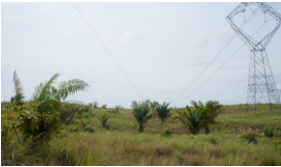
Foto 4.4.8.4-244: Cruzamento do traçado da futura LT com estrada vicinal, a montante (9536889.95 m S 716854.75 m E) paralelos às LTs Instaladas. Uso do Solo: Pasto
