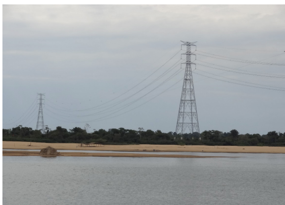
Figura 4.2.10-2: Travessia Rio Araguaia
