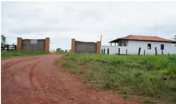
Foto 4.4.8.4-100: Entrada e sede da Fazenda Mutema, em Santa Fé do Araguaia/TO (9213713.13 m S 753882.70 m E) distante 1,6 km oeste do traçado da futura LT. Uso do Solo: pasto
