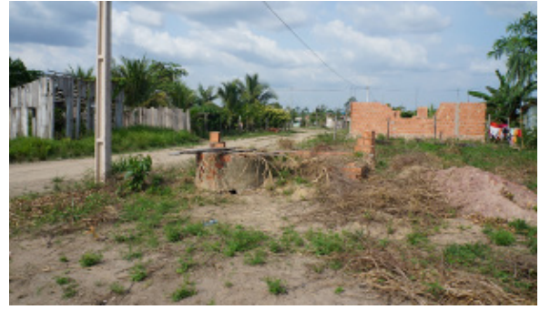
Foto 4.4.8.4-132: Residência em construção no bairro Batateiras
