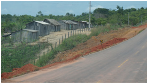
Foto 4.4.8.4-28: Acampamento de Trabalhadores Rurais Azul, às margens da Rodovia PA – 150 (E 9550857.57 m S 716445.76 m), distante 430m a leste do traçado da futura LT
