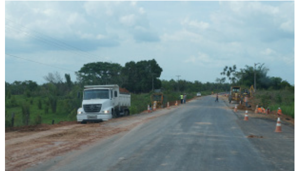
Foto 4.4.8.4-41: Rodovia PA - 150 em obras no sentido norte do município de Jacundá/PA (9440503.82 m S 712314.61 m E)
