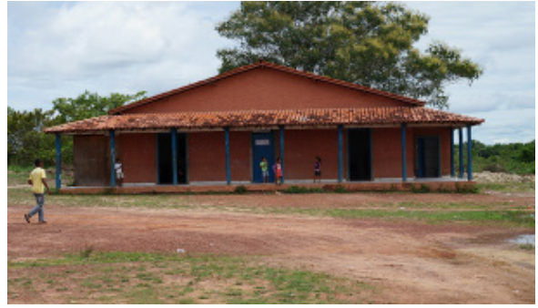
Foto 4.4.8.4-170: Escola construída em alvenaria, em bom estado, na Agrovila do P.A. Reunidas em Aragominas/TO
