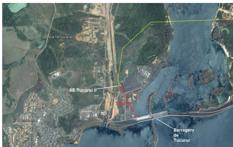
Figura 4.2.4.3: Localização do ponto inicial da LT Tucuruí – Itacaiúnas II – Colinas C2 em relação a barragem da UHE Tucuruí
