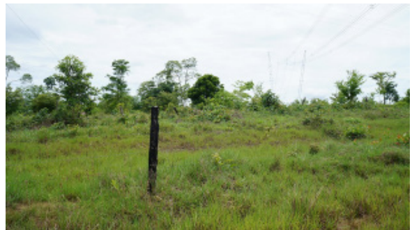
Foto 4.4.8.4-271: Cruzamento do traçado da futura LT com estrada vicinal, a jusante (9239351.60 m S 750817.96 m E) paralelo às LTs instaladas. Uso do Solo: pasto e mata secundária.
