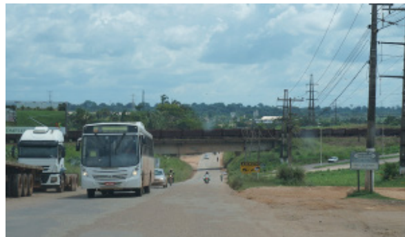
Foto 4.4.8.4-82: Razoáveis condições de tráfego na Rodovia PA – 150, na área urbana de Marabá/PA, vista do viaduto ferroviário, ao fundo (9406844.00 m S 712915.76 m E)
