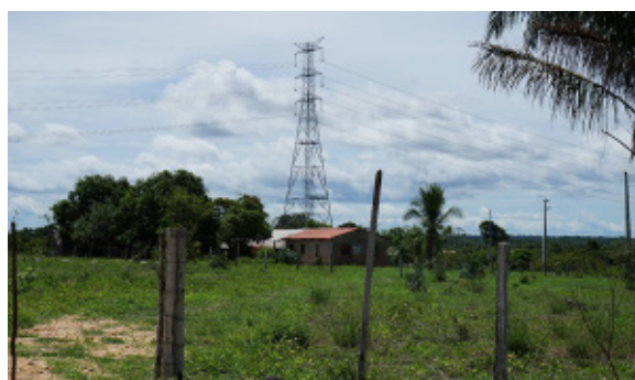
Foto 4.4.8.4-91: Residência de alvenaria sob o traçado da futura LT, em estrada vicinal (9254583.53 m S 746070.77 m E) paralelo às LTs instaladas. Uso do Solo: Pasto e mata secundária
