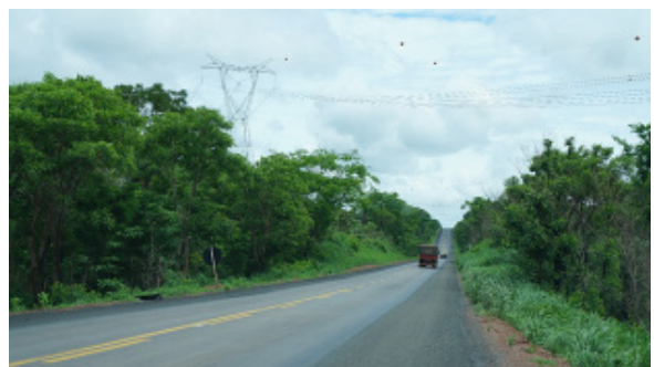
Foto 4.4.8.4-227: Cruzamento do traçado da futura LT com BR 153 (9125056.72 m S- 779674.37 m E) paralelo às LTs instaladas.
