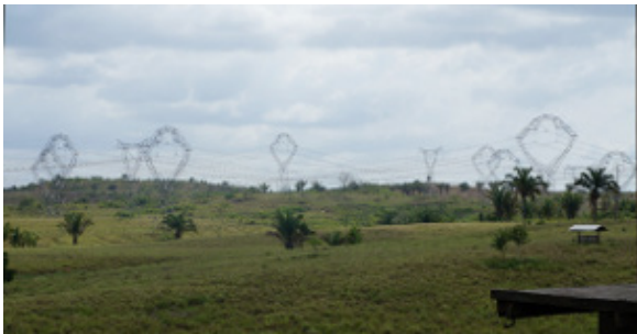
Foto 4.4.8.4-9: LTs existentes na propriedade da fazenda Águas Cristalinas paralelo ao traçado da futura LT, no município de Breu Branco-PA (9584018.82 m S 688512.63 m E). Uso do Solo: Pasto
