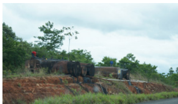
Foto 4.4.8.4-110: Tanques de piche para a pavimentação TO-226 (9173761,55 m S 779259,15 m E), distância de 10 km a leste do traçado da futura LT
