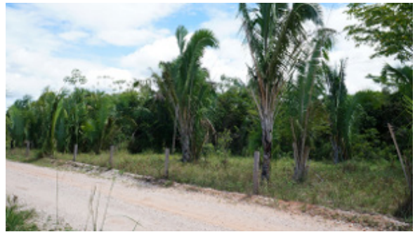
Foto 4.4.8.4-269: Cruzamento do traçado da futura LT com estrada vicinal, a jusante (9248994.25 m S 747970.71 m E) paralelo às LTs instaladas. Uso do Solo: Pasto e mata secundária
