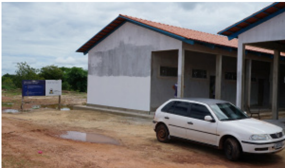
Foto 4.4.8.4-171: Escola em construção na Agrovila do P.A. Reunidas, em Aragominas/TO
