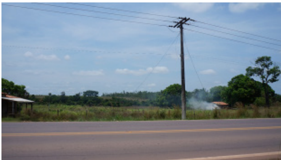
Foto 4.4.8.4-208: Cruzamento do traçado da futura LT com a Rodovia PA – 150, a montante (9577250.66 m S 711458.16 m E) Uso do Solo: Pasto
