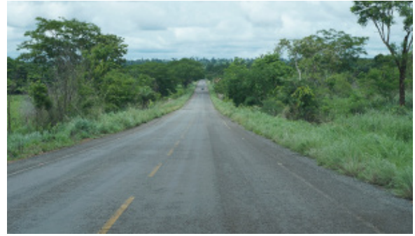
Foto 4.4.8.4-118: Razoáveis condições da TO-230 (9136473,57 m S 779137,63 m E), distância de 1,4 km a leste do traçado da futura LT
