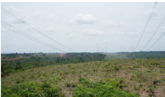
Foto 4.4.8.4-240: Cruzamento do traçado da futura LT com estrada vicinal, a jusante (9548997.37 m S 715858.54 m E) paralelo às LTs instaladas Uso do Solo: Pasto.
