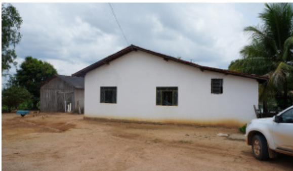
Foto 4.4.8.4-44: Sede de uma fazenda, com residência de alvenaria em boas condições, (9445578.54 m S 684794.41 m E), distante 57 m a oeste do traçado da futura LT.
