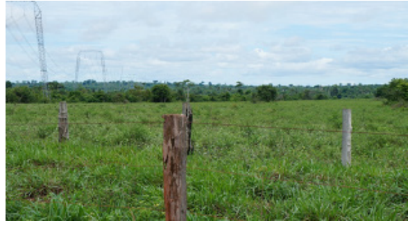
Foto 4.4.8.4-273: Cruzamento do traçado da futura LT com estrada vicinal, a montante (9222437.23 m S 753707.70 m E) paralelo às LTs instaladas. Uso do Solo: Pasto e mata secundária ao fundo.
