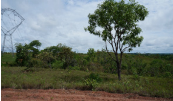
Foto 4.4.8.4-278: Cruzamento do traçado da futura da LT com estrada vicinal, a montante (9123515.02 m S - 780120.89 m E) paralelo às LTs instaladas. Uso do solo: Pasto sujo.
