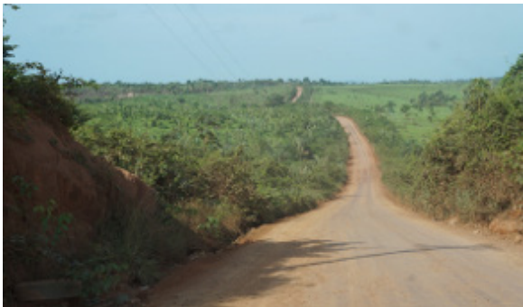
Foto 4.4.8.4-71: Estrada vicinal em boas condições, acesso ao traçado da futura LT em Marabá/PA (9404601.89 m S 697427.87 m E), distante 3 km a oeste do traçado da futura LT.
