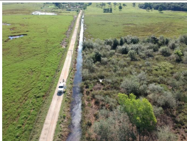
Foto 11: Vista geral da parcela FL 8, na LT Lagos – Campos 2, em Macaé/RJ.
