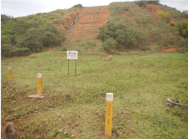
Foto 012: Vista geral da área com demarcação dos dutos da Petrobrás.
