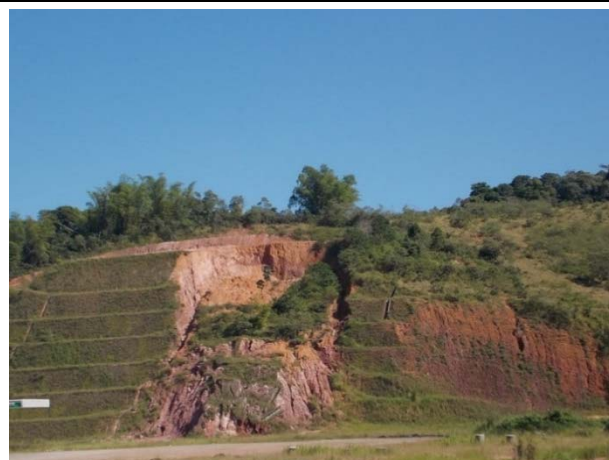
Fotos 47 e 48: Rastejo generalizados e de alta a média intensidade, escorregamentos planares e rotacionais ocasionais e de baixa intensidade, que ocorrem nos terrenos Amorreiros Baixos de Sensibilidade Geoambiental Moderada.
