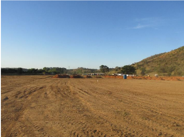
Foto 0460: Vista geral da área de construção da Subestação.
