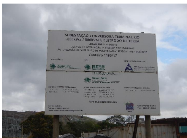
Foto 01: Área de construção da subestação em Paracambi.
