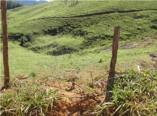
Foto 0411: Vista geral da área com pastagem e com marco do traçado da LT 500 kV Campos 2 – Mutum.
