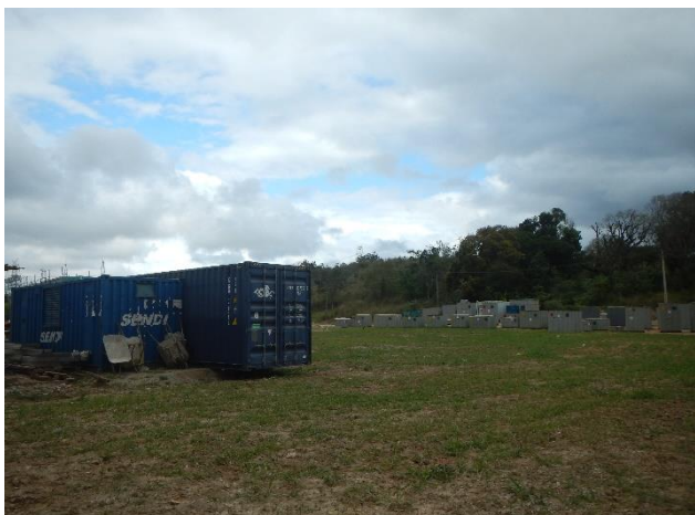
Foto 03: Área de construção da subestação em Paracambi.
