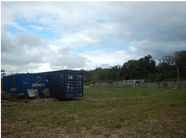
Foto 03: Área de construção da subestação em Paracambi.
