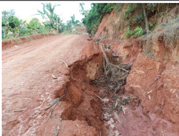
Fotos 97 e 98: Erosão em sulco frequentes de média a alta intensidade, que ocorrem nas estradas que cortam os terrenos Montanhosos e Escarpados.
