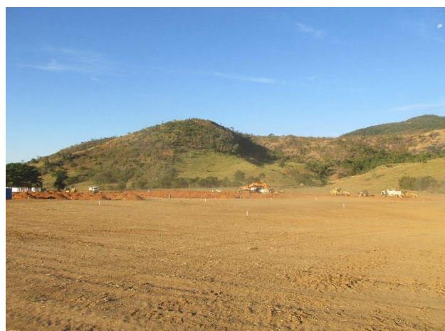
Foto 0461: Vista geral da área de construção da Subestação.
