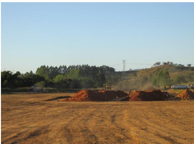
Foto 0464: Vista geral da área de construção da Subestação.
