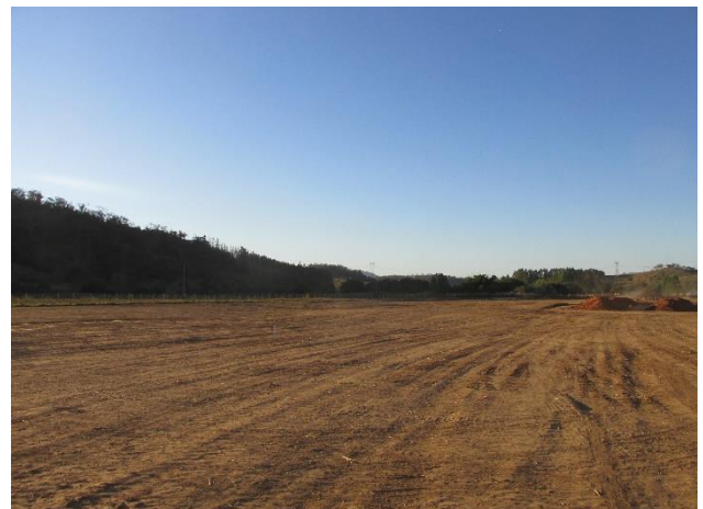
Foto 0465: Vista geral da área de construção da Subestação.
