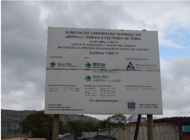
Foto 01: Área de construção da subestação em Paracambi.
