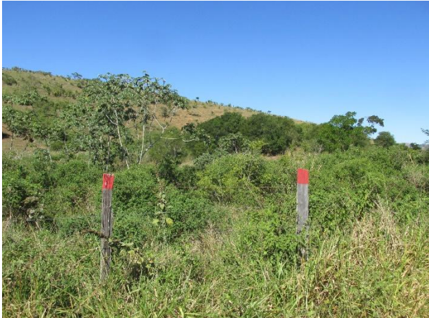
Foto 0318: Vista geral da área com marcação na cerca com a localização do traçado da LT 500 kV Campos 2 - Mutum.
