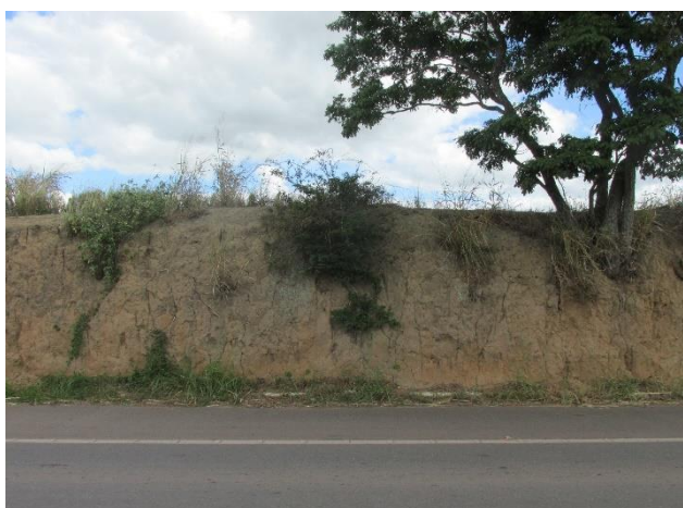
Foto 0278: Vista geral de corte de estrada com gleissolo.
