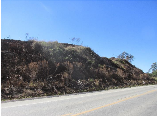
Foto 0422: Corte de estrada com exposição de latossolo.
