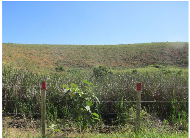
Foto 0321: Vista geral da área com marcação na cerca com a localização do traçado da LT 500 kV Campos 2 - Mutum.
