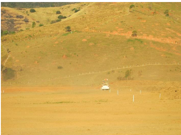
Foto 0462: Vista geral da área de construção da Subestação.
