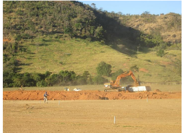
Foto 0463: Vista geral da área de construção da Subestação.
