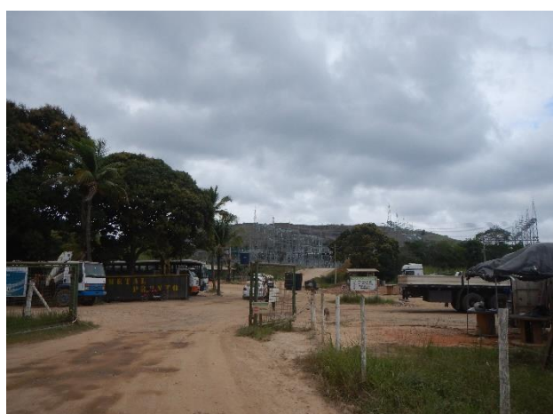
Foto 02: Vista geral da movimentação na área da construção.
