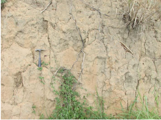
Foto 0280: Vista geral de corte de estrada com gleissolo.
