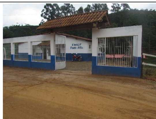
Foto 188: EMEF Ponte Alta, unidade escolar presente no Córrego Ponte Alta, que atende também os córregos da região, Iúna/ES.
