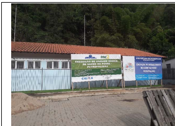
Foto 49: Unidade Básica de Saúde em construção no Distrito de Posse, Petrópolis/RJ.
