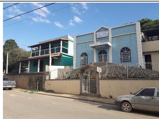
Foto 24: Casa de Oração da comunidade do Barro Branco, Paty dos Alferes, RJ.
