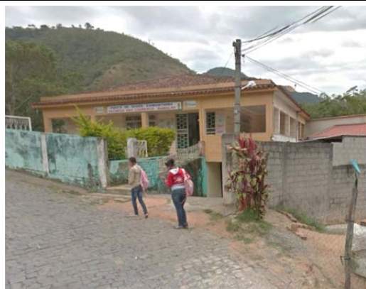
Foto 13: Posto de Saúde Comunitário Pacheco São Lourenço Ramalho, situado no interior do bairro Pacheco, Engenheiro Paulo de Frontin/RJ.
