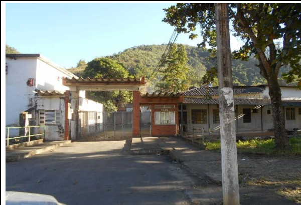
Foto 07: Entrada da antiga fábrica têxtil Maria Candida, Bairro Cascata, Paracambi RJ.
