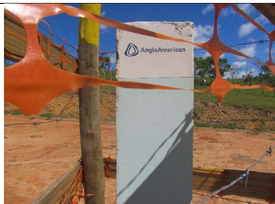
Foto 184: Dutos para escoamento de minério da empresa AngloAmerican inserido em propriedade da comunidade do Pau Ferro, Campos de Goytacazes, RJ.
