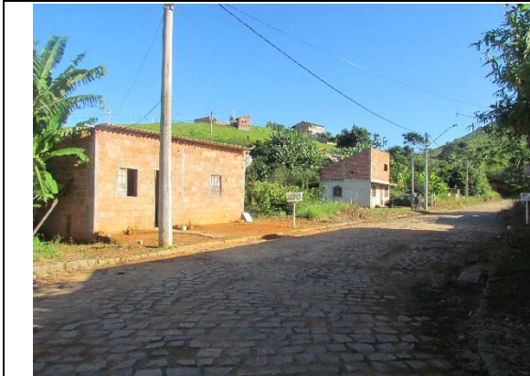
Foto 151: Moradias em construção no interior do Loteamento Paradiso, Macaé/RJ.
