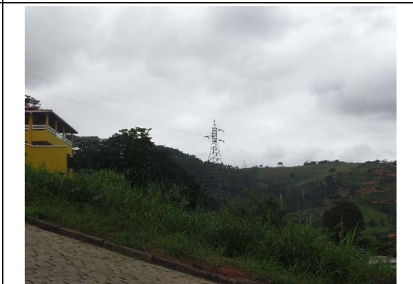
Foto 112: Linha de Transmissão existente no interior do loteamento Alpes da Serra, município de Bom Jardim, RJ.
