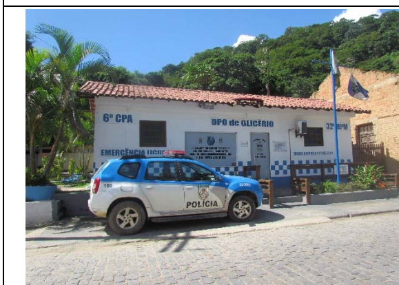
Foto 147: Unidade Policial situada no Distrito do Glicério, Macaé/RJ.
