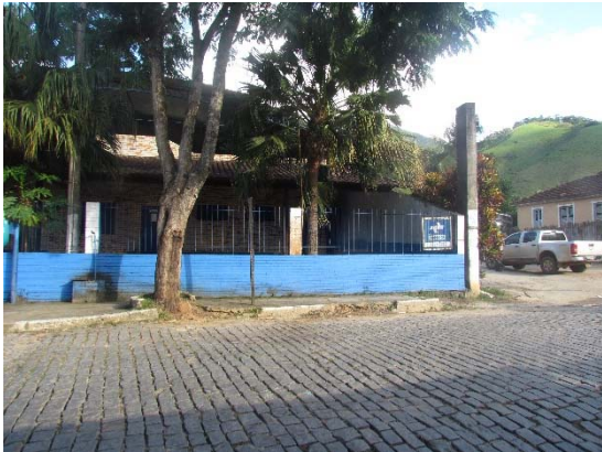
Foto 133: Unidade escolar e correios, existentes no Distrito do Frade, Macaé/RJ.
