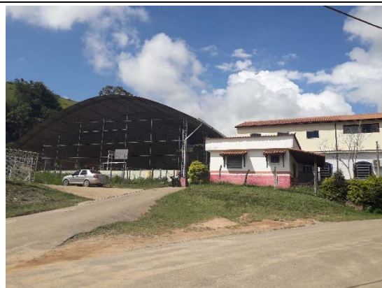
Foto 38: Escola Municipal Manoel Rodrigues, que atende ensino fundamental e médio em Coqueiros, Paty dos Alferes/RJ.
