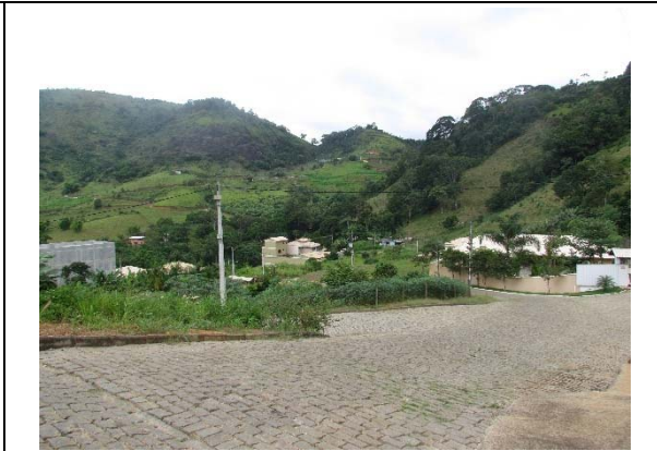
Foto 108: Vista do loteamento Alpes da Serra, município de Bom Jardim, RJ.
