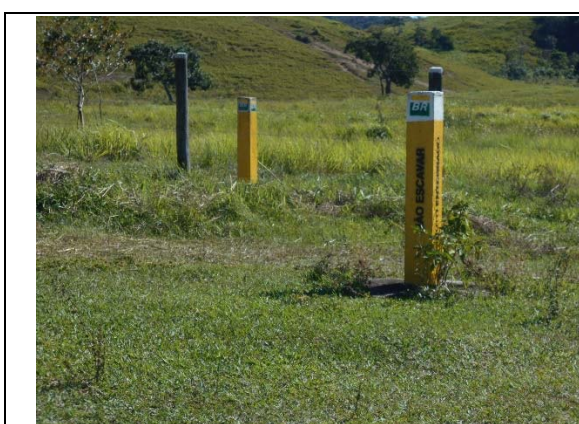
Foto 129: Gasoduto que intercepta o bairro Califórnia, Rio das Ostras/RJ
