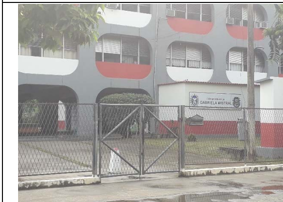
Foto 53: Centro Integrado de Educação Pública (CIEP) Brizolão existente no Distrito de Posse, Petrópolis/RJ.
