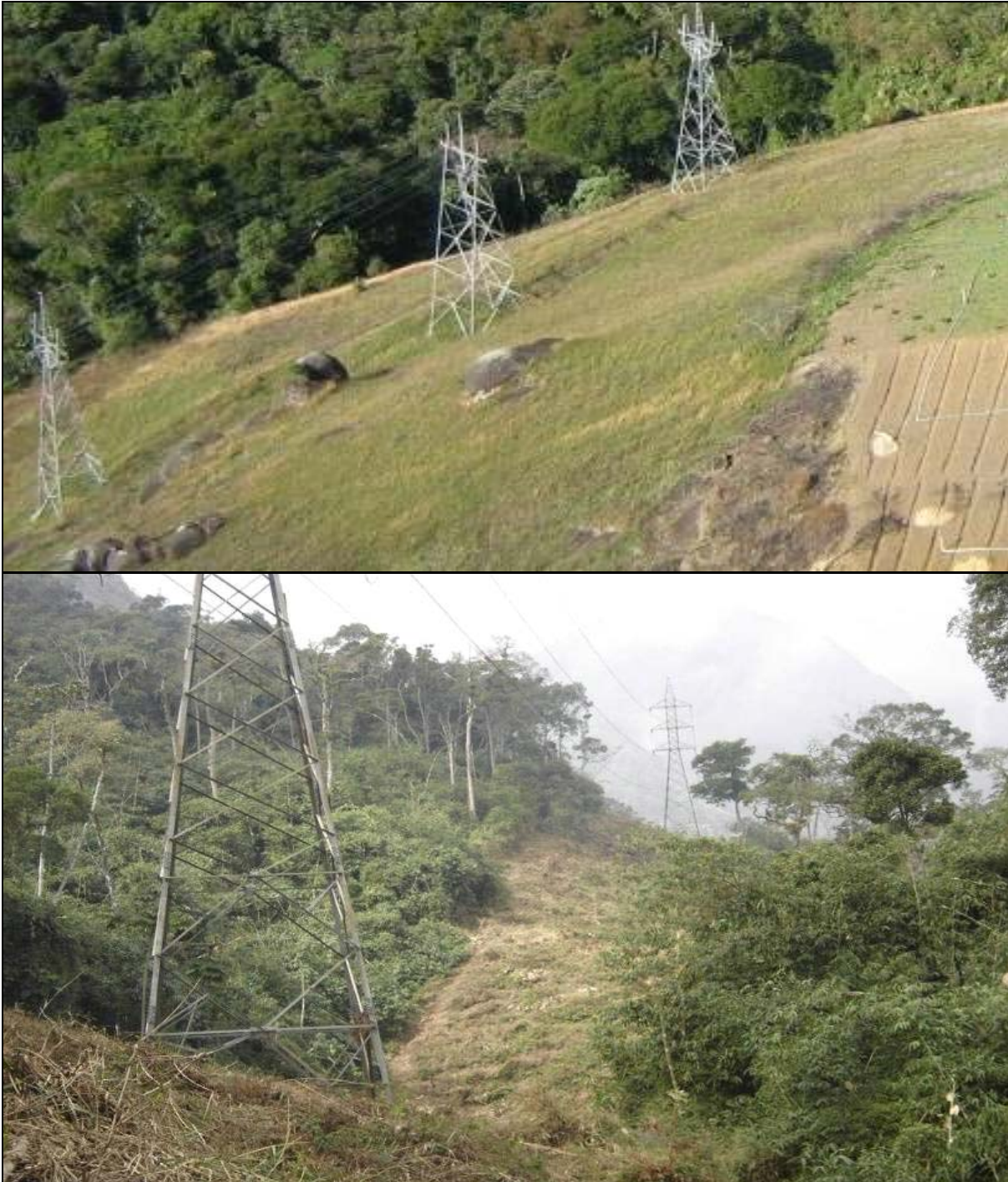
Figura 5.3-1 – Exemplos de Torre Implantada em Encosta: Pernas com Diferentes Alturas
