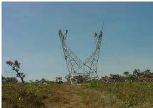
Foto 10-23 – Continuidade da montagem de torre autoportante desde a base.
