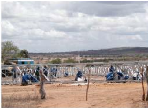
Foto 10-21 – Montagem de torres.
