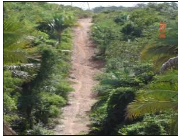
Foto 10-10 – Abertura da faixa de 5m de largura, observando-se o corte seletivo de vegetação realizado.
