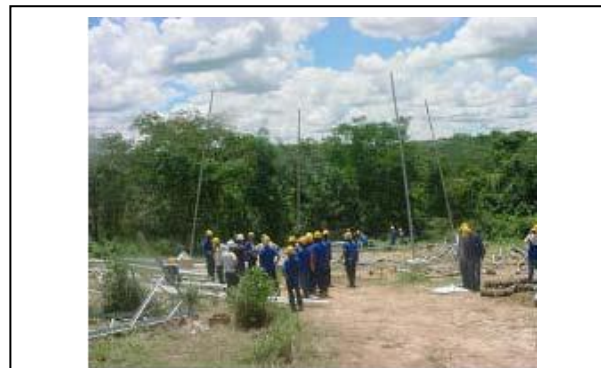
Foto 10-20 – Continuação de montagem de torre autoportante.
