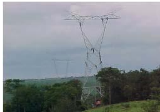
Foto 10-24 – Continuidade do processo de montagem de torre autoportante.
