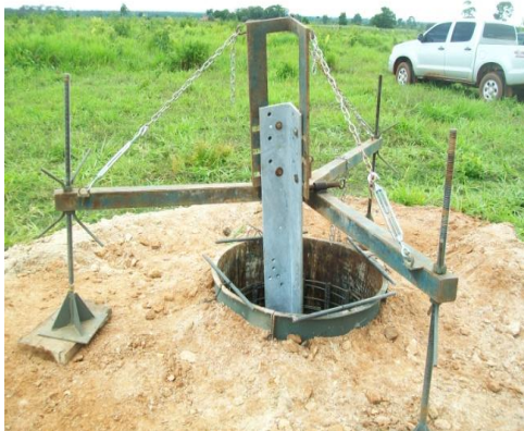
Foto 10-15: Fundação já preparada para concretagem com stub nivelado na forma
