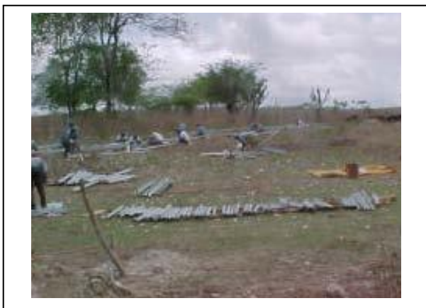
Foto 10-17 – Início do processo de montagem de torre.
