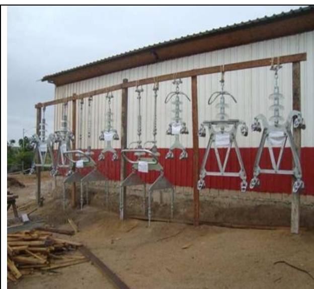
Foto 10-25 – Pré-montagem no canteiro
