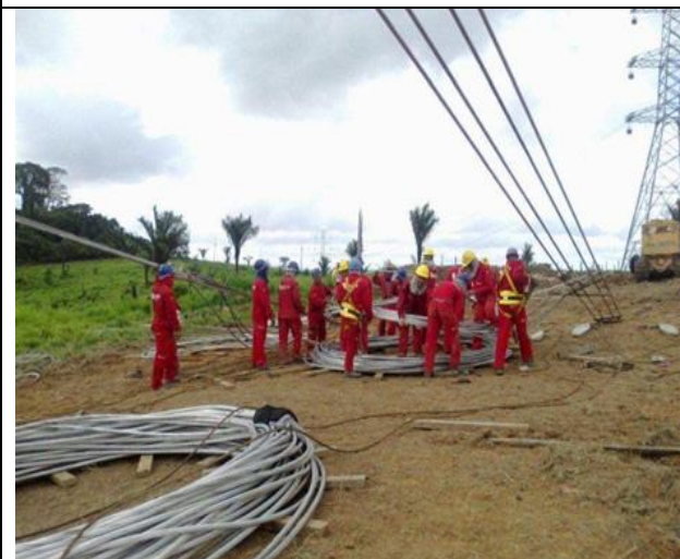
Foto 10-27 – Lançamento de cabos
