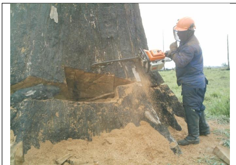
Foto 6-3 – Uso da motosserra durante a abertura da faixa de serviço (outra LT).
