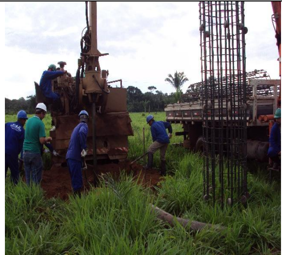
Foto 10-12: Processo de colocação da ferragem
