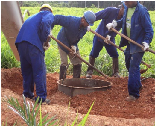
Foto 10-13: Processo de adequar a forma
