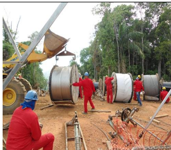
Foto 10-28 – Lançamento de cabos
