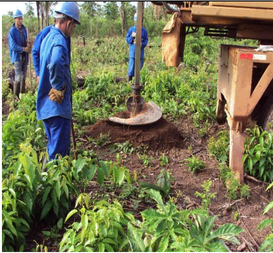
Foto 10-11: Processo de escavação fundação
