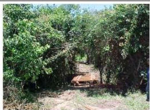
Foto 10-5 – Ponte provisória para evitar danos ao curso de água.
