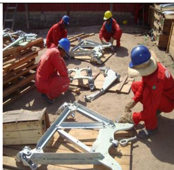
Foto 10-26 – Pré montagem no local
