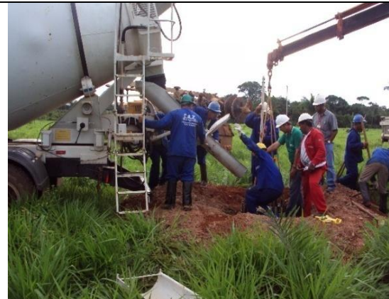
Foto 10-14: Concretagem da fundação – utilização de caminhão betoneira
