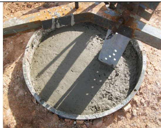
Foto 10-16: Concreto molhado sendo regularizado na forma para secagem
