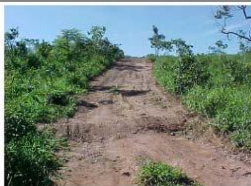
Foto 10-2 – Mulundum instalado, com objetivo de dissipar a energia da água no acesso, evitando processos erosivos.
