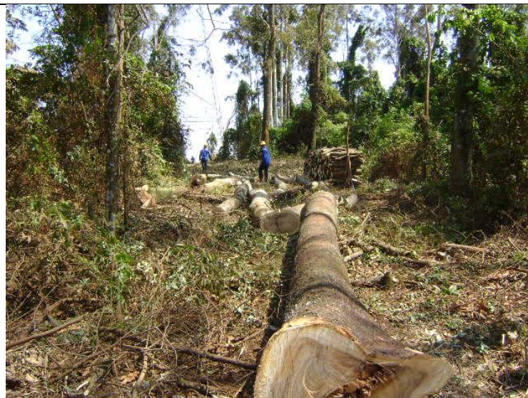
Foto 6-4 – Tombamento adequado de árvores para dentro da faixa de serviço. Fonte: RPTE/BIODINÂMICA, 2009 (outra LT).
