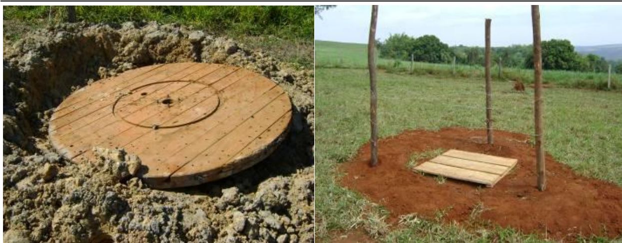
Figura 8-9 – Isolamento da cava, utilizando-selateral de bobina (à esquerda) e cerca de arame e tampa de madeira (à direita)
