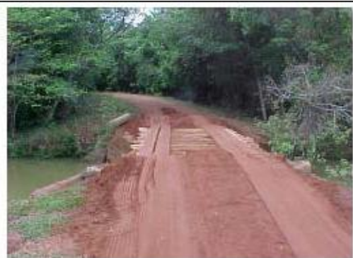
Foto 10-1 – Ponte construída no acesso, permitindo o curso d'água fluir naturalmente.
