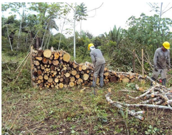
Foto 6-7 – Empilhamento de madeira no limite externo da faixa de serviço. Fonte: MTE/BIODIONÂMICA RIO, 2011 (outra LT).
