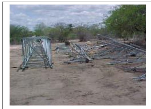
Foto 10-18 – Continuação do processo de montagem de torre no solo.
