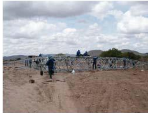
Foto 10-22 – Processo de montagem de torres.
