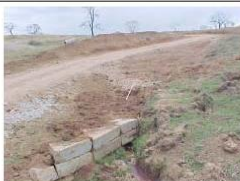
Foto 10-6 – Dispositivo de contenção utilizado em acesso, para fins de controle de processos erosivos.
