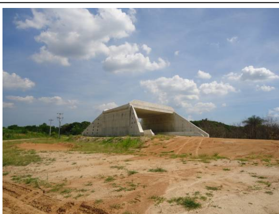
Foto II.4.4.5-23 – Obras do Arco Rodoviário Metropolitano, na Gleba Santa Alice – município de Seropédica (RJ)
