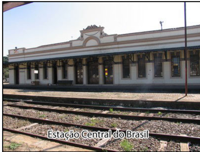
Foto II.4.4.7-10 – Estação Central do Brasil, em Pindamonhangaba (SP) Fonte: www.pindamonhangaba.sp.gov.br
