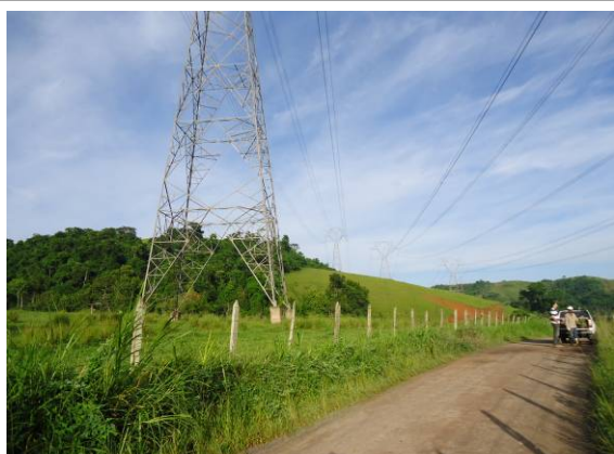
Foto II.4.4.5-55 – Vista do paralelismo das LTs existentes – município de Barra Mansa (RJ).
