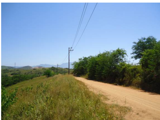
Foto II.4.4.5-49 – Cruzamento da Estrada da Granja (não pavimentada) com LT do Seccionamento Adrianópolis – Jacarepaguá (AD-JA), município de Nova Iguaçu (RJ)
