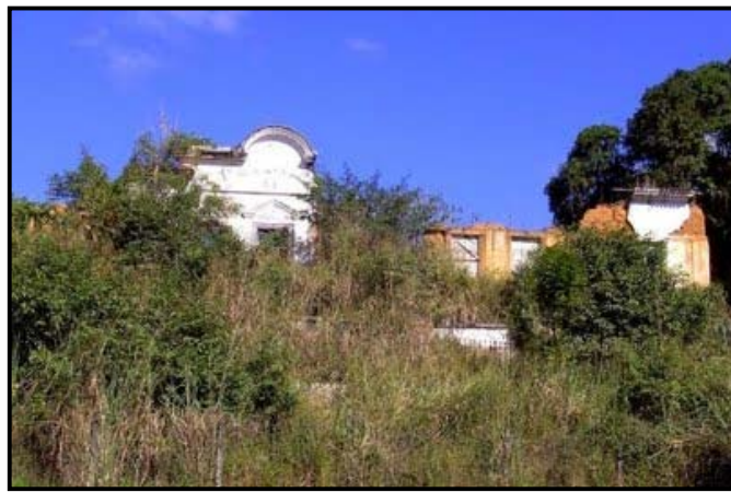
Foto II.4.4.7-97 – Sede da Fazenda Pinheiro, atualmente em ruínas, em Pinheiral (RJ) Fonte: www.pinheiralrj.br.tripod.com
