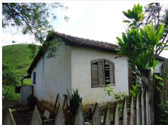
Foto II.4.4-13 – Padrão construtivo na localidade Cafarnaum – município de Barra Mansa (RJ).
