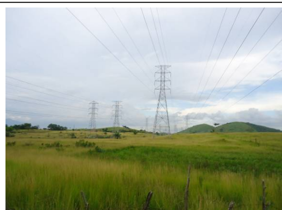
Foto II.4.4.5-60 – Cruzamento entre LTs visto da estrada vicinal da Gleba Coletivo no PA Moura Costa – município de Seropédica (RJ).
