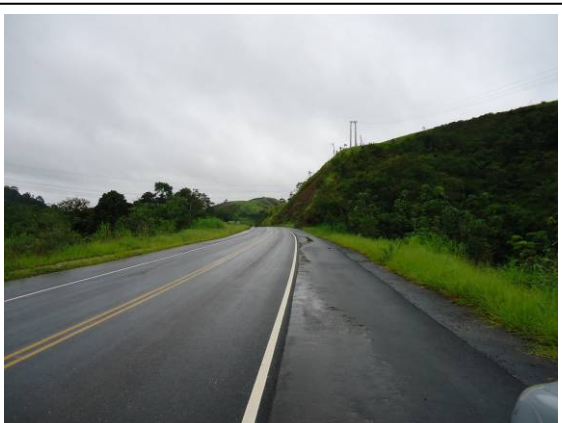
Foto II.4.4.5-35 - Cruzamento com a Rodovia Paulo Virgínio (SP-171), pavimentada – município de Guaratinguetá (SP)
