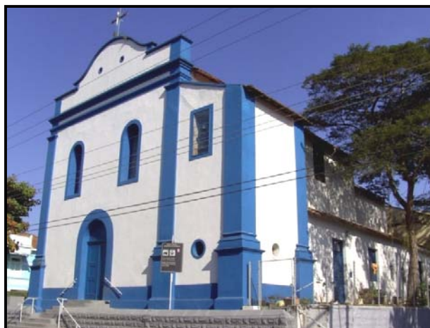
Foto II.4.4.7-77 – Igreja do Rosário, em Resende (RJ).
