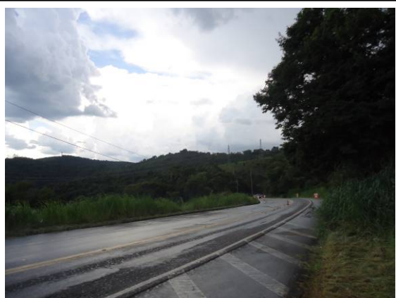
Foto II.4.4.5-33 – Cruzamento com a Rodovia Oswaldo Cruz (SP-125), no município de Taubaté. Pavimentada, acessa os municípios de Lagoinha, Ubatuba e São Luiz do Paraitinga, entre outros
