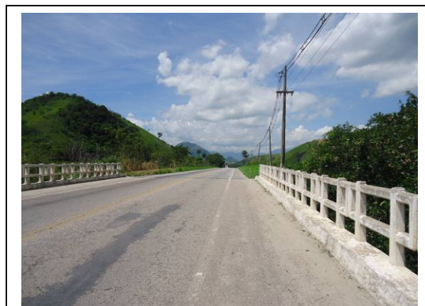
Foto II.4.4.5-46 – Cruzamento com a Rodovia RJ-125 – município de Seropédica (RJ)
