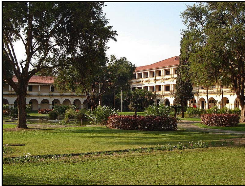
Foto II.4.4.7-108 – Prédio P1 da UFRRJ, em Seropédica (RJ). Fonte: www.wikipedia.org
