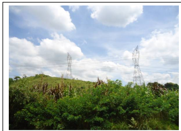
Foto II.4.4.5-62 - Cruzamento entre LTs – município de Nova Iguaçu (RJ).
