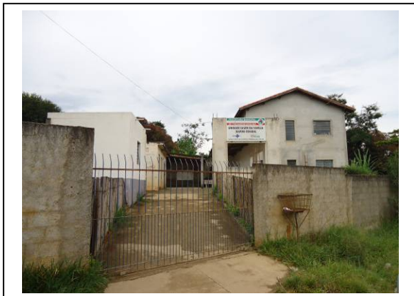
Foto II.4.4.2-1 – Unidade de Saúde da Família do Bairro Goiabal – município de Pindamonhangaba (SP).
