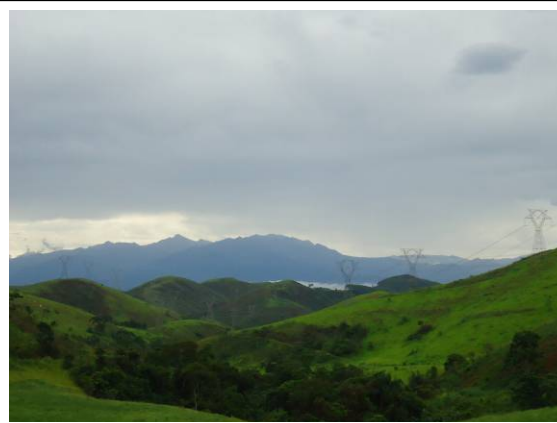
Foto II.4.4.5-54 – Vista do paralelismo das LTs existentes – município de Resende (RJ)
