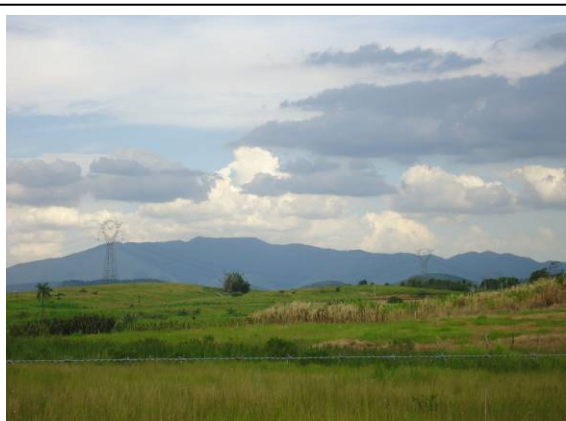
Foto II.4.4.5-59 – Vista do paralelismo das LTs existentes na estrada vicinal do Bairro Santa Alice – município de Seropédica (RJ).
