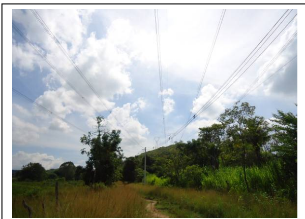
Foto II.4.4.5-61 - Vista do paralelismo das LTs existentes e do cruzamento com a Estrada Casa Nova (não-pav. a 200m) – município de Nova Iguaçu (RJ).
