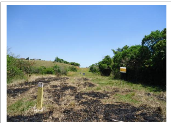
Foto II.4.4.5-67 - Cruzamento da Estrada Boa com faixa de dutos, sendo que a diretriz cruzará a faixa de dutos a 210m; os seccionamentos ZO-GR e AR-SJ cruzarão a faixa de dutos a 180m; e o seccionamento AD-JA cruzará a faixa de dutos a 320m – município de Nova Iguaçu (RJ).
