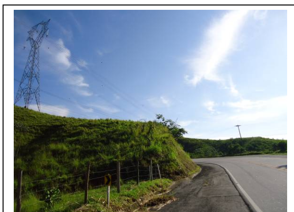
Foto II.4.4.5-40 – Cruzamento com a Rodovia Pres. Getúlio Vargas (RJ-155), pavimentada – município de Barra Mansa (RJ)
