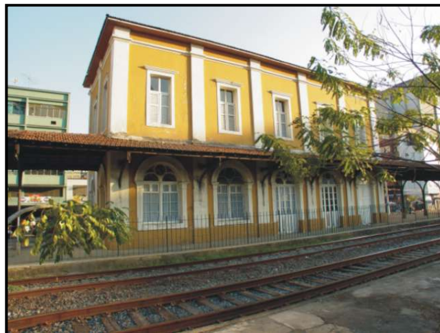
Foto II.4.4.7-84 – Estação Ferroviária, em Barra Mansa (RJ) . Fonte: www.inepac.rj.gov.br
