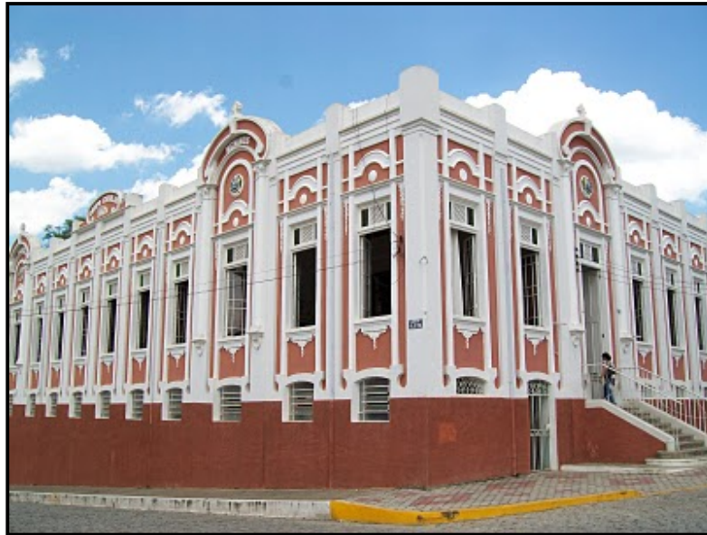
Foto II.4.4.7-62 – Prédio do Grupo Escolar, em Queluz (SP) Fonte: www.portalqueluz.blogspot.com
