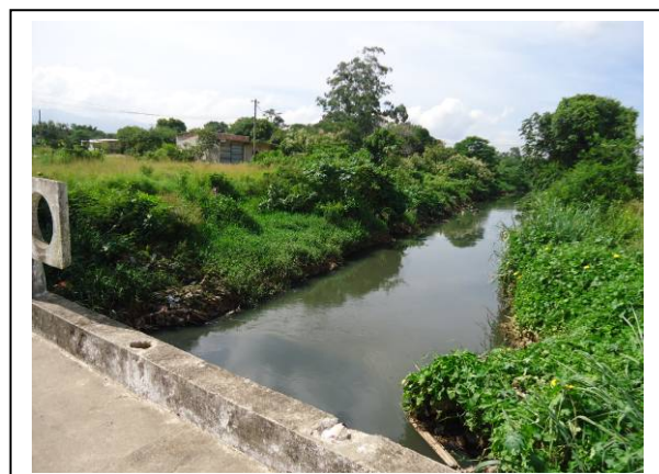
Foto II.4.4.2-15 – Esgoto lançado in natura na bacia do rio Guandu, entre as Glebas Acampamento e Fazendinha - divisa municipal de Queimados (RJ) e Nova Iguaçu (RJ).
