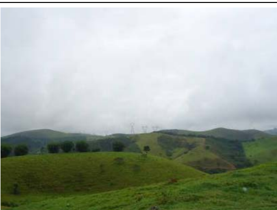
Foto II.4.4.5-53 – Vista do paralelismo das LTs existentes na Estrada da Jararaca – município de Guaratinguetá (SP)
