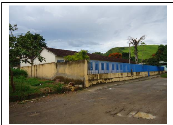
Foto II.4.4.2-9 – Escola Estadual Municipalizada de Rialto, no distrito de Rialto – município de Barra Mansa (RJ).
