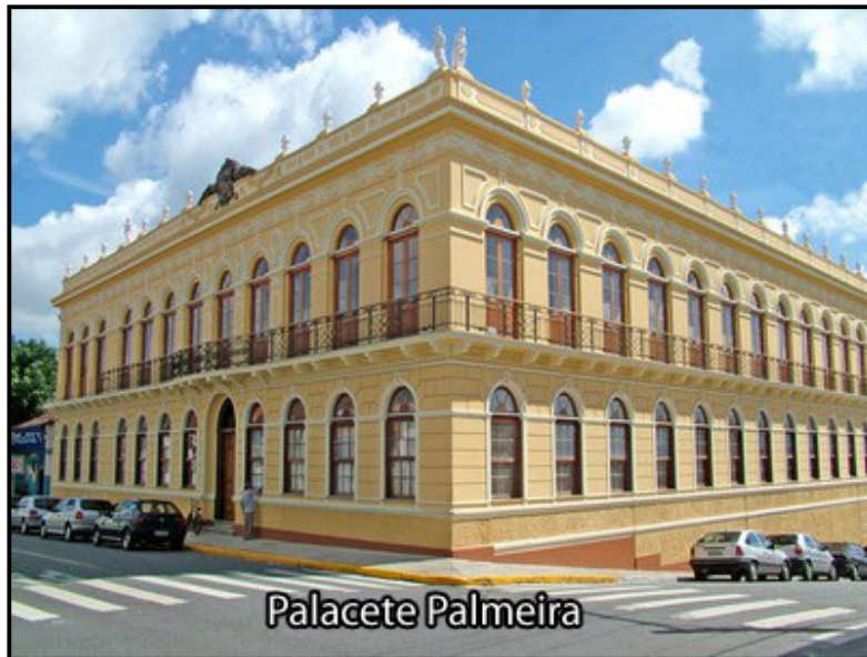
Foto II.4.4.7-14 – Palacete Palmeira, em Pindamonhangaba (SP) Fonte: www.pindamonhangaba.sp.gov.br .
