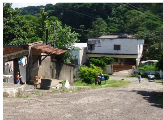
Foto II.4.4-14 – Padrão construtivo na localidade Jardim Redentor – município de Barra Mansa (RJ).
