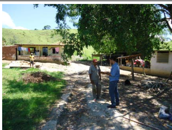
Foto II.4.4-15 – Tipo de padrão construtivo no Assentamento Mutirão da Paz (posseiros) – município de Pinheiral (RJ).
