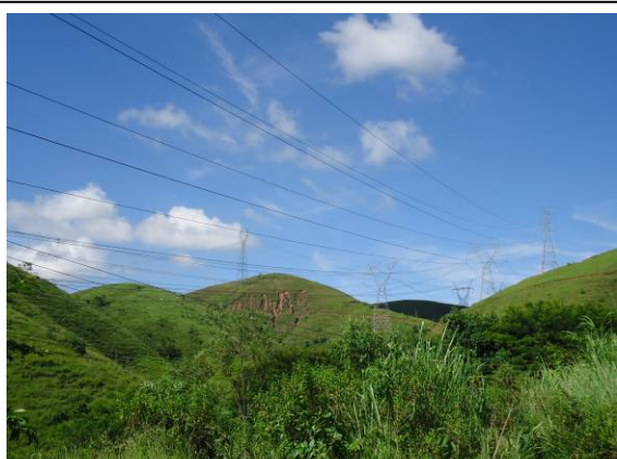
Foto II.4.4.5-57 – Vista do paralelismo das LTs existentes no Bairro Jardim Redentor – município de Barra Mansa (RJ).
