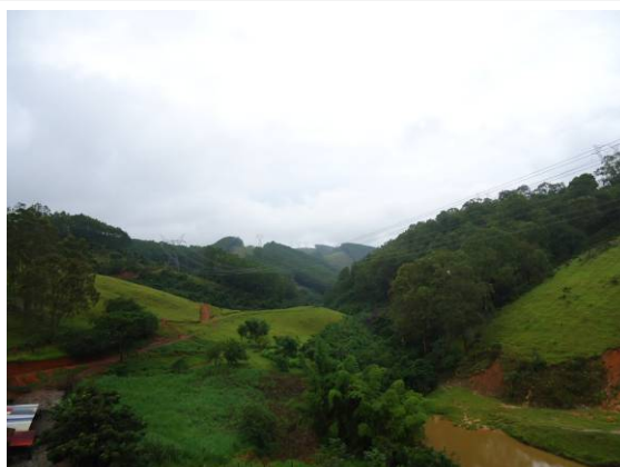
Foto II.4.4.5-52 – Vista do paralelismo das LTs – município de Guaratinguetá (SP)
