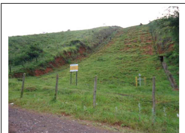
Foto II.4.4.5-65 - Cruzamento com a faixa de dutos da PETROBRAS – Barra Mansa (RJ).
