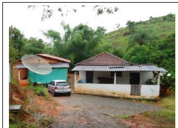
Foto II.4.4-8 – Padrão construtivo na vila sem nome – município de Guaratinguetá (SP).
