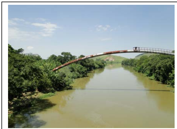
Foto II.4.3.4.5-73 – Rio Guandu, sob a ponte da Rodovia Presidente Dutra, município de Japeri (RJ)
