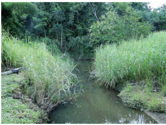
Foto II.4.3.4.5-57 – Riacho sob ponte da Rodovia Presidente Dutra em P30, município de Volta Redonda (RJ)
