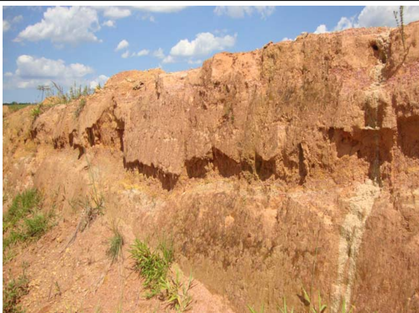
Foto II.4.2.4-6 – Talude de corte em sedimentos da Formação Pindamonhangaba (unidade geotécnica Sedimentar, arenitos e argilitos), com comportamento geotécnico condicionado por horizontes distintos de argilito e arenito
