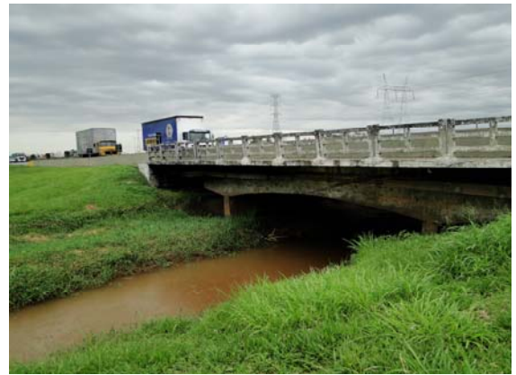
Foto II.4.3.4.5-16 – Riacho sob ponte na Rodovia Presidente Dutra em P10, município de Roseira (SP)
