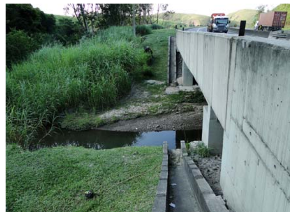
Foto II.4.3.4.5-56 – Riacho sob ponte da Rodovia Presidente Dutra em P30, município de Volta Redonda (RJ)
