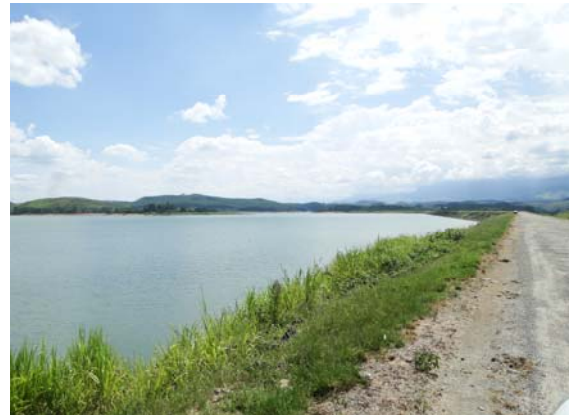
Foto II.4.3.4.5-48 – Represa do Funil, ponto em cima do dique de drenagem em P26, município de Itatiaia (RJ)
