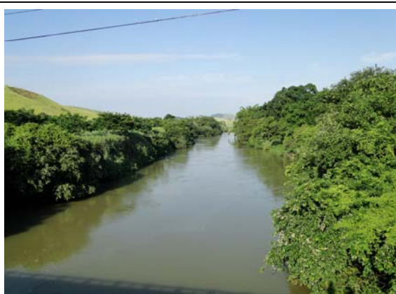
Foto II.4.3.4.5-65 – Ribeirão das Lajes, sob a ponte na estrada da Dutra para Paracambi em P34, município de Paracambi (RJ).
