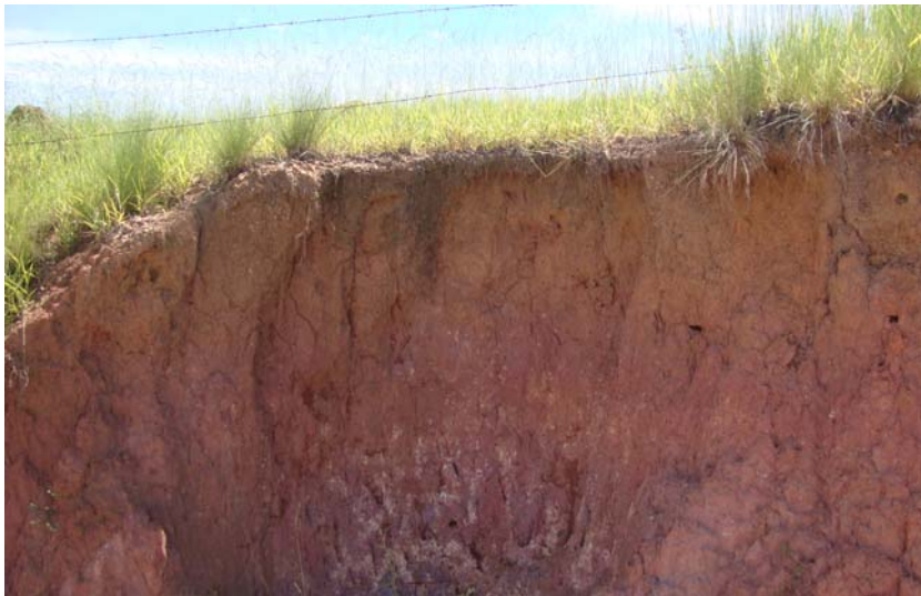
Foto II.4.2.4-5 – Vista dos terrenos junto à Subestação Taubaté, sobre sedimentos da Sequência Pindamonhangaba. No loteamento ao fundo, os cortes em solo residual e sedimento apresentam boas condições de estabilidade
