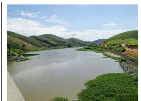
Foto II.4.3.4.5-37 – Rio Paraíba do Sul sob a ponte da Rodovia Presidente Dutra em P21, município de Lavrinhas (SP)
