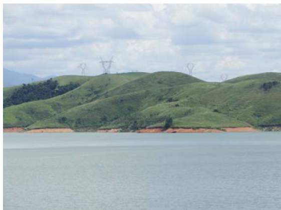
Foto II.4.3.4.5-49 – Represa do Funil, ponto em cima do dique de drenagem em P26, município de Itatiaia (RJ)
