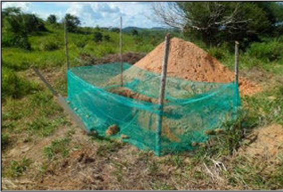
Figura 10.2.7-10 - Foto ilustrativa de uma cerca de proteção para evitar a queda de animais na cava.
