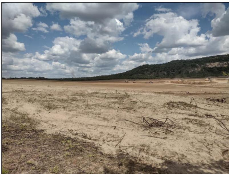
Foto 6.3.2-9 – Um dos fatores de pressão. Área recém suprimida para implantação de usina fotovoltaica. Foto tirada na coordenada: 725480 / 9239240 dia 14/01/2022.
