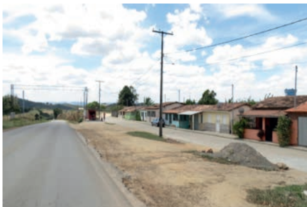
Foto 4.4-36 : Instalação de antenas de TV em Laje.
