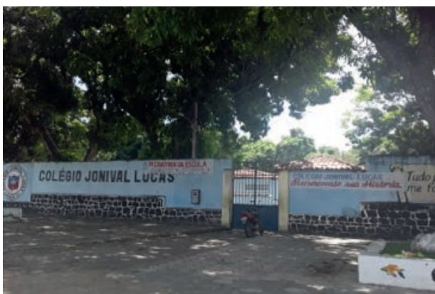
Foto 4.4-32: Instalações de colégio estadual em Sapeaçu.
