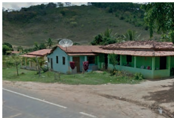
Foto 4.4-98: Outro padrão construtivo na mesma localidade, aqui virada para a BR – 420 em Ubaíra. Coordenada:
