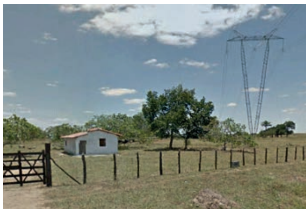
Foto 4.4-108: Ponto de paralelismo da futura LT com outras LTs já instaladas, na margem da BR – 242 em Sapeaçu. Coordenada: 12°43'31.82"S / 39°12'19.60"O.
