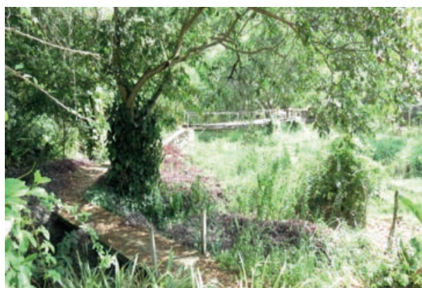
Foto 4.4-44: Instalações do Balneário Horto Maria Flor em Jiquiriçá.
