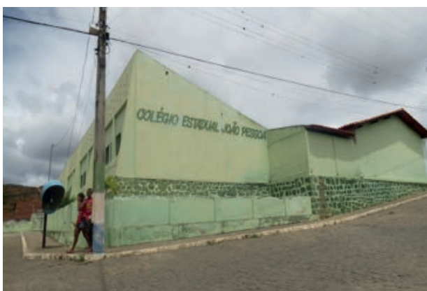
Foto 4.4-30: Instalações de colégio estadual em Itaquara.
