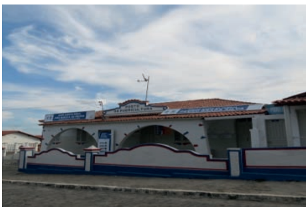
Foto 4.4-14: Instalações do Posto de Saúde Central de Poções.
