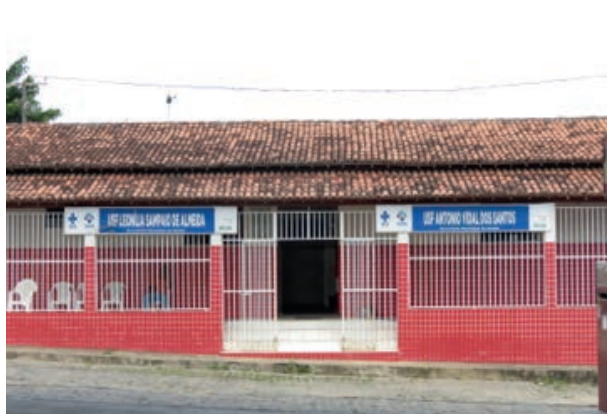
Foto 4.4-17: Instalações da Unidade de Saúde Familiar de Laje.
