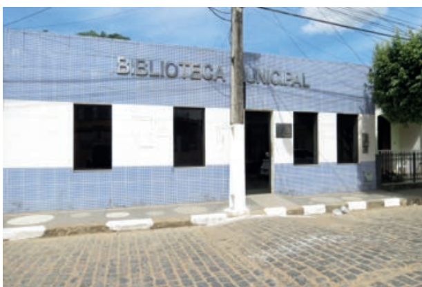
Foto 4.4-45: Instalações Biblioteca Municipal em Jiquiriçá.
