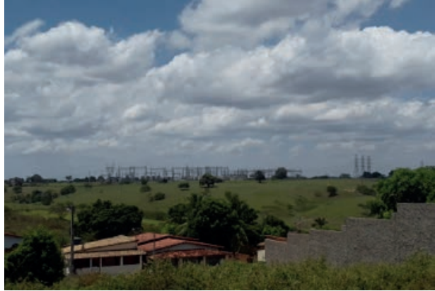
Foto 4.4-34: Subestação de energia elétrica em Sapeaçu.
