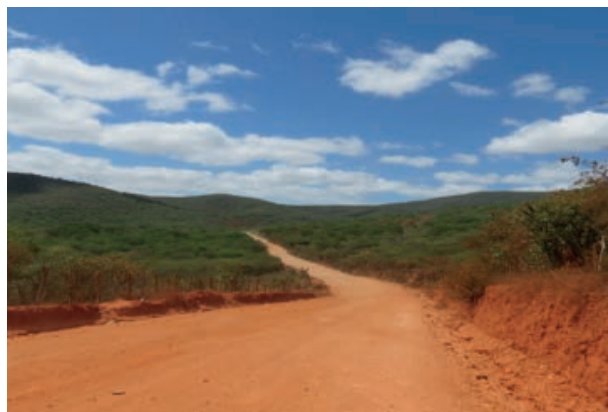
Foto 4.4-5: BA de acesso à LT no município de Manoel Vitorino.
