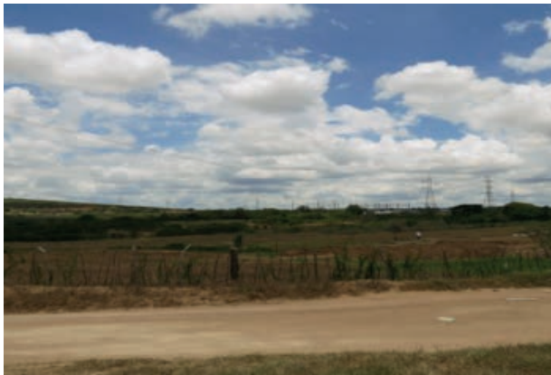
Foto 4.4-74: Panorama da Subestação Poções II, com destaque para a área de plantio e mata nativa.
