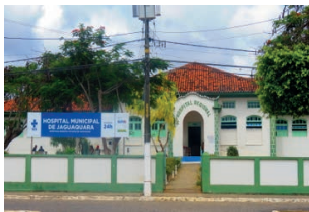
Foto 4.4-21: Instalações do Hospital Municipal de Jaguaguara.
