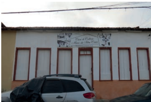
Foto 4.4-47: Instalações da Casa da Cultura em Cravolândia.
