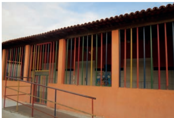
Foto 4.4-29: Instalações de estabelecimento pré-escolar em Cravolândia.
