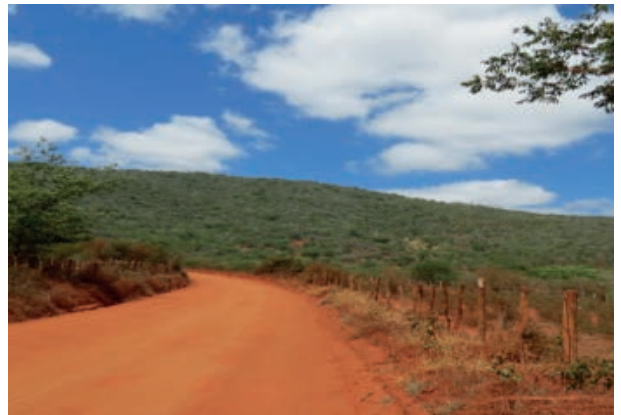
Foto 4.4-85: Estrada vicinal de acesso a LT em Manoel Vitorino. Coordenadas: 14°11'2.47"S/40°17'20.88"O.
