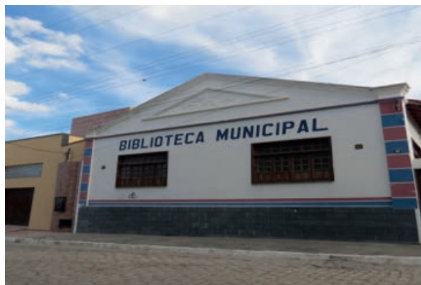
Foto 4.4-42: Instalação da Biblioteca Municipal de Poções.
