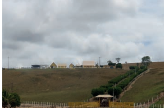
Foto 4.4-92: Exemplo de construção rural de médio porte em Jaguaquara.
