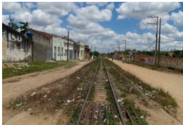
Foto 4.4-13: Condições do eixo da Linha e entorno.
