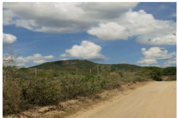
Foto 4.4-77: Cruzamento do eixo principal da LT em Boa Nova, com uma rede de baixa tensão na zona rural. Coordenada: 14°22'40.29"S/ 40°21'16.60"O.
