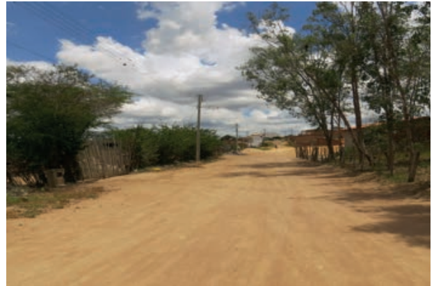
Foto 4.4-73: Via de acesso, ocupações sociais e instalações do entorno direto da Subestação Poções II.
