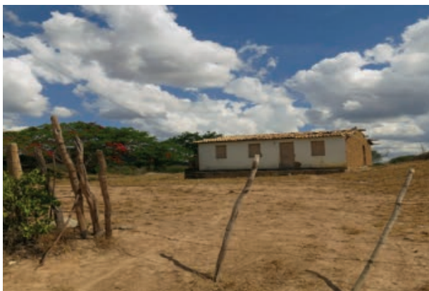
Foto 4.4-76: Instalação residencial há poucos metros do eixo principal da LT em Boa Nova. Coordenada: 14°22'40.29"S/ 40°21'16.60"O.
