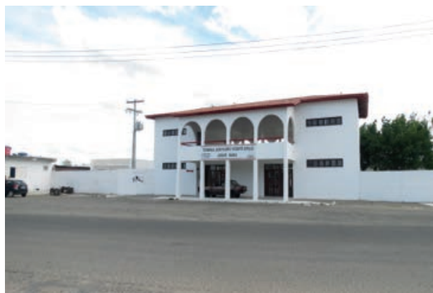
Foto 4.4-10: Instalações do Terminal Aeroviário Vicente Grillo em Jequié.
