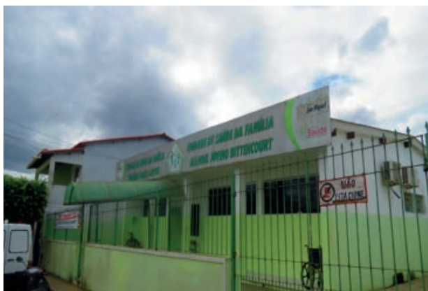
Foto 4.4-22: Instalações da Unidade de Saúde da Família de São Miguel das Matas.
