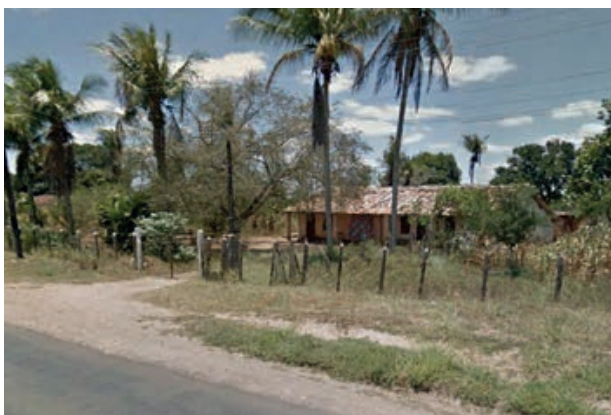
Foto 4.4-107: Aspectos construtivos de residências na AID no município de Sapeaçu, BR – 242. Coordenada: 12°43'26.48"S / 39°12'23.52"O.
