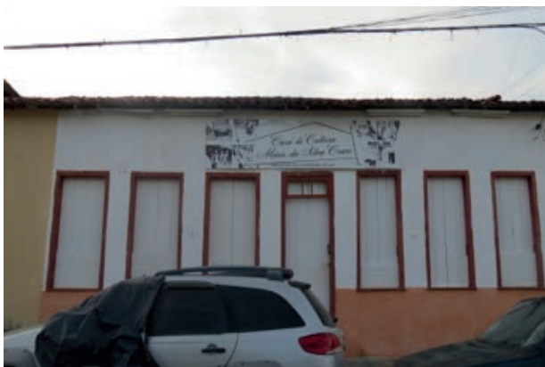
Foto 4.4-47: Instalações da Casa da Cultura em Cravolândia.
