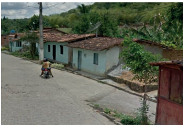
Foto 4.4-103: Tipo de construção residencial no acesso direto à LT em Jiquiriçá. Coordenada: 13°15'17.99"S / 39°35'3.77"O.
