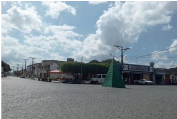
Foto 4.4-33: Sistema de Iluminação Pública em Conceição do Almeida.
