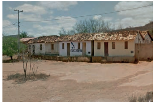
Foto 4.4-81: Exemplo de instalação residencial na área de aproximação da BR – 116.
