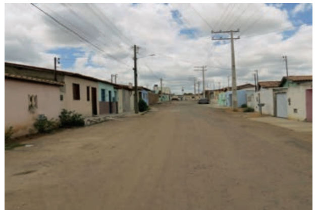
Foto 4.4-70: Infraestruturas e condições de ocupação do entorno direto da Subestação de Poções.
