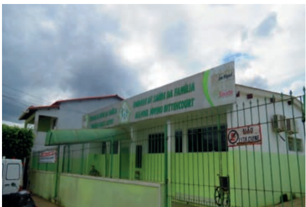
Foto 4.4-22: Instalações da Unidade de Saúde da Família de São Miguel das Matas.
