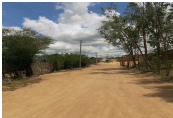
Foto 4.4-73: Via de acesso, ocupações sociais e instalações do entorno direto da Subestação Poções II.
