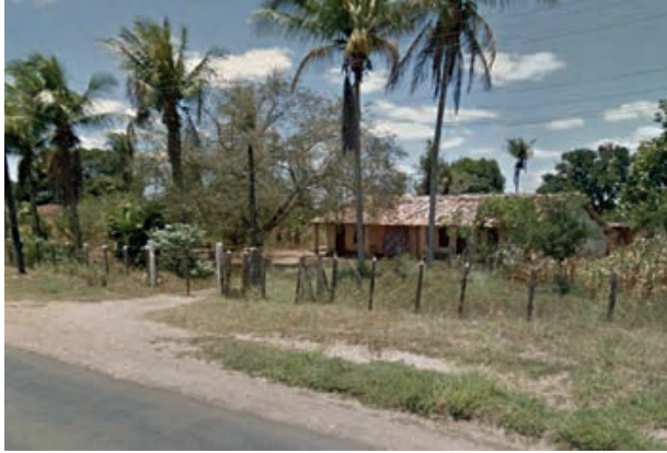
Foto 4.4-107: Aspectos construtivos de residências na AID no município de Sapeaçu, BR - 242. Coordenada: 12°43'26.48"S / 39°12'23.52"O.
