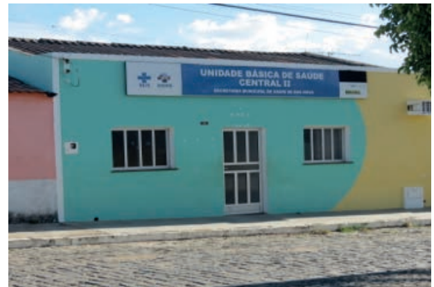
Foto 4.4-15: Instalações da Unidade de Básica de Saúde, fechada, em Boa Nova.
