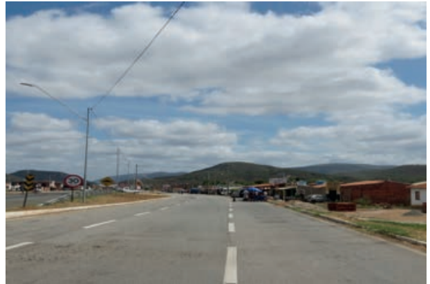
Foto 4.4-2: Sinalização de velocidade da BR 116 na sede municipal de Manoel Vitorino.
