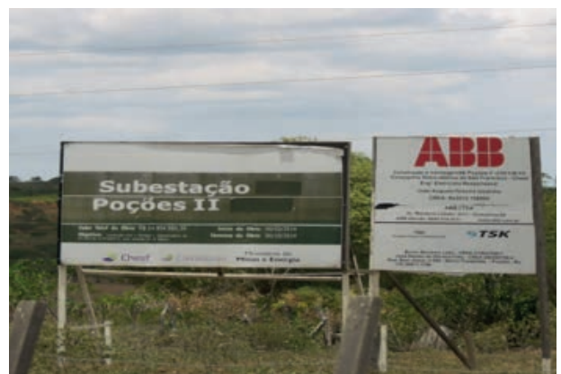
Foto 4.4-71: Entrada da Subestação Poções II – próxima a futura SE Poções III.
