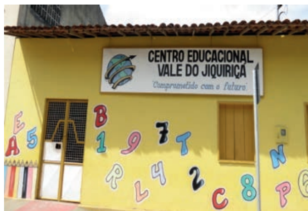
Foto 4.4-27: Estrutura de centro educacional pré-escolar em Jiquiriçá.
