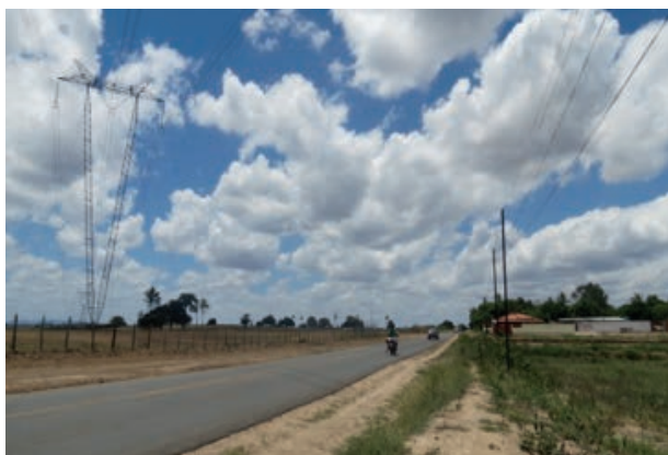
Foto 4.4-35: Linhão de distribuição de energia na rodovia de acesso à Sapeaçu.
