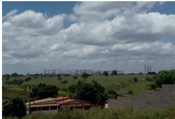
Foto 4.4-34: Subestação de energia elétrica em Sapeaçu.
