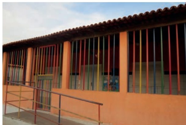
Foto 4.4-29: Instalações de estabelecimento pré-escolar em Cravolândia.
