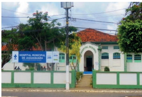
Foto 4.4-21: Instalações do Hospital Municipal de Jaguaguara.
