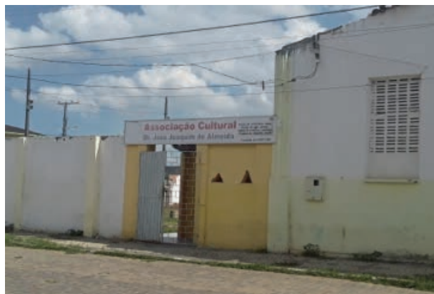
Foto 4.4-48: Instalações Associação Cultural de Conceição do Almeida.
