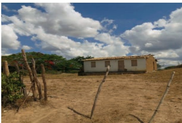
Foto 4.4-76: Instalação residencial há poucos metros do eixo principal da LT em Boa Nova. Coordenada: 14°22'40.29"S/ 40°21'16.60"O.
