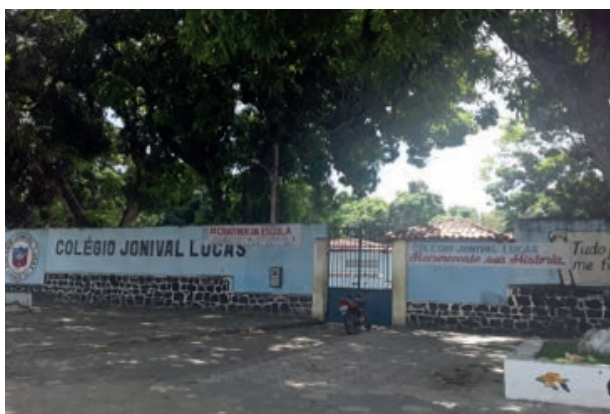
Foto 4.4-32: Instalações de colégio estadual em Sapeaçu.
