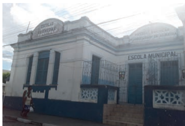
Foto 4.4-31: Instalações de colégio estadual em Conceição do Almeida.
