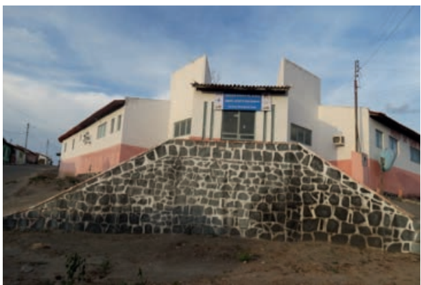
Foto 4.4-20: Instalações da Unidade Básica de Saúde de Cravolândia.
