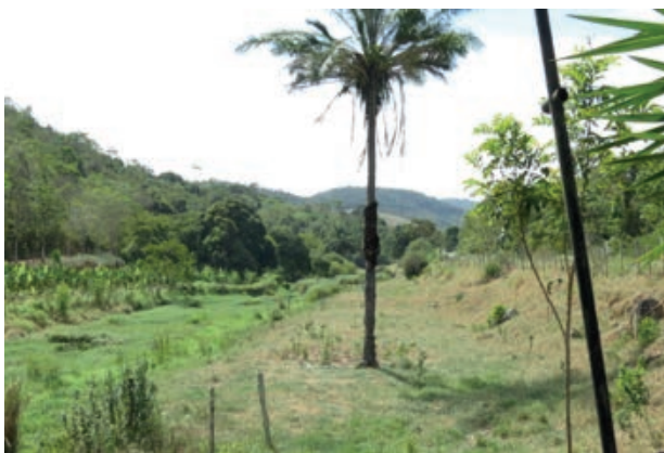
Foto 4.4-93: Intercepção da LT com a BR – 420, entre Jiquiriçá e Ubaíra. Município de Ubaíra. Coordenadas: 13°15'42.09"S / 39°36'11.91"O.
