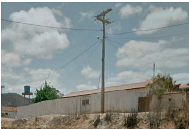
Foto 4.4-82: Instalações na Unidade Escolar Hélio Ramos na BR – 116 em Boa Nova.
