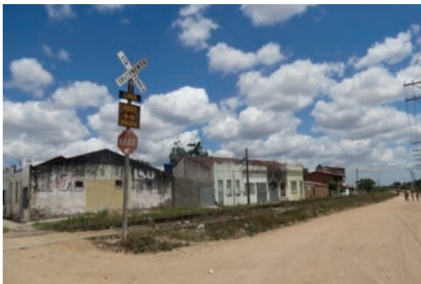
Foto 4.4-12: Sinalização da Linha Férrea.
