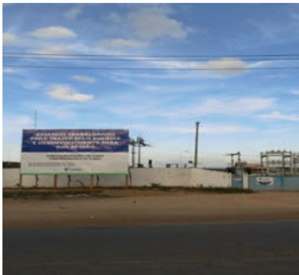
Foto 4.4-68: Subestação de Poções – rebaixamento de energia para consumo.
