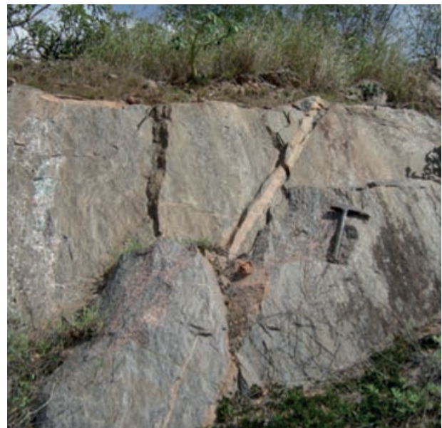
Foto 4.2-4: Gnaisses ortoderivados, com presença de diques e bastante fraturados (ao longo da BR-116). Fonte: CPRM, 2010.
