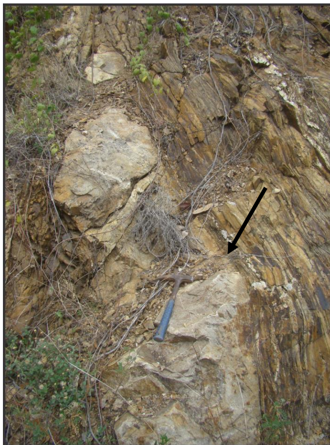
Figura 26- Detalhe do contato do granito com o xisto indicado pela seta preta.
