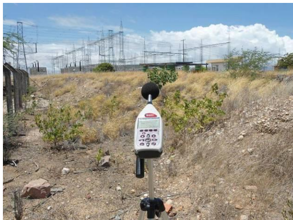
Figura 205 - PMR Canteiro Subestação São Luiz Gonzaga 2 – Medição do dia 30/01/14 das 11h22min às 11h32min.
