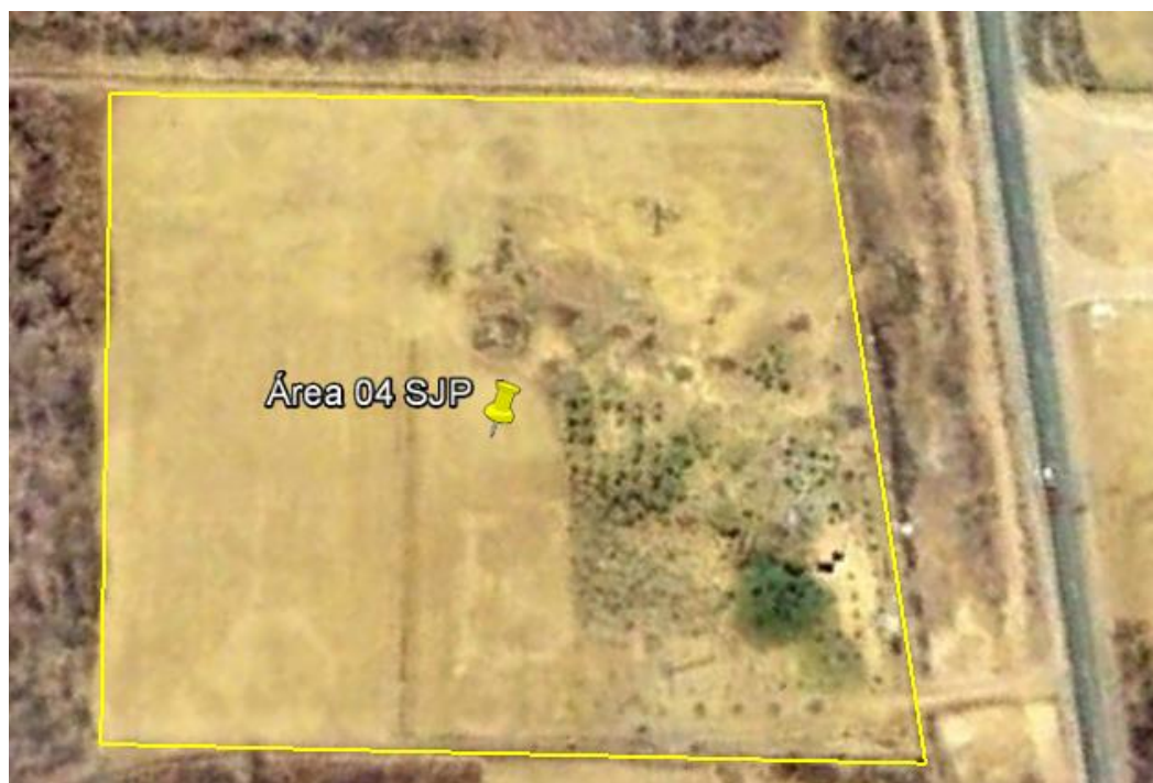
Figura 1 - Localização do canteiro de Obra "São João do Piauí 04"
