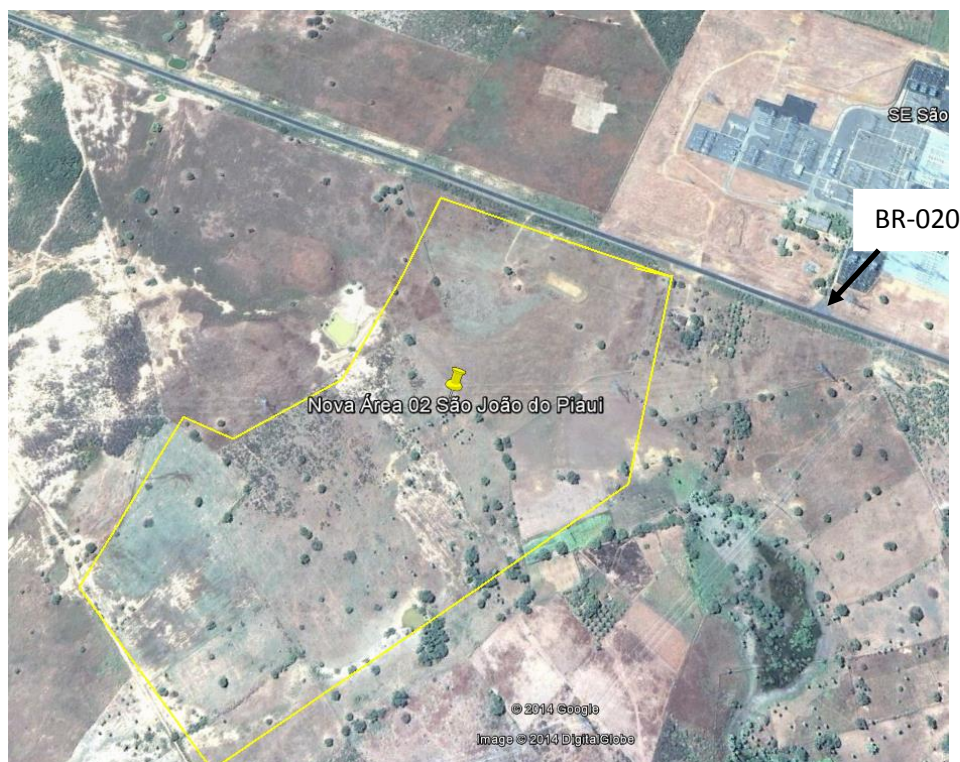
Figura 2 - Acesso ao canteiro de Obra
