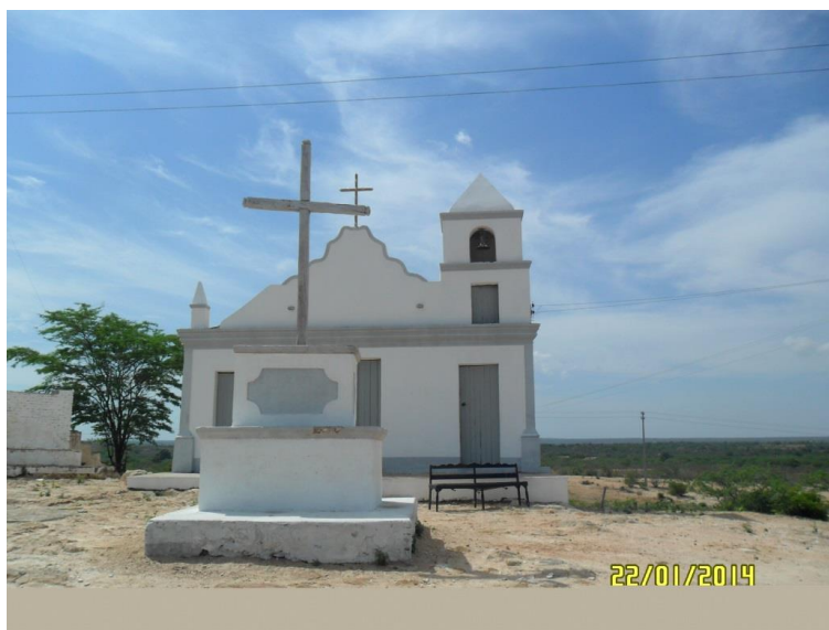
Figura 50 - Igreja da Ermida (Coordenadas: S 08° 36.257' W 038° 34.344').
