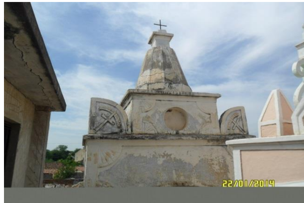
Figura 47 - Cemitério Público São Miguel (Coordenadas: S 08° 36.161' W 038° 34.474').
