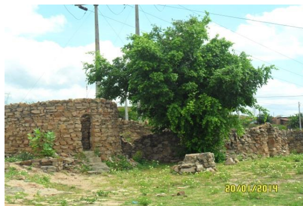
Figura 5 - Ruínas do cenário da encenação da Paixão de Cristo (Coordenadas: S 07° 18.303' W 038° 56.700').
