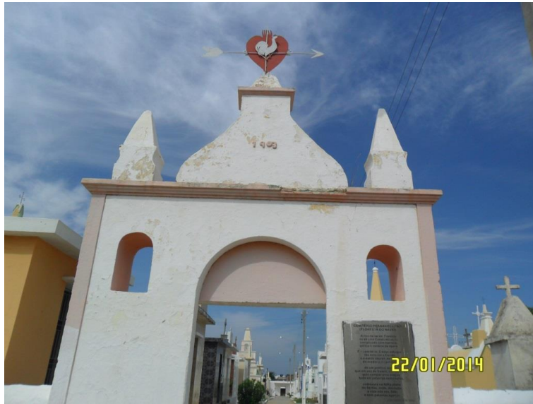
Figura 45 - Cemitério Público São Miguel (Coordenadas: S 08° 36.161' W 038° 34.474').
