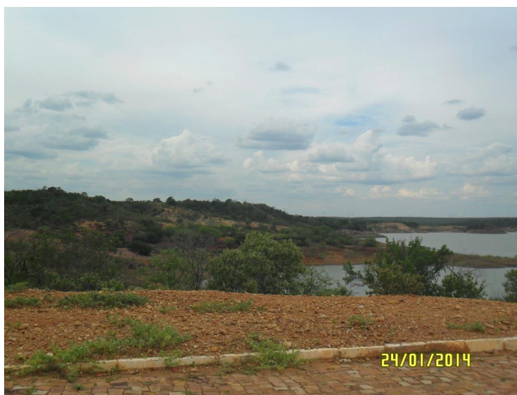
Figura 69 - Barragem Jenipapo - (Coordenadas: S 08° 27.829' W 042° 09.759').
