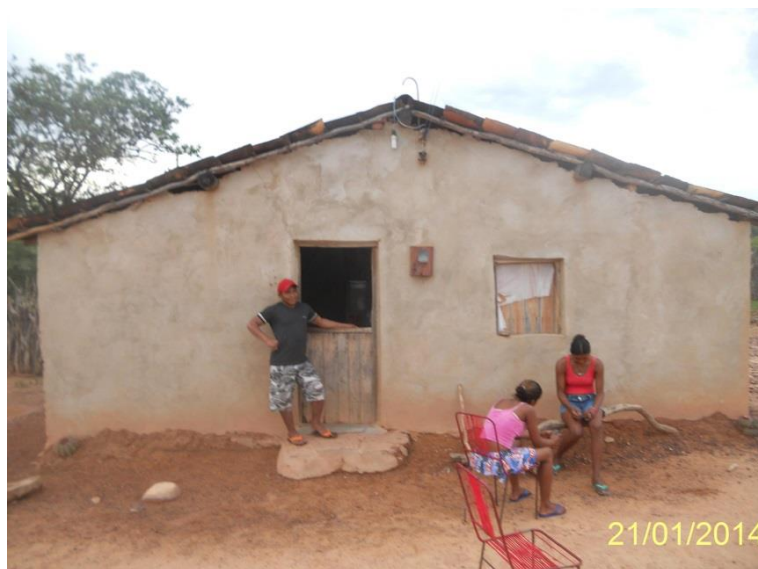
Figura 7.4-180 – Casa de morador em Riacho dos Negros/PI - Coordenadas (S08°11'26.4"/W042°17'02.3").
