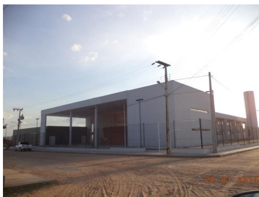
Figura 7.4-46 – Escola Técnica Estadual Profissionalizante (em fase de construção), Mauriti/CE. (Coordenadas: S 07°22'48" / W 038°46'07,1").
