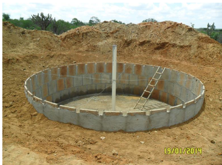
Figura 7.4-162 - Cisternão em obras. Coordenadas (S08°25'19.4" / W038°47'38.8").
