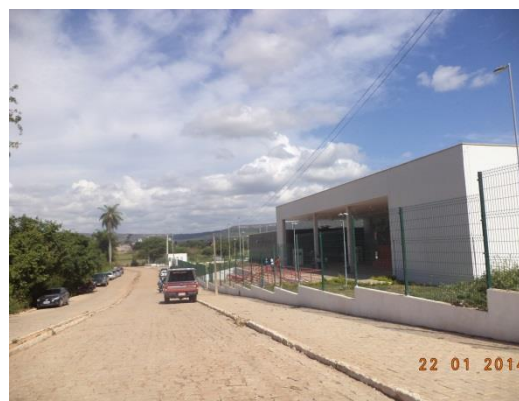
Figura 7.4-47 – Escola Técnica Estadual Profissionalizante em Jardim/CE. (Coordenadas: S 07°35'18,2" / W 039°16'34,29").
