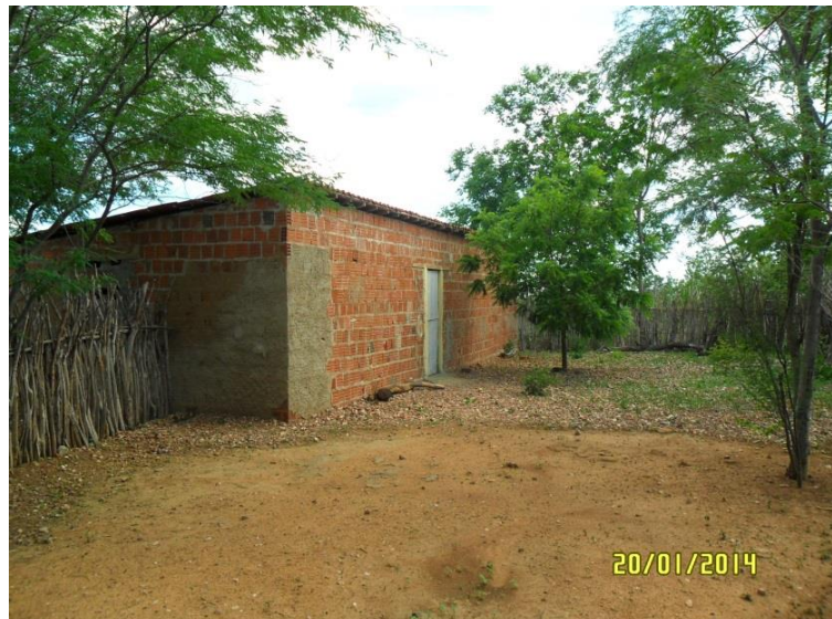
Figura 7.4-170 - Prédio da escola desativado. Coordenadas (S08°02'24.3"/W038°40'52.7").
