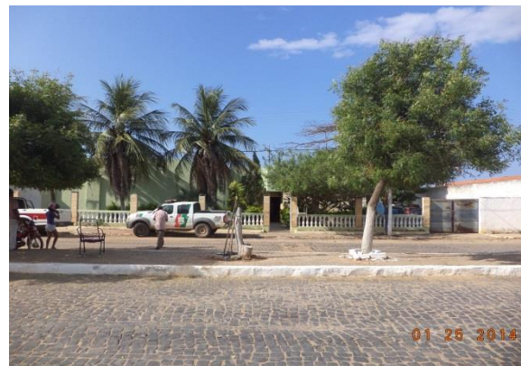
Figura 7.4-116 - Polícia Civil em São João do Piauí/PI (Coordenadas: 8° 21' 16,6" S / 42° 15' 26,0" O).
