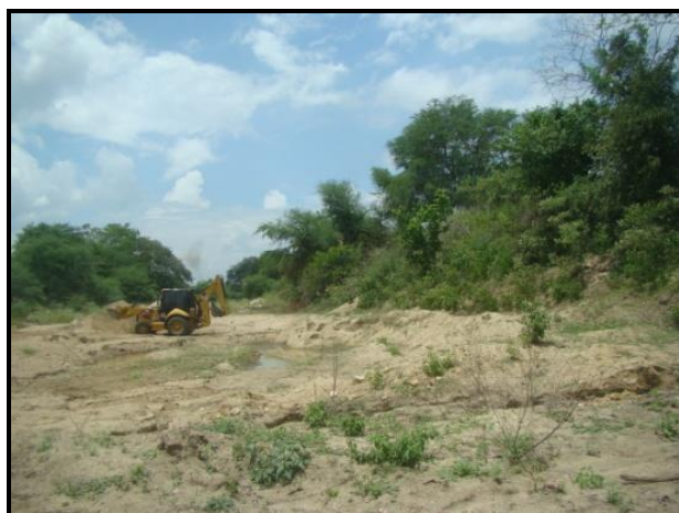
Figura 7.4-159 - ATE 128 – Extração de areia em leito seco de rio - Coordenadas UTM SIRGAS 2000 434767E/9141712N, fuso 24S.
