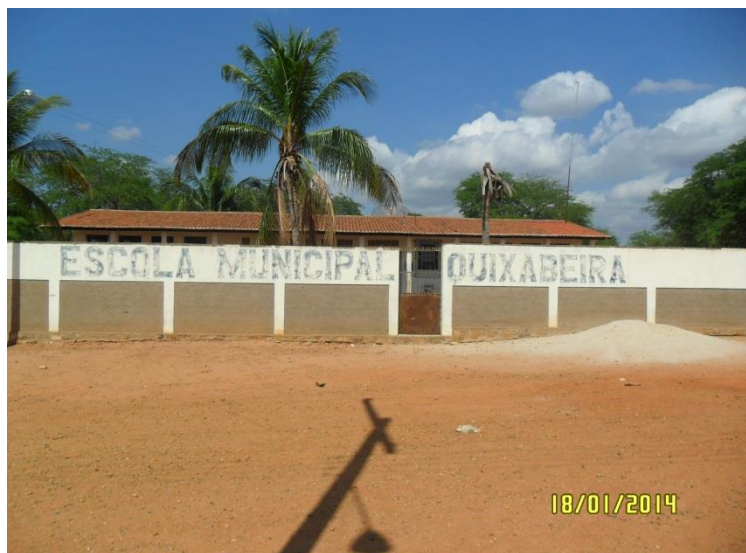
Figura 7.4-196 – Escola Municipal de Borda do Largo. Coordenadas (S08°55'21.0"/W038°10'25.5").
