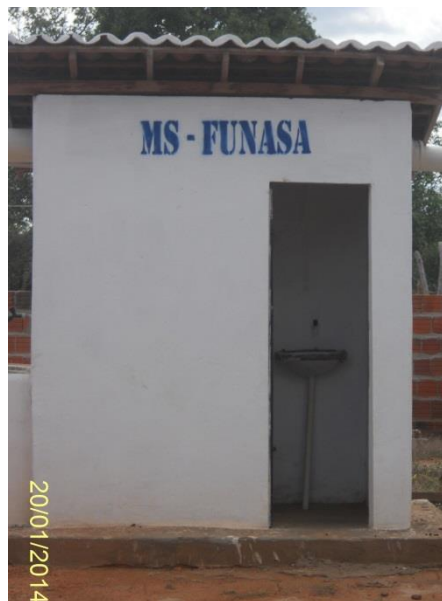
Figura 7.4-179 - Banheiro nas casas de Chupeiro - Coordenadas (S08°15'33.5"/W041°22'41.6").
