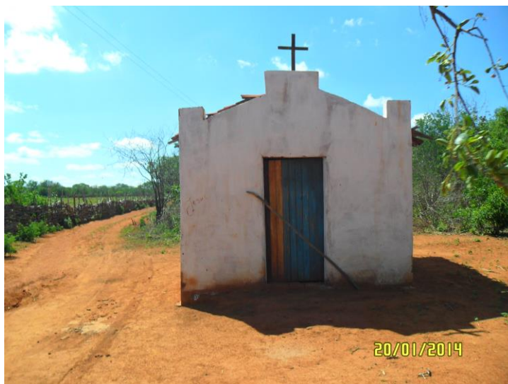
Figura 7.4-174 - igreja da comunidade Serra do Talhado. Coordenadas (S08°13'03.3"/W038°41'12.3").
