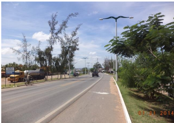
Figura 7.4-82 - Figura - Trecho da BR-116 no município de Brejo Santo / CE (Coordenadas: 7°29'10.50"S/ 38°59'1.00"O).
