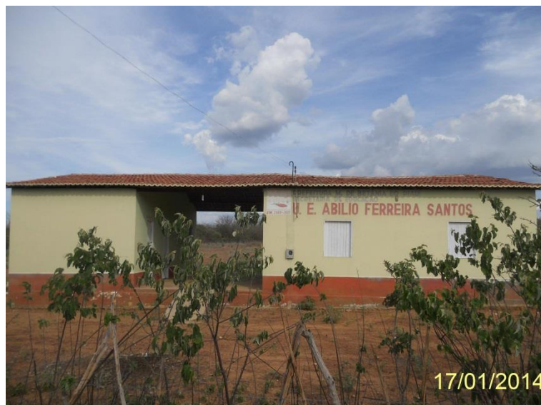
Figura 7.4-201 – Escola desativada em Silvino. Coordenadas (S08°05'06.1"/W040°52'20.6")
