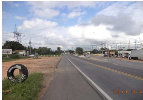
Figura 7.4-83- Trecho da BR-116 no município de Milagres - CE (Coordenadas: 7°18'32.40"S / 38°56'1.33"O).
