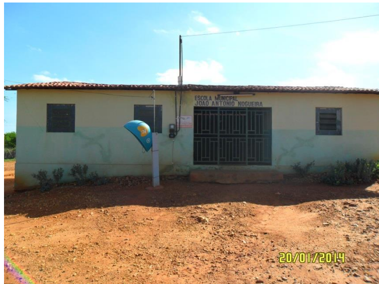
Figura 7.4-169 - Escola Municipal João Antônio Nogueira em Juazeiro Grande. Coordenadas (S08°13'00.3"/W038°44'37.1").
