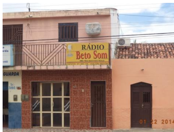
Figura 7.4-118 - Rádio Beto Som, Granito/PE (Coordenadas: S 07°42'56.3"/ W 039°36'57.1").
