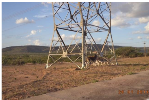
Figura 7.4-149 – Município de Jatobá/PE, jumentos abaixo de torre de linha de transmissão, a coexistência com as Linhas de Transmissão.
