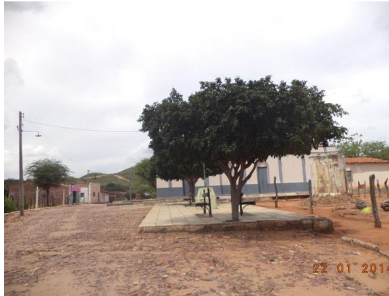
Figura 7.4-36 - Povoado de Barro, Jardim/PE (Coordenadas: S 07°39'46,45"/ W 039°17'37,67").
