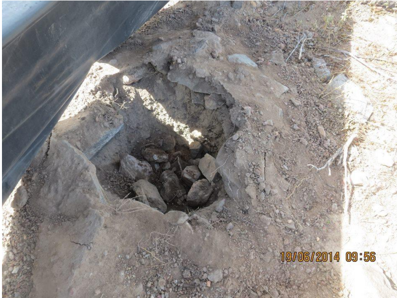
Figura 7.3-57- Detalhe dos buracos tapados na parcela 4 do IBAMA 09. Floresta/PE.
