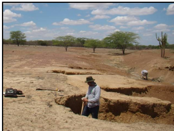
Figura 7.2-130 - Zona de suscetibilidade do solo a ocorrência de erosão laminar e de voçorocas, observada no município de Ouricuri/PE - Zona 24, 370868E/9117128N.
