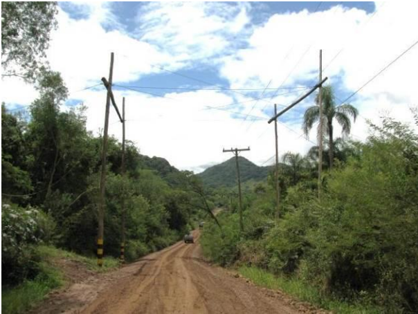
Figura 4.8-4 - Detalhe do processo de construção de proteção em estradas - Empacaduras.
