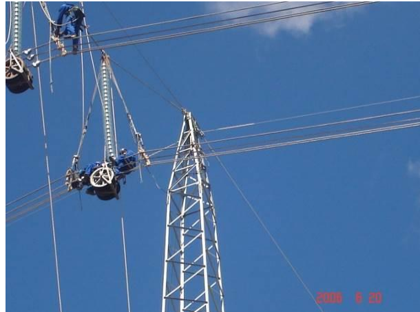
Figura 4.8-5 - Detalhe do grampeamento dos cabos.
