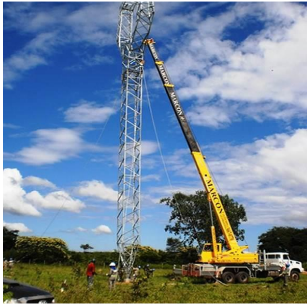
Figura 4.8-1 - Içamento de torres do tipo estaiada.
