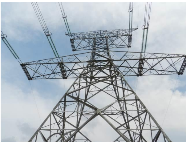
Figura 4.8-6 - Detalhe dos cabos grampeados e com espaçadores.
