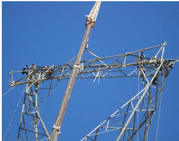
Figura 4.8-2 - Montagem de Torres Autoportantes.
