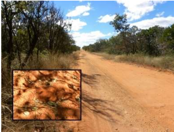
Foto 5.2-45: Cobertura Arenosa Elúvio-coluvionar, conforme observada em área a ser atravessada pela futura LT. Coord. 23 K 491.115 m E 8.110.359 m S.
