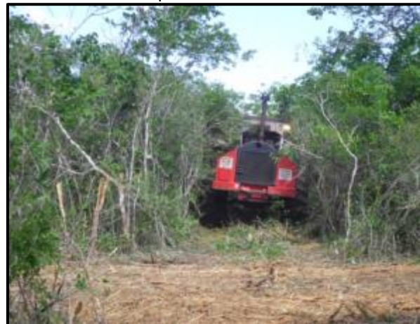
Foto 3-8 : Supressão mecanizada com o maquinário Prentice (desbastador florestal)
