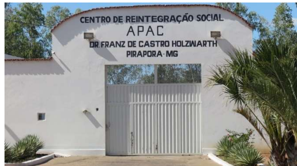
Foto 5.4.4.7-46: Instalação social a 253 m – Centro de Reintegração Social – APAC.
