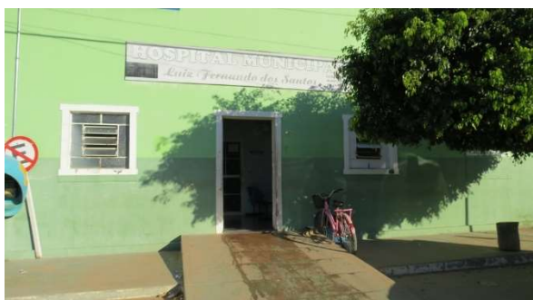
Foto 5.4.3.3-7: Instalações do Hospital Luiz Fernando dos Santos, na Zona Central de Mambai (GO).
