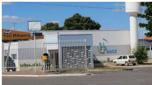
Foto 5.4.3.3-6: Instalações do Hospital Municipal, na Zona Central de Posse (GO).
