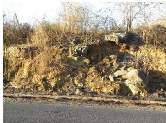
Foto 5.2-240: Topo rochoso irregular, com presença de matacões. Coord. 23 L 377.297 m E, 8.399.284 m S.
