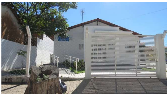
Foto 5.4.3.3-5: Instalações da Unidade Básica de Saúde Deraldino J. de Almeida na Zona Central de Posse (GO).
