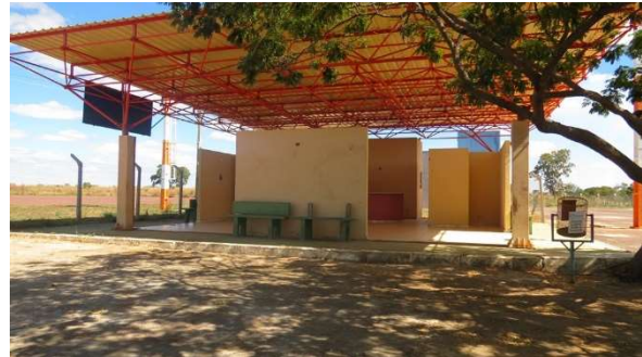
Foto 5.4.3.3-78: Infraestrutura de acomodação de passageiros do Aeródromo de Pirapora (MG).
