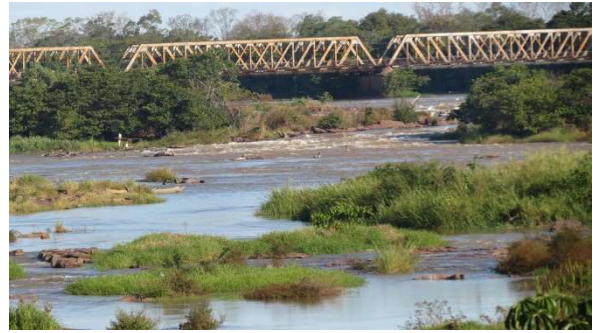
Foto 5.4.3.3-87: Ponte de ferro que atravessa o rio São Francisco entre Pirapora (MG) e Buritizeiro (MG).
