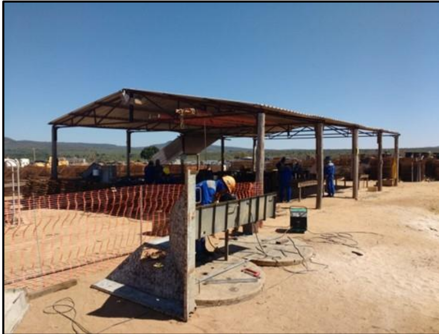
Figura 3-58: Exemplo de construção de Central de Resíduos.
