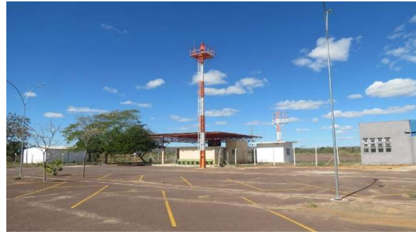
Foto 5.4.4.7-44: Instalações do Aeroporto Municipal de Pirapora.
