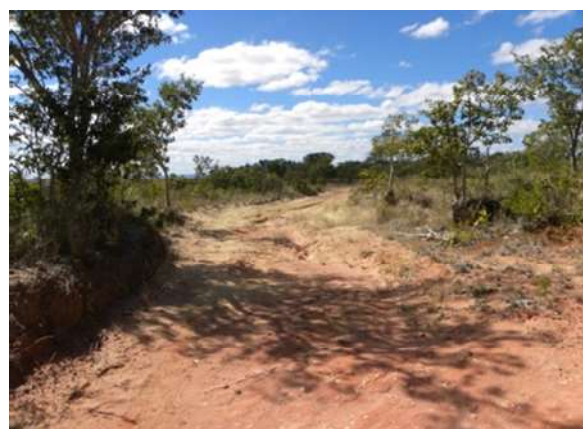
Foto 5.2-248: Erosão laminar evoluindo para sulcos, decorrente de concentração de água pluvial em via de acesso local. Coord. 23 K 479.284 m E, 8.121.994 m S.
