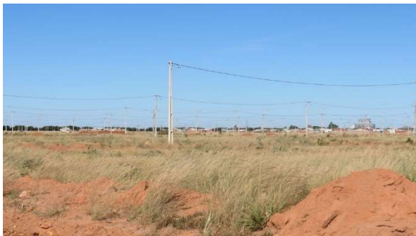
Foto 5.4.4.7-9: Área de expansão do Distrito de Vila Rosário, em Correntina (BA), ainda sem ocupação residencial, apenas com instalações de luz e ruas.
