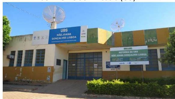
Foto 5.4.3.3-110: Instalação de parabólicas em órgãos públicos em Urucuia (MG).
