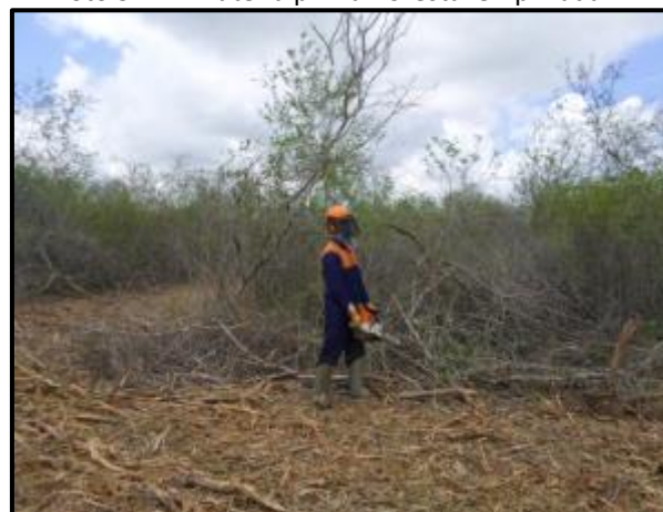
Foto 3-14 : Colaborador utilizando os EPIs apropriados para a atividade.
