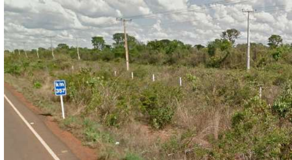
Foto 5.4.4.7-31: Rodovia MG-202 de acesso ao município a ser interceptada pela LT, no Km 357, destaque para a rede de energia de distribuição.
