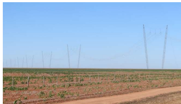
Foto 5.4.4.7-5: Paralelismo com LT no município de Correntina (BA), próximo a comunidade Vila Rosário (fora da AE).
