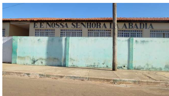
Foto 5.4.3.3-36: Instalações da EE Nossa Senhora da Abadia em Formoso (MG).
