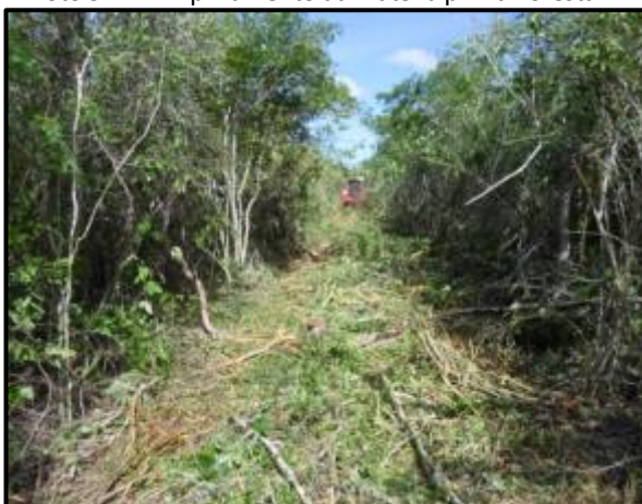
Foto 3-13 : Supressão mecanizada em faixa de serviço.
