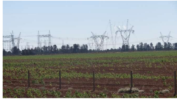
Foto 5.4.4.7-4: LT implantada saindo da SE Rio de Éguas em Correntina, sentido Jaborandi. Paralelismo com a futura LT em licenciamento.
