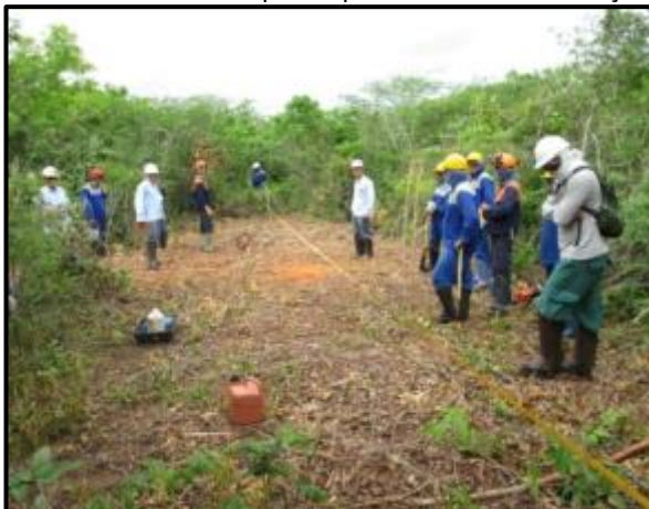
Foto 3-7 : Conferência das dimensões em área de torre
