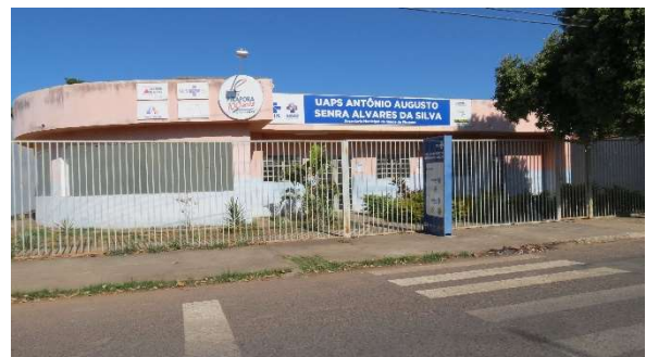
Foto 5.4.3.3-22: Instalações do UAPS Antônio Augusto Senra Alvares da Silva Pirapora (MG).
