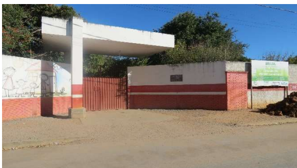
Foto 5.4.3.3-45: Instalação da Escola Municipal Pres. Tancredo Neves em São Romão (MG).
