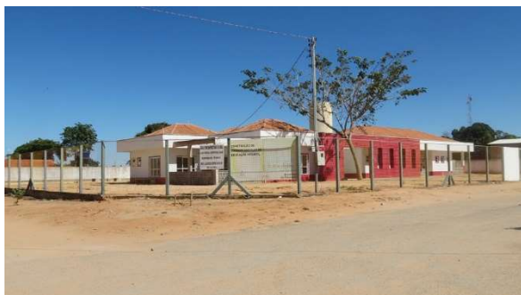
Foto 5.4.3.3-33: Instalações da futura Escola de Educação Infantil em Damianópolis (GO).
