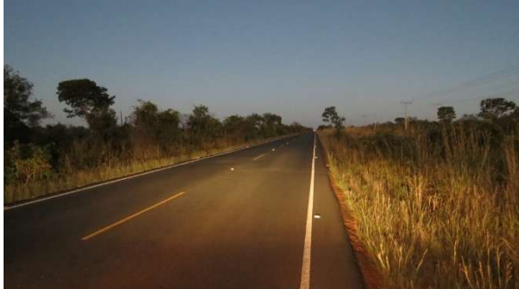
Foto 5.4.4.7-30: Rodovia MG-202 de acesso ao município a ser interceptada pela LT.
