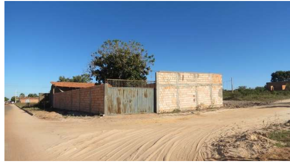
Foto 5.4.3.3-75: Rua na zona periférica urbana de Uruçuaia (MG) sem asfaltamento.
