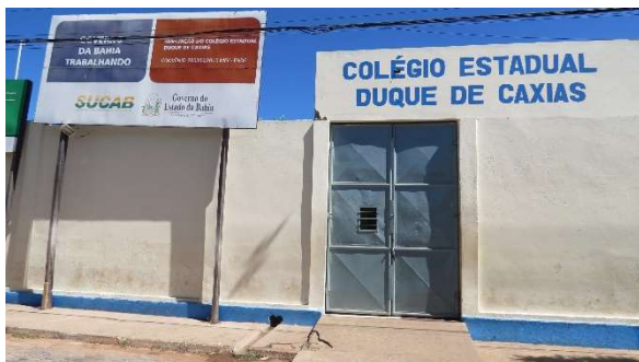
Foto 5.4.3.3-25: Instalações do Colégio Estadual Duque de Caxias em Correntina (BA).
