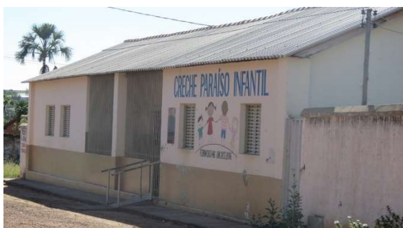
Foto 5.4.3.3-35: Instalações de Educação Infantil em Formoso (MG).
