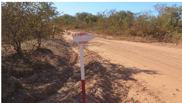
Foto 5.4.4.7-24: Passagem da LT na via vicinal Distante 428 m da LT.
