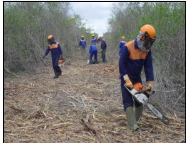
Foto 3-10 : Supressão semi-mecanizada.
