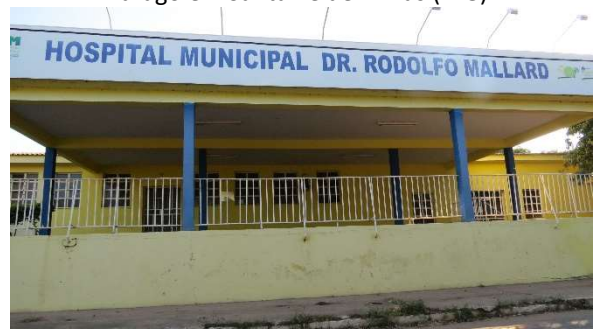
Foto 5.4.3.3-20: Instalações do Hospital Municipal Dr. Rodolfo Mallard em Buritizeiro (MG).
