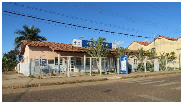
Foto 5.4.3.3-21: Instalações da Unidade Básica de Saúde em Pirapora (MG).
