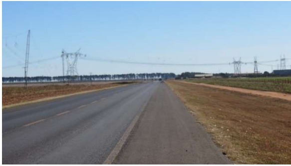
Foto 5.4.4.7-3: Ao lado direito da foto LT implantada chegando na SE Rio das Éguas. Rodovia BR-020, paralela à futura LT em Correntina (BA).
