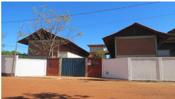
Foto 5.4.3.3-43: Instalação da Escola Municipal Diomedes de A. Valadares em Riachinho (MG).
