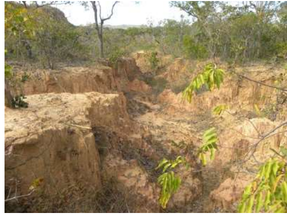
Foto 5.2-245: Reativação de processo erosivo (voçorocamento) em área sobre terrenos arenosos, friáveis. Coord. 23 L 376.861 m E, 8.384.429 m S.
