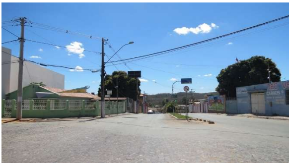
Foto 5.4.3.3-70: Rua de bloquete intertravado no núcleo da sede municipal em Correntina (BA).
