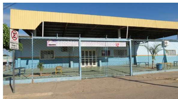
Foto 5.4.3.3-30: Instalações da Escola Municipal João Ferreira da Cruz em Mambá (GO).
