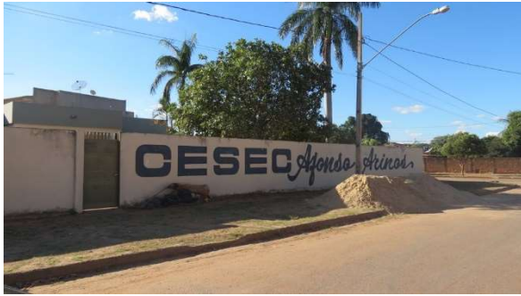
Foto 5.4.3.3-39: Instalações do Centro Estadual de Educação Continua em Arinos (MG).
