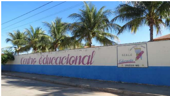
Foto 5.4.3.3-41: Instalações do Centro Educacional D.L. Cavalcanti em Urucuia (MG).
