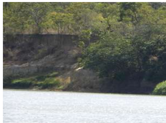
Foto 5.2-252: Caracterização da erosão na margem lateral do rio Paracatu, em função do fluxo de água corrente. Coord. 23 K 467.919 m E, 8.134.000 m S.
