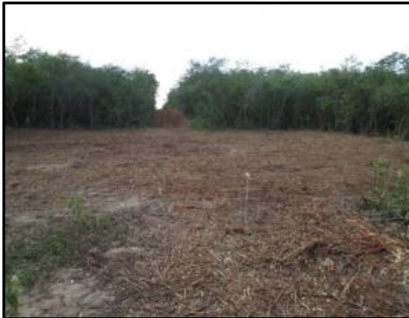
Foto 3-21 : Supressão realizada em área de torre autoportante
