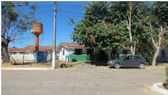
Foto 5.4.3.3-9: Instalações de Unidade Básica de Saúde em Damianópolis (GO).
