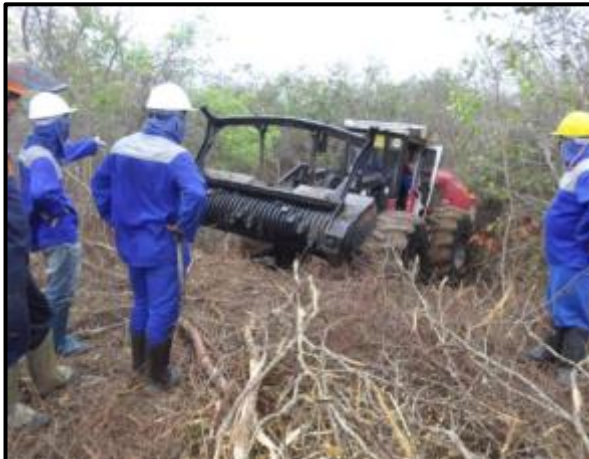
Foto 3-9 : Supressão mecanizada com o maquinário Prentice.
