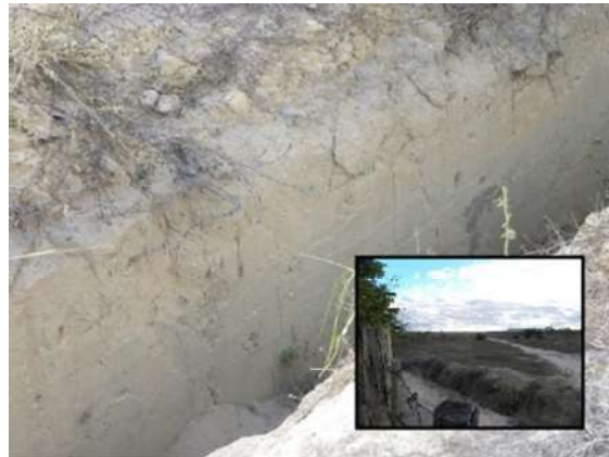
Foto 5.2-37: Caracterização de talude de corte evidenciando sedimentos detríticos, argilo-arenosos, associados aos Terraços Aluvionares presentes em parte dos terrenos a serem interceptados pela LT. Coord. 23 K 510.812 m E, 8.087.023 m S.
