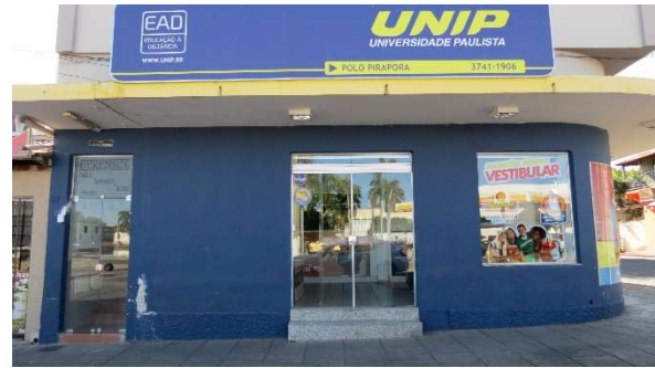
Foto 5.4.3.3-54: Instalações EAD da Universidade Paulista em Pirapora (MG).
