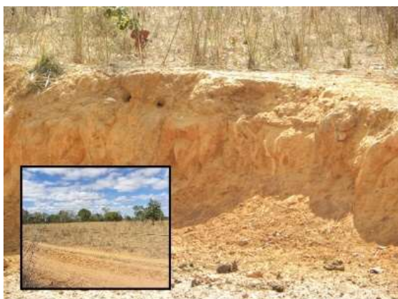
Foto 5.2-31: Detalhe de talude de corte evidenciando sedimentos inconsolidados associados aos Terraços Aluvionares, observado no entorno da LT. Coord. 23 L 396.232 m E, 8.258.409 m S.
