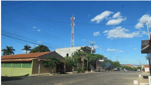
Foto 5.4.3.3-105: Torre de transmissão de telefonia, Jaborandi (BA).
