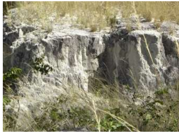
Foto 5.2-214: Talude de corte erosivo associado a terrenos recobertos por neossolos quartzarênicos. Coord. 23 K 474.890 m E, 8.126.563 m S.
