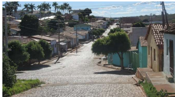
Foto 5.4.3.3-71: Rua de bloquete intertravado no núcleo da sede municipal em Jaborandi (BA).
