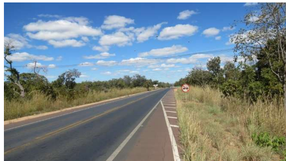
Foto 5.4.4.7-40: Paralelismo da futura LT com LTs já instaladas no cruzamento com a BR-365.
