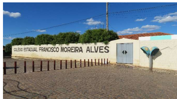
Foto 5.4.3.3-28: Instalações do Colégio Estadual Francisco Moreira Alves em Jaborandi (BA).
