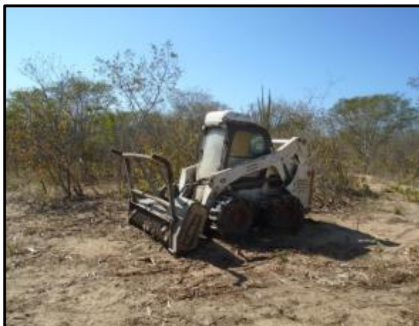
Foto 3-15 : Bobcat com cabeçote desbastador florestal, utilizado para supressão nessa área
