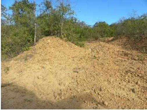
Foto 5.2-87: Caracterização de áreas de empréstimo de seixos rolados, de granulação média. Coord. 23 K 427.696 m E, 8.187.180 m S.
