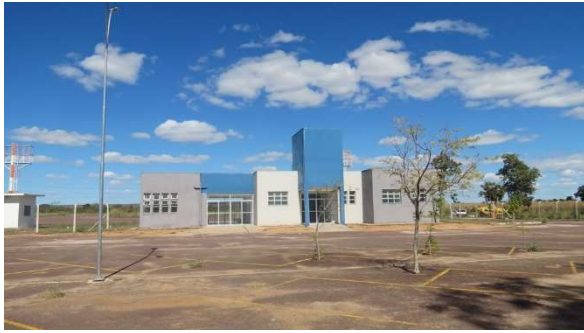
Foto 5.4.4.7-43: Instalações do Aeroporto Municipal de Pirapora.
