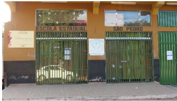
Foto 5.4.3.3-47: Instalação da Estadual São Pedro em Buritizeiro (MG).
