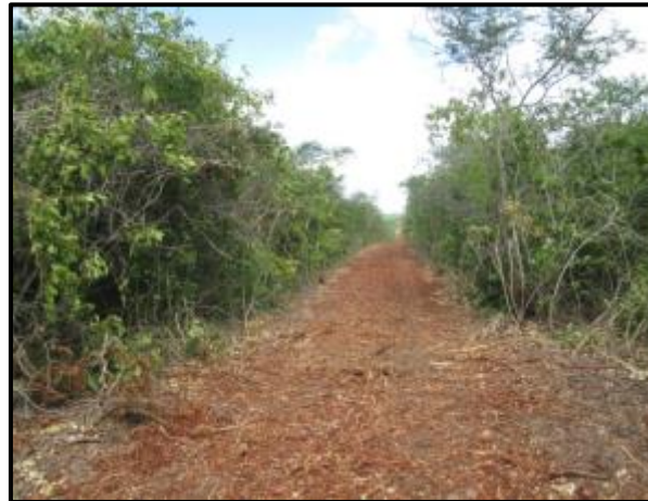
Foto 3-22: Supressão em faixa de serviço
