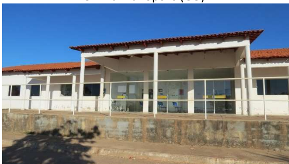
Foto 5.4.3.3-11: Instalações de Unidade de Saúde em Formoso (MG).
