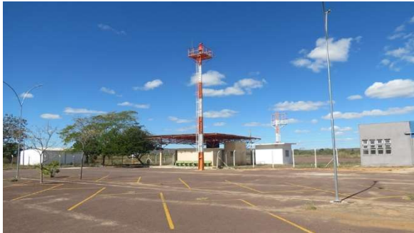
Foto 5.4.3.3-77: Infraestrutura de sinalização do Aeródromo de Pirapora (MG).
