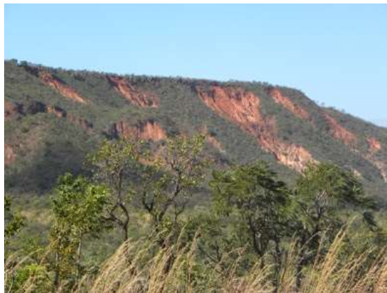
Foto 5.2-229: Erosões profundas seccionando em diferentes pontos a escarpa. Coord. 23 L 365.503 m E, 8.435.102 m S.
