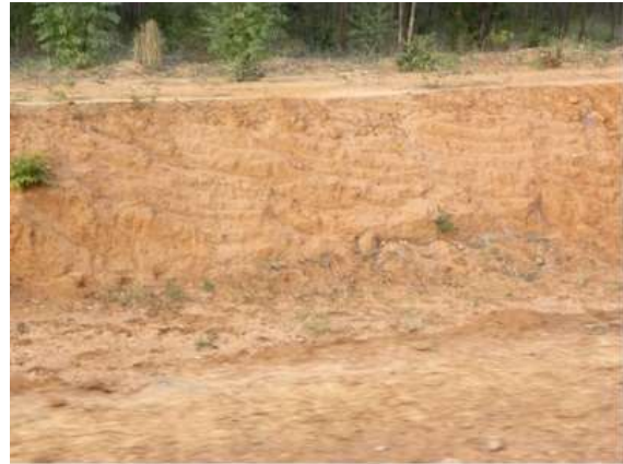
Foto 5.2-36: Talude de corte evidenciando espessura superior a 2 m de sedimentos inconsolidados, argilo-arenosos, correlacionados aos Terraços Aluvionares. Coord. 23 K 514.227 m E, 8.083.207 m S.
