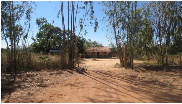
Foto 5.4.4.7-28: Exemplo de moradia e padrão construtivo no PA São Francisco.
