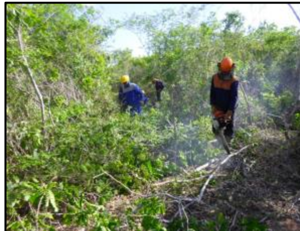
Foto 3-6 : Supressão semi-mecanizada
