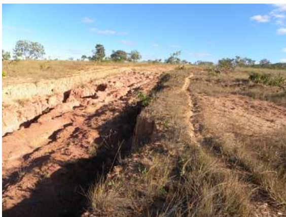
Foto 5.2-231: Detalhe de erosão laminar rasa, avançando para profunda, sobre rochas metapelíticas. Coord. 23 L 380.426 m E, 8.324.695 m S.
