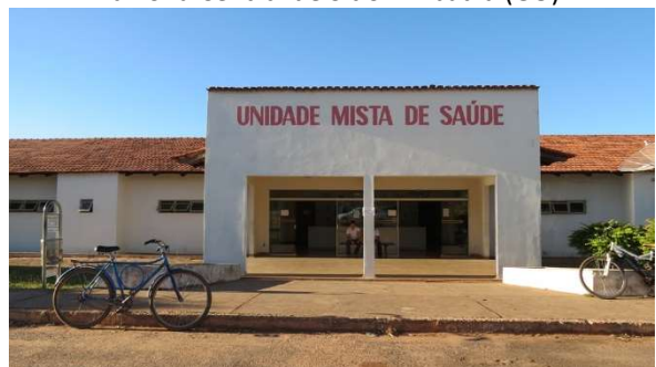
Foto 5.4.3.3-12: Instalações Da Unidade Mista de Saúde em Formoso (MG).
