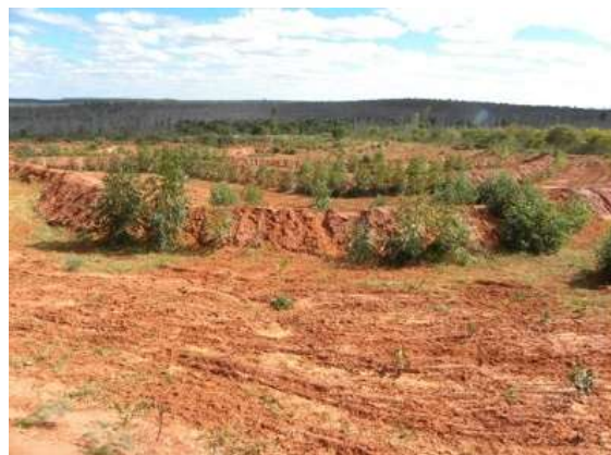
Foto 5.2-86: Área de exploração de canga, já em processo de recuperação com revegetação e retaludamento. Coord. 23 K 495.333 m E, 8.103.918 m S.
