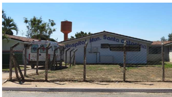
Foto 5.4.3.3-8: Instalações do Hospital Municipal Santa Catarina em Damianópolis (GO).
