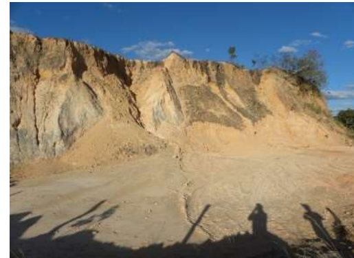
Foto 5.2-90: Talude de corte em área de empréstimo de areia de encosta. Coord. 23 L 375.071 m E, 8.402.814 m S.
