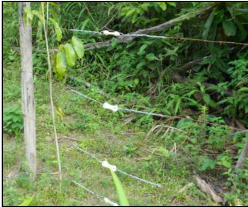
Figura 3-24: Exemplo de cerca seccionada e aterrada. Na figura acima, destacam-se, na cor azul, o seccionamento da cerca, e, na cor vermelha, o aterramento.
