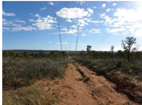
Foto 5.2-108: Trecho aplanado adjunto à calha do rio Arrojado, também associado à unidade "Chapadas do Rio Corrente". Coord. 23 L 372.486 m E, 8.452.217 m S.
