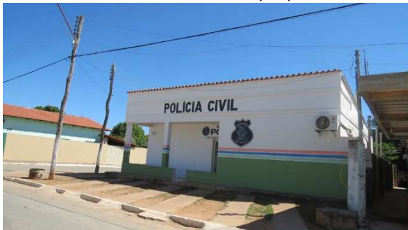
Foto 5.4.3.3-99: Instalações da Polícia Civil de Damianópolis (GO).
