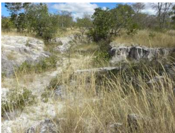
Foto 5.2-247: Encosta convexa suave, exposta a processo erosivo profundo. Coord. 23 K 474.890 m E, 8.126.563 m S.
