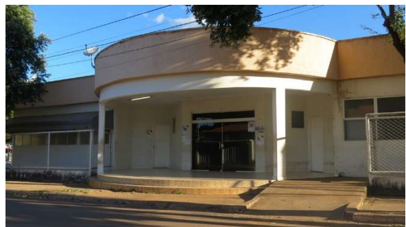
Foto 5.4.3.3-14: Instalações do Hospital Central de Arinos (MG).
