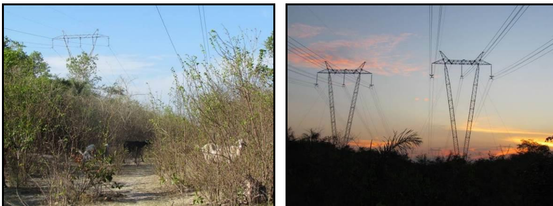
Figura 6.102. LTs já instaladas nas proximidades do PF4 - Piripiri (PI). Fotos: CARUSO JR.,2013.
