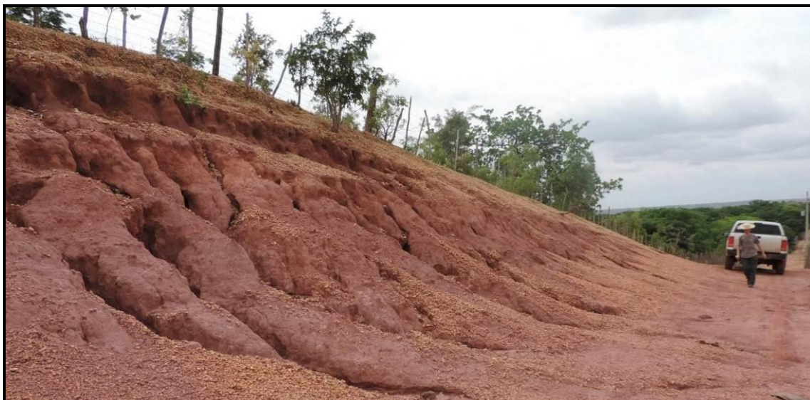
Figura 6.69. Processo de erosão linear - sulcos no município de Teresina/PI - AID da LT. Foto: CARUSO JR., 2013.
