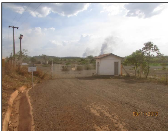
Figura 4.54. Vista geral do portão de entrada.
