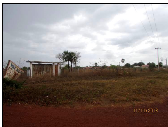
Figura 4.101 Vista geral da frente da área.
