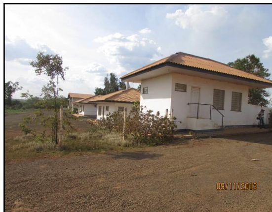
Figura 4.55. Vista geral das edificações no local.
