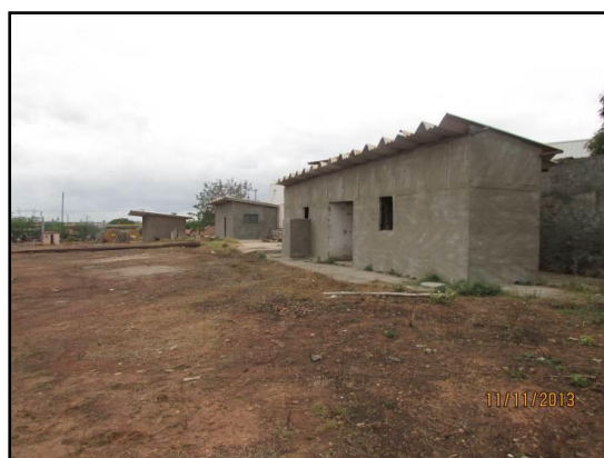
Figura 4.80. Vista da área com edificações.
