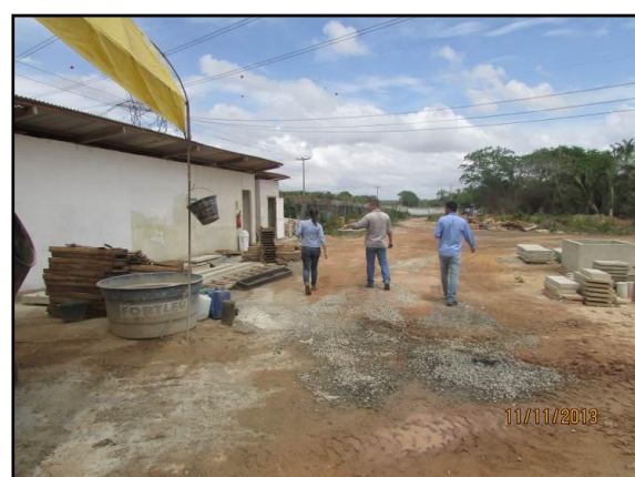
Figura 4.202. Interior canteiro JPW dentro da SE Teresina II.
