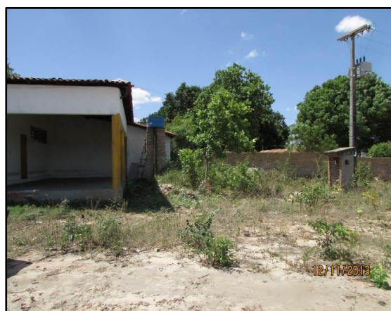
Figura 4.127. Vista geral da área edificada, com água e energia.
