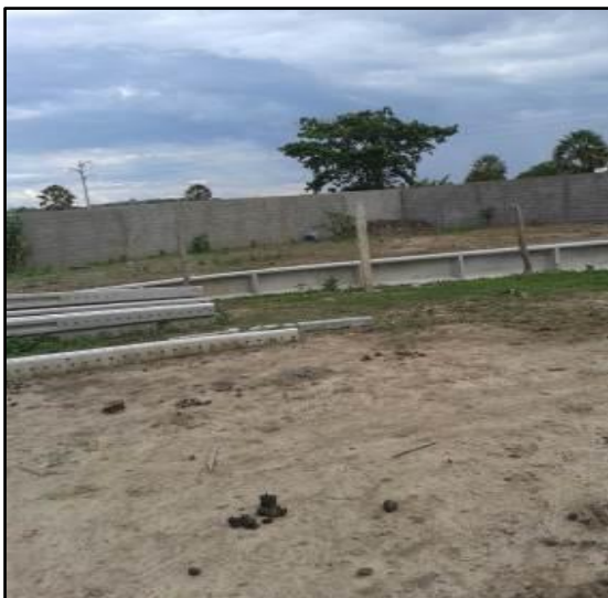
Figura 4.178. Atualmente esta sendo utilizada para armazenamento de materiais.
