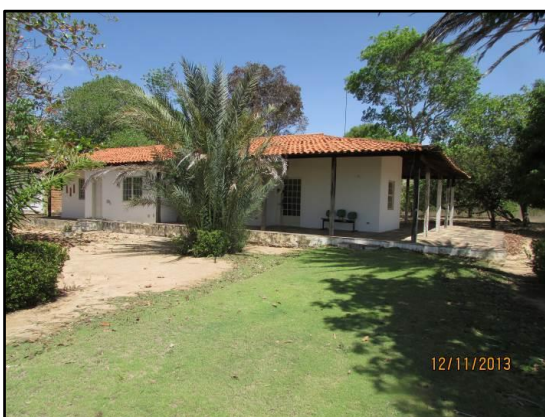
Figura 4.121. Casa de escritório.
