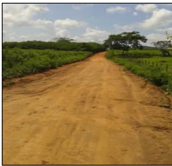
Figura 4.171. Acesso para Área 2 em Mucambo, cerca de 500 m de estrada vicinal sem pavimentação em boas condições de tráfego.
