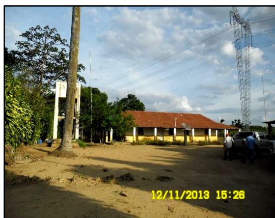
Figura 4.165. Vista da edificação, casa da propriedade podendo ser utilizada como escritório.
