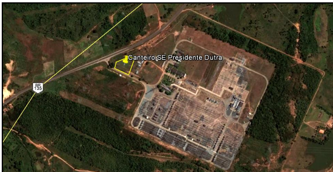
Figura 4.196. Localização da área prevista para canteiro de obras da SE Presidente Dutra (polígono amarelo), município de Presidente Dutra/MA. Fonte: Google Earth Pro.
