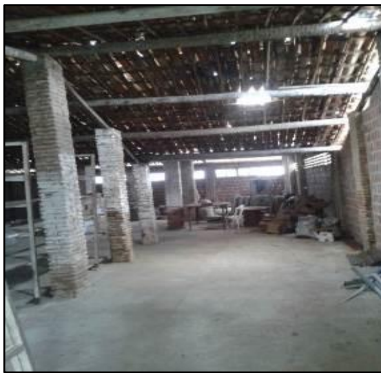
Figura 4.179. Estrutura existente em alvenaria.
