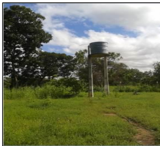
Figura 4.86. Área 4 em Timon, estrutura de caixa de água existente..
