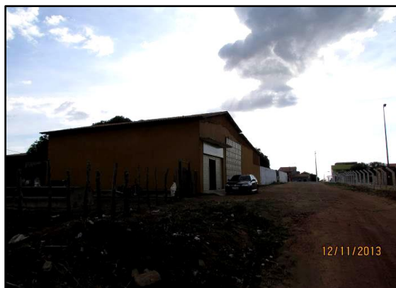
Figura 4.159. Vista de acesso 100m sem pavimentação.
