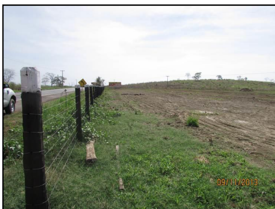
Figura 4.40. Vista geral da área com a BR-226 pavimentada.
