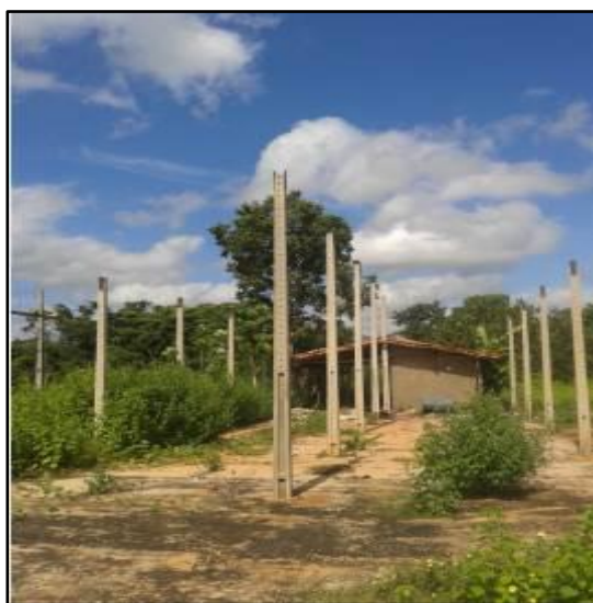
Figura 4.91. Vista geral da Área 5. Terreno plano com pastagem e a presença de árvores esparsas. Antiga fábrica de pré-moldados de postes.
