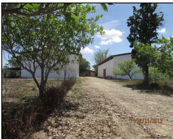
Figura 4.117. Vista geral da área dos galpões.
