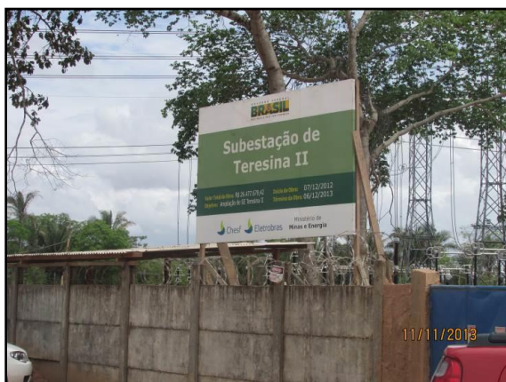
Figura 4.201. Entrada canteiro JPW SE Teresina II.
