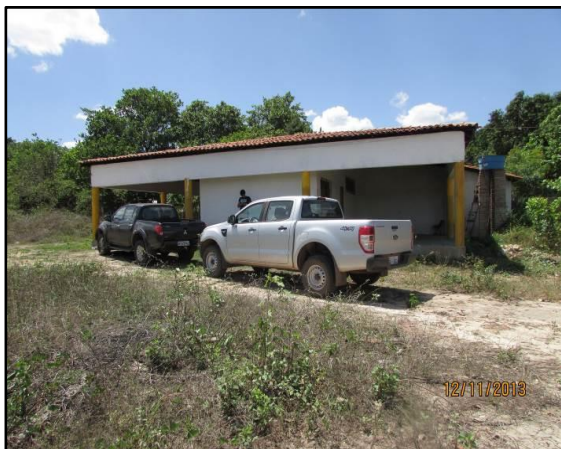
Figura 4.126 Vista geral da área edificada.
