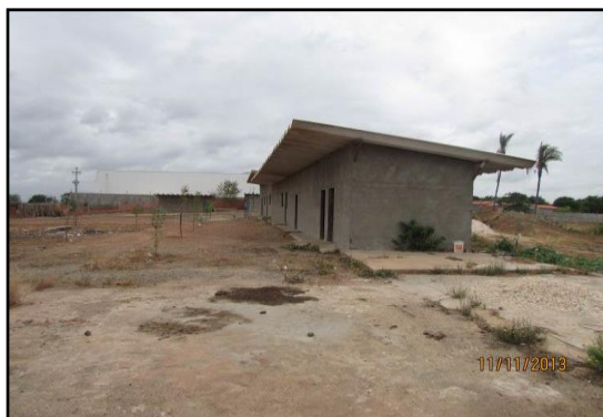
Figura 4.77. Vista das edificações no local.
