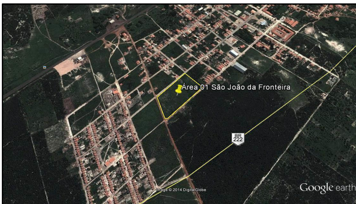
Figura 4.139. Localização da Área 1 (polígono amarelo) no município de São João da Fronteira/PI. Fonte: Google Earth Pro.
