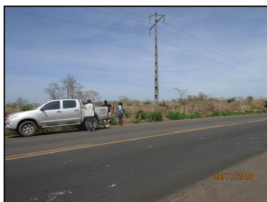
Figura 4.48. Limitação da área com a rodovia BR-135. Presença de rede de alta tensão 69 kV na área.
