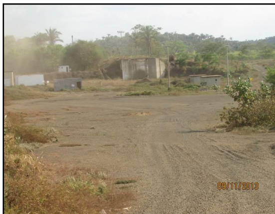
Figura 4.56. Vista para a área sugerida para canteiro.
