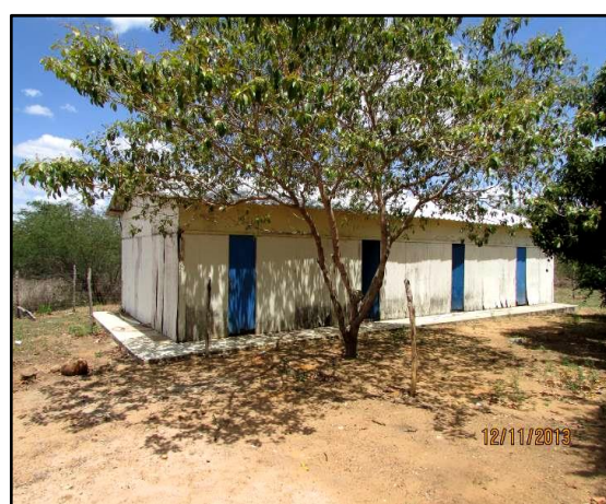
Figura 4.136. Vista geral das edificações.
