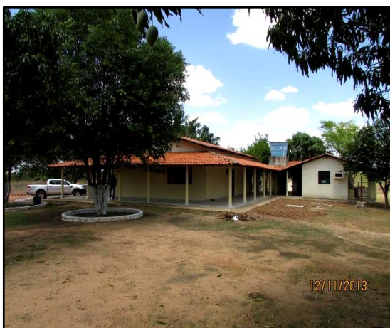
Figura 4.135. Vista geral das edificações.
