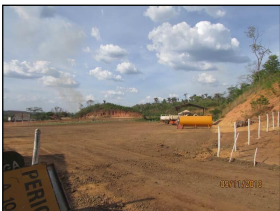
Figura 4.52 Vista para a área sugerida para canteiro.
