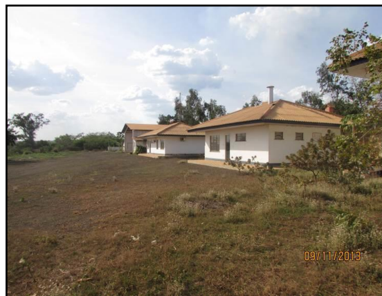
Figura 4.57. Vista da área com edificações.
