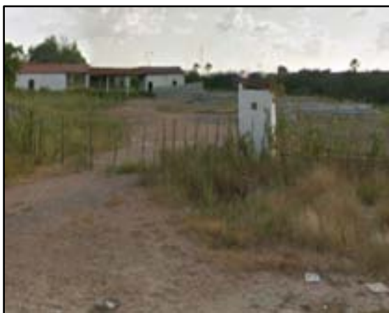
Figura 4.194. Vista da entrada Área 6 em Sobral.
