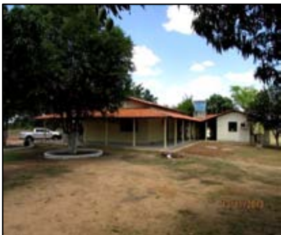
Figura 4.135. Vista geral das edificações.
