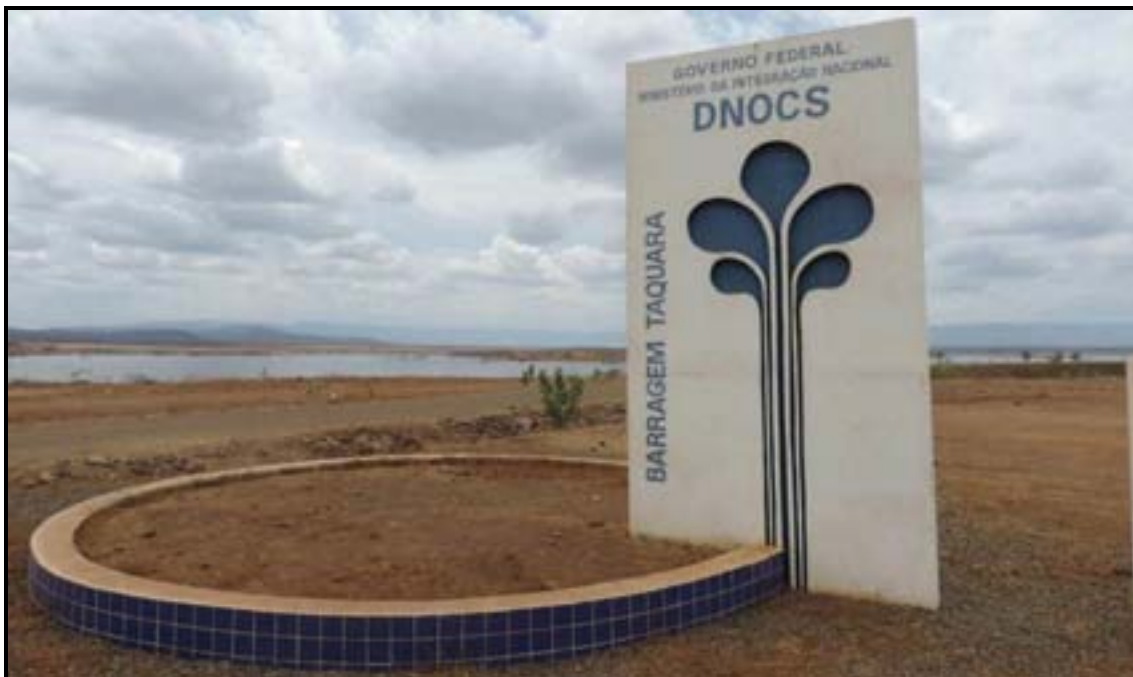
Figura 6.67. Barragem Taquara no Riacho/Rio Jaibaras, construída pelo DNOCS na tentativa de solucionar o problema da falta de disponibilidade de recursos hídricos para a população na região. Foto: CARUSO JR., 2013.
