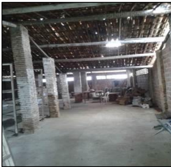
Figura 4.179. Estrutura existente em alvenaria.
