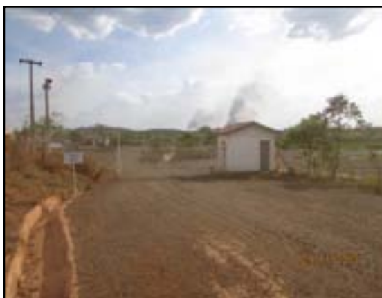
Figura 4.54. Vista geral do portão de entrada.
