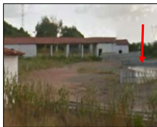
Figura 4.195. Área 06 em Sobral, infraestrutura existente na local. Detalhe para o armazenamento de postes.
