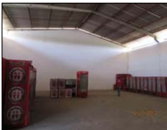
Figura 4.119. Interior dos galpões, atualmente utilizada para estoque de freezer.
