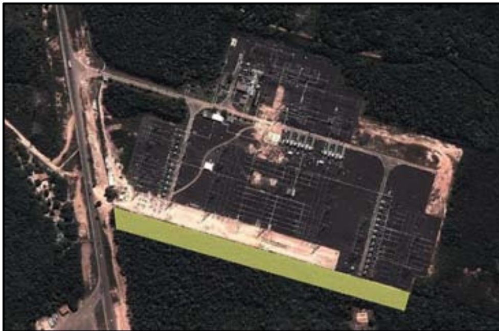
Figura 4.16. Localização da área de ampliação da SE Teresina II, representada pelo polígono amarelo. Fonte: Google Earth Pro.
