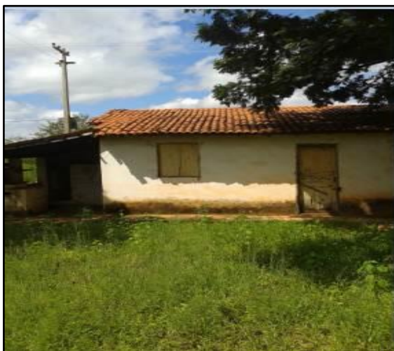
Figura 4.87. Vista da edificação no local.
