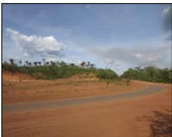
Figura 4.60 Vista geral da área com a partir da BR 226, sem pavimentação.
