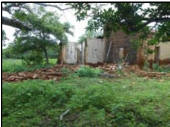
Figura 6.106. Edificação em ruínas (Tapera)
