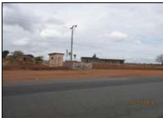
Figura 4.75. Vista geral do acesso pela BR-316.
