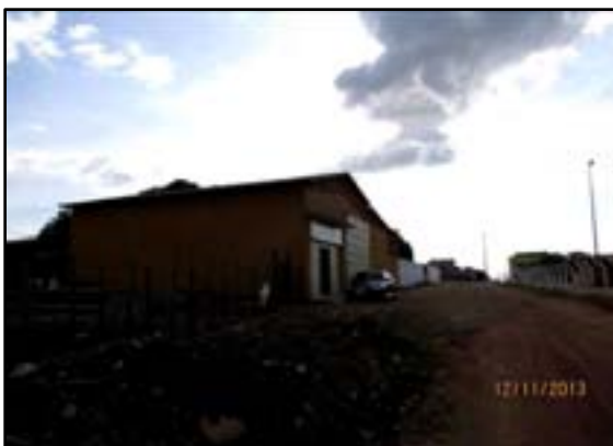
Figura 4.159. Vista de acesso 100m sem pavimentação.
