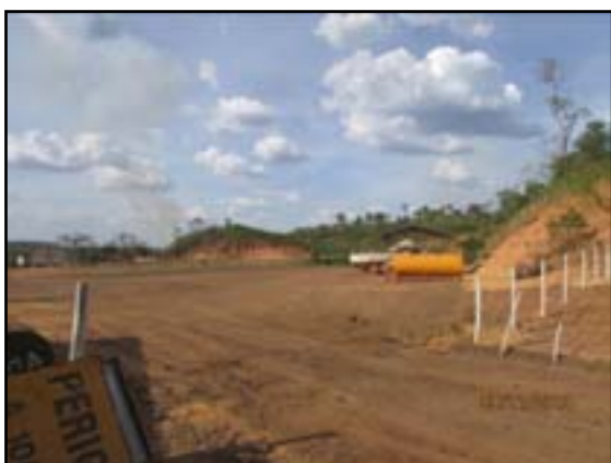
Figura 4.52 Vista para a área sugerida para canteiro.
