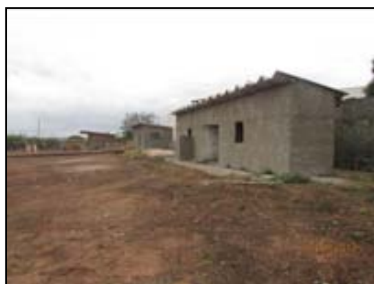
Figura 4.80. Vista da área com edificações.
