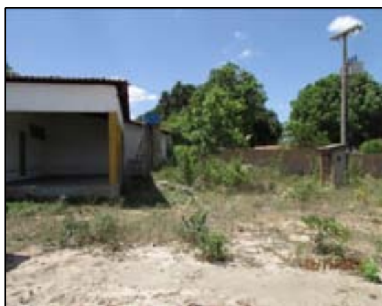
Figura 4.127. Vista geral da área edificada, com água e energia.
