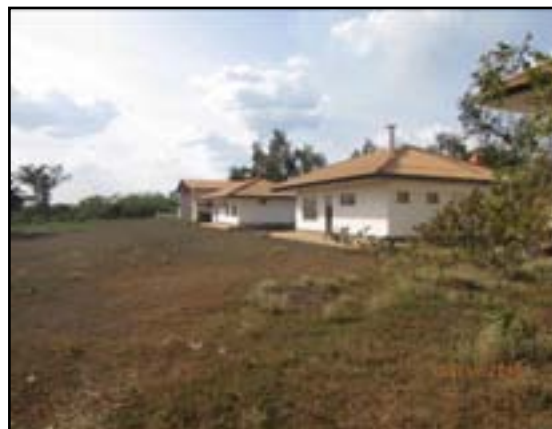
Figura 4.57. Vista da área com edificações.
