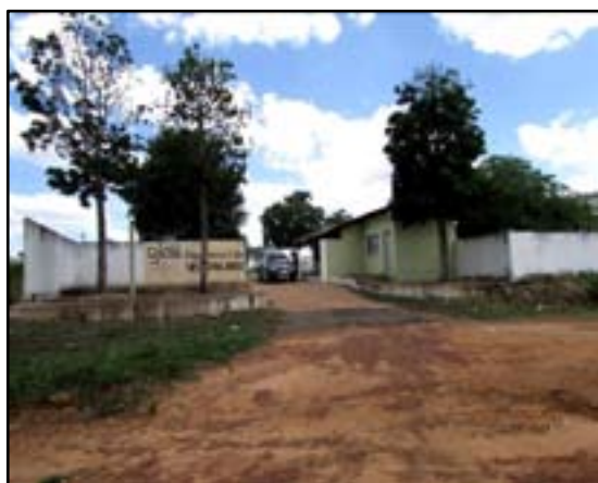
Figura 4.131. Vista geral da entrada às margens da BR-343.
