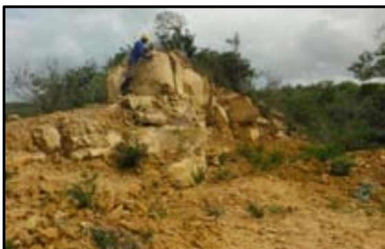
Figura 6.110. Local de retirada de blocos de arenito. Foto: CARUSO JR., 2014.
