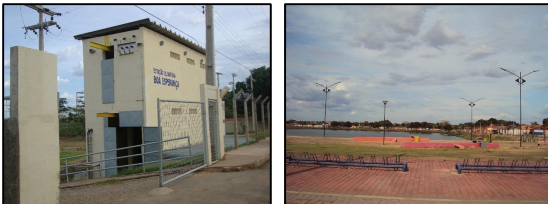
Figura 10.3. Projeto Lagoa do Norte à direita e Estação Elevatória de Águas Pluviais na Avenida Esperança no Bairro Olaria, parte do Projeto Lagoas do Norte em Teresina, PI. Fotos: CARUSO JR., 2013.
