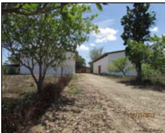
Figura 4.117. Vista geral da área dos galpões.
