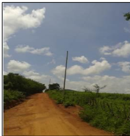
Figura 4.174. Acesso para Área 3 em Mucambo, cerca de 300 m de estrada vicinal sem pavimentação, em boas condições de tráfego.
