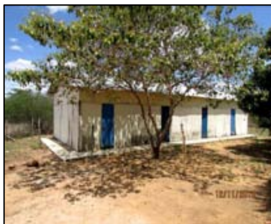
Figura 4.136. Vista geral das edificações.
