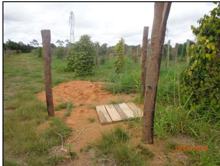
Figura 12.4-1 - Cercamento e tamponamento de cavas de fundações.
