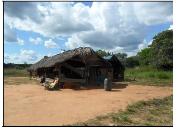
Figura 6.4.2.8.2.3-12 - Vista da Casa da Fazenda Ronca, na AID – Centenário (TO)
