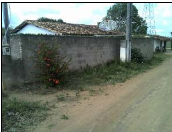
Figura 6.4.2.8.2.3-253 - Residência na faixa de servidão da LT – Povoado Tapera de Maurício – Sapeaçu (BA)
