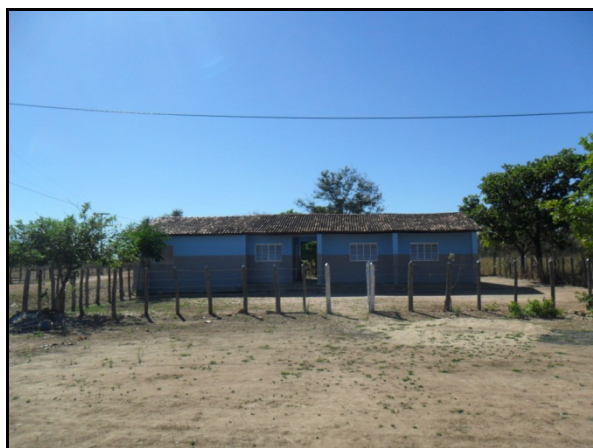
Figura 6.4.2.8.2.3-33 - Escola do povoado Pedra de Cal – Riachão das Neves (BA)
