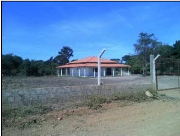
Figura 6.4.2.8.2.3-39 - Casa na faixa de servidão no ponto de cruzamento da diretriz com a principal via do Povoado de Capivara – Catolândia (BA)
