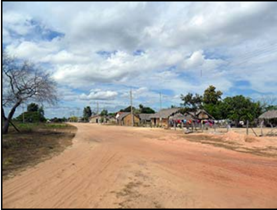
Figura 6.4.2.8.2.3-15 - Rodovia TO – 245, na altura do povoado Alto Bonito – Lizarda (TO)
