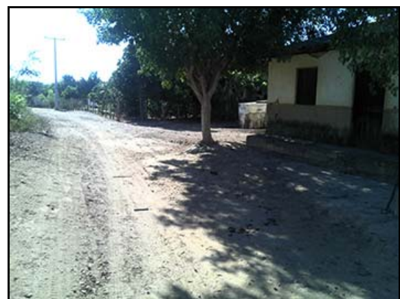
Figura 6.4.2.8.2.3-100 - Vista da vicinal de acesso, padrão construtivo em Limeira– Igaporã (BA)
