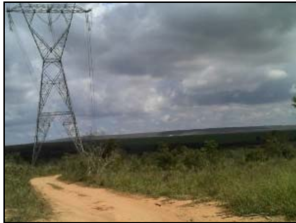
Figura 6.4.2.8.2.3-148 - Vista da Diretriz na Fazenda Igarashi – Ibicoara (BA)
