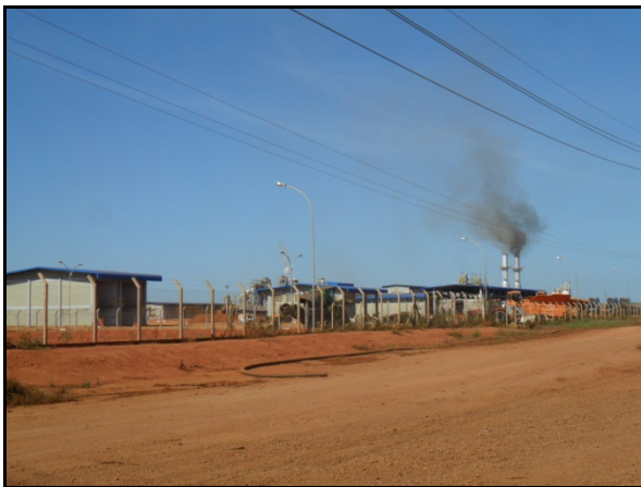
Figura 6.4.2.8.2.3-9 - Vista da Usina da Bungue – Pedro Afonso (TO)
