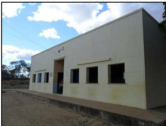
Figura 6.4.2.8.2.3-27 - Unidade Escolar José Maciel de Araújo – Barriguda – Riacho Frio (PI)
