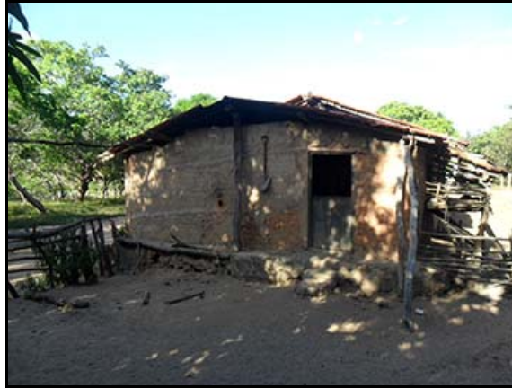
Figura 6.4.2.8.2.3-19 - Benfeitoria na localidade Almésca – Santa Filomena (PI)
