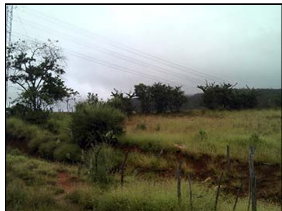
Figura 6.4.2.8.2.3-135 - Vista do ponto de cruzamento da LT com a rodovia BA-148 – Baixão - Rio de Contas (BA)
