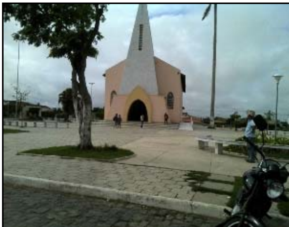
Figura 6.4.2.8.2.3-277 - Igreja Matriz de Nossa Senhora da Conceição na sede municipal de Sapeaçu (BA)
