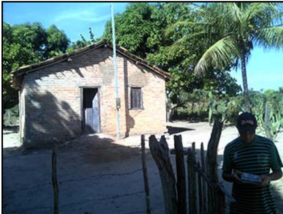
Figura 6.4.2.8.2.3-41 - Padrão construtivo do Povoado Malhada Grande, casas sem acabamento – Baianópolis (BA)
