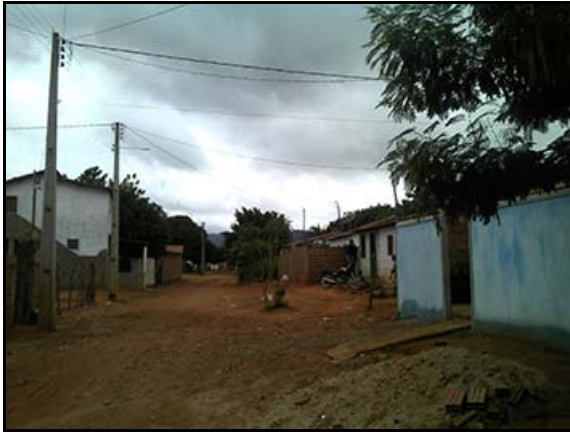
Figura 6.4.2.8.2.3-130 - Centro do povoado Barrinha, as ruas não são pavimentadas – Livramento de Nossa Senhora (BA)
