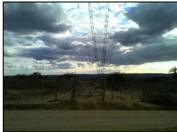
Figura 6.4.2.8.2.3-183 - Cruzamento da LT com vicinal pequenas e grandes propriedades no Povoado Vicente – Planaltino (BA)
