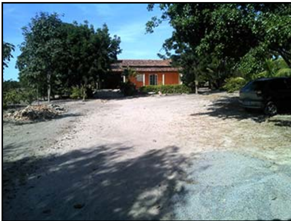
Figura 6.4.2.8.2.3-43 - Casa estabelecida na faixa de servidão da LT – Cabeceira – Baianópolis (BA)
