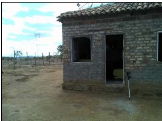
Figura 6.4.2.8.2.3-212 - Residência no Povoado Mamão do Mato – Brejões (BA)
