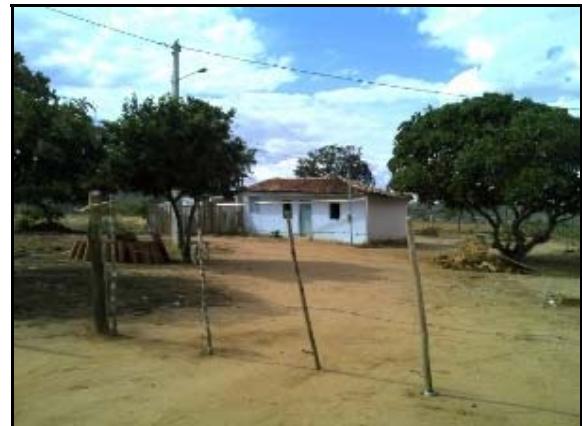
Figura 6.4.2.8.2.3-187 - Construção na faixa de servidão do empreendimento no Povoado Barro Vermelho – Planaltino (BA)
