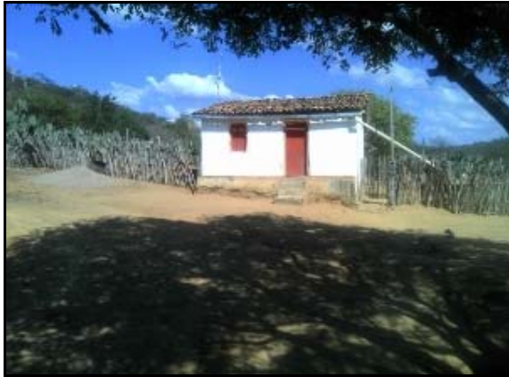
Figura 6.4.2.8.2.3-175 - Residência na faixa de servidão da LT no Povoado Fumaça – Maracás (BA)
