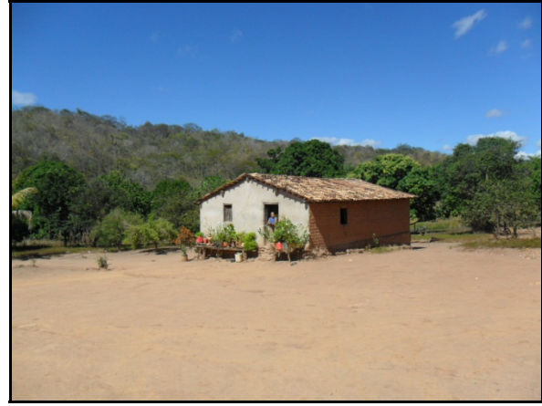
Figura 6.4.2.8.2.3-32 - Casa da Fazenda Mundo Novo, na AID – Cristalândia do Piauí (PI)
