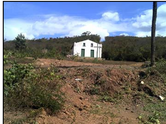
Figura 6.4.2.8.2.3-94 - Igreja localizada na principal via de acesso aos povoados de Tanque do Paú e Paú – Macaúbas (BA)
