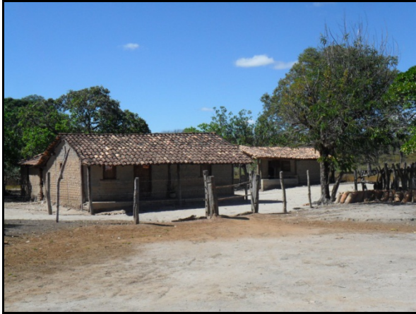
Figura 6.4.2.8.2.3-31 - Casa na AID da localidade Pitomba – Cristalândia do Piauí (PI)
