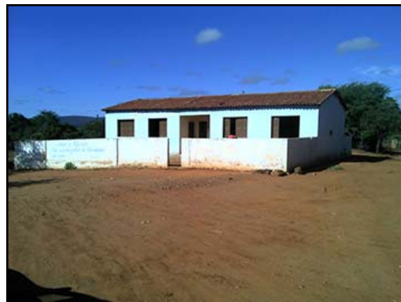
Figura 6.4.2.8.2.3-120 - Escola municipal do Povoado Monteiro – Livramento de Nossa Senhora (BA)
