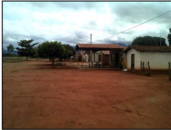
Figura 6.4.2.8.2.3-129 - Vista do Povoado de Patos na rodovia BA-148 – Livramento de Nossa Senhora (BA)
