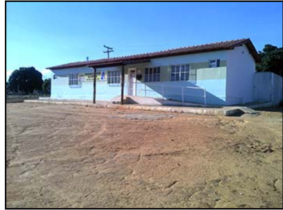
Figura 6.4.2.8.2.3-112 - ESF recentemente inaugurado na Comunidade Quilombola Lagoa do Mato – Caetité (BA)
