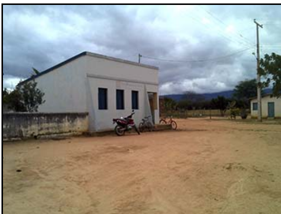
Figura 6.4.2.8.2.3-123 - Escola municipal no Povoado de Nado – Livramento de Nossa Senhora (BA)
