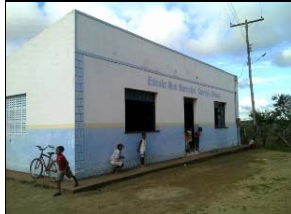
Figura 6.4.2.8.2.3-250 - Escola Municipal Marechal Castelo Branco no Povoado de Sussuarana – Castro Alves (BA)
