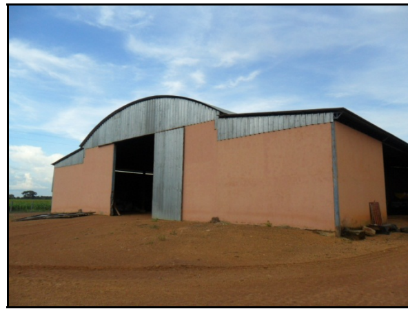
Figura 6.4.2.8.2.3-10 - Vista do Galpao da Fazenda Chaparral – Pedro Afonso (TO)
