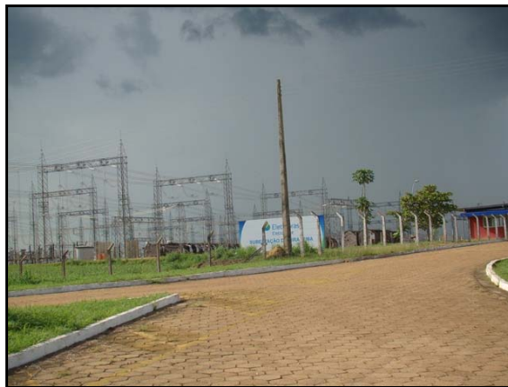
Figura 6.3.2-33 - Exemplo de área urbanizada, SE Miracema, município de Miracema do Tocantins, TO
