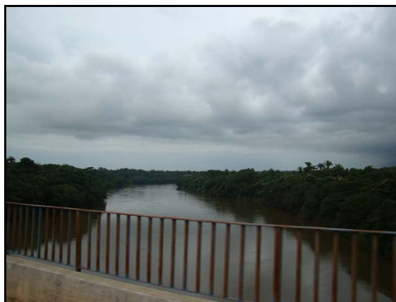
Figura 6.3.2-41 – Travessia do rio Sono, no município de Pedro Afonso, TO
