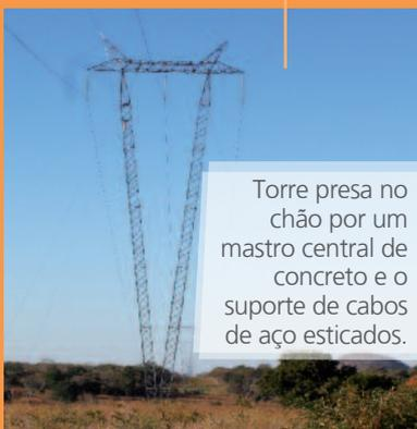
Torre presa no chão por um mastro central de concreto e o suporte de cabos de aço esticados.
