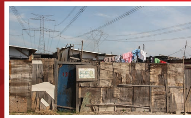
Construção de moradias e benfeitorias
