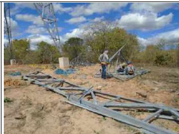
Figura 11.2.6.1-6 – Atividade de montagem de estrutura (outra obra).
