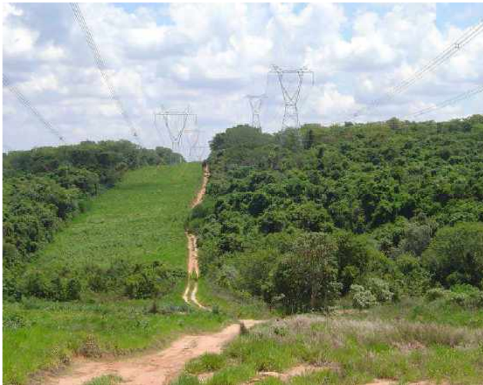
Figura 4.4-1 – As torres da LT mais recente (à direita), foram alteadas, preservando a vegetação nativa existente. Fonte: TCC/BIODINÂMICA, 2018
