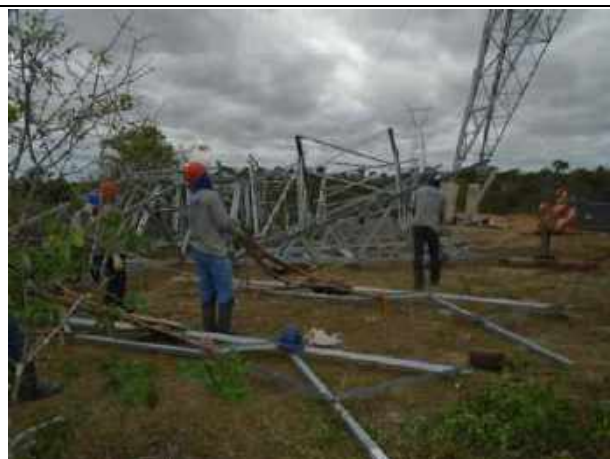
Figura 11.2.6.1-5 – Atividade de montagem de estrutura (outra obra).
