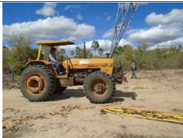
Figura 11.2.6.1-7 – Atividade de montagem de estrutura (outra obra).
