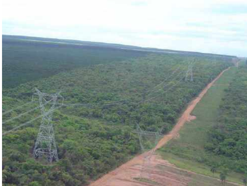
Figura 4.4-2 – Nota-se que as torres da LT mais recente (à esquerda), foram alteadas, preservando a vegetação nativa existente. Fonte: TCC/BIODINÂMICA, 2018
