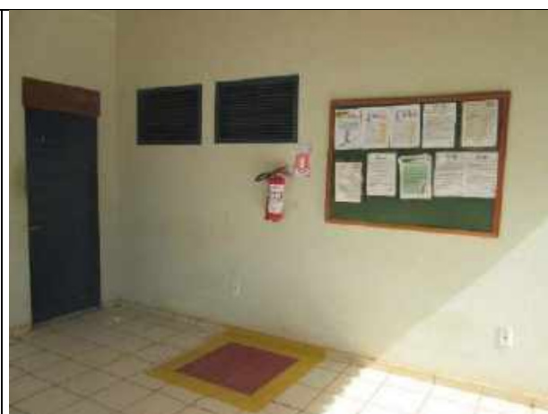
Figura 11.2.6.1-10 – Sinalização e armazenamento de extintores de incêndio em local de fácil acesso (outra obra).
