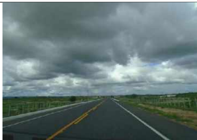
Foto 5.4.2-5 – Estradas pavimentadas e em bom estado na maior parte dos municípios da AII.
