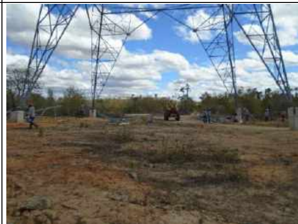
Figura 11.2.6.1-8 – Atividade de montagem de estrutura (outra obra).
