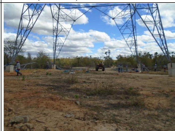
Foto 10.5.1-10 – Atividade de montagem de estrutura (outra obra).
