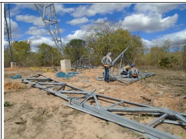
Foto 10.5.1-8 – Atividade de montagem de estrutura (outra obra).
