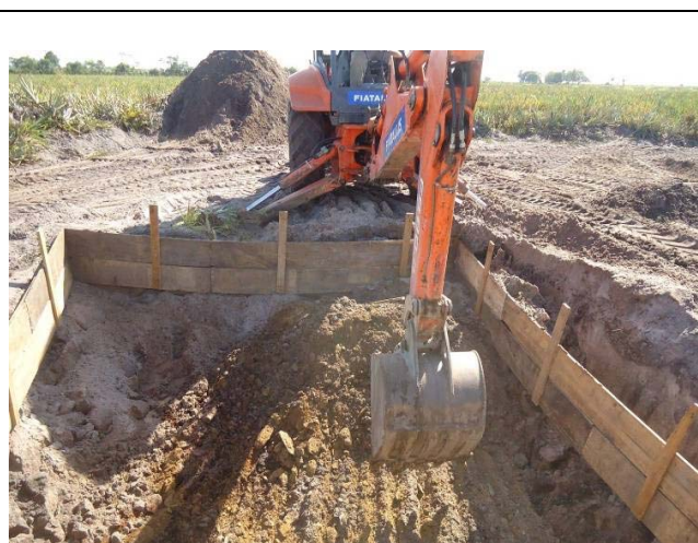
Foto 10.5.1-6 – Atividade de escavação / sapata pré-moldada (outra obra).
