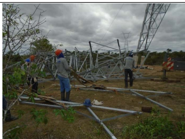
Foto 10.5.1-7 – Atividade de montagem de estrutura (outra obra).
