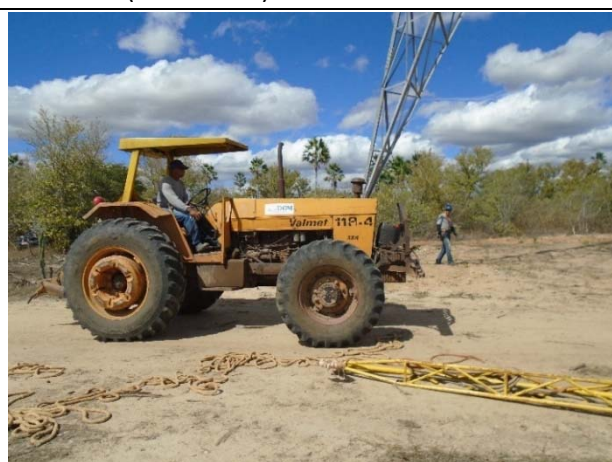
Foto 10.5.1-9 – Atividade de montagem de estrutura (outra obra).
