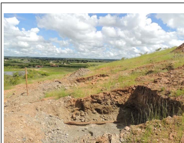
Foto 10.5.1-5 – Trabalho de abertura de cava para construção de fundação (outra obra).
