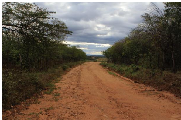
Foto 8.3.3-25 - Estrada de acesso ao Distrito de Engenho Velho.
