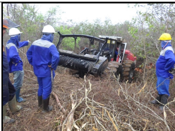
Foto 3-5 - Supressão mecanizada com o maquinário Prentice.
