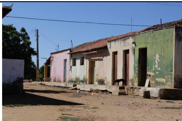
Foto 8.3.3-56 – Casas na sede do Distrito Coronel Maia.
