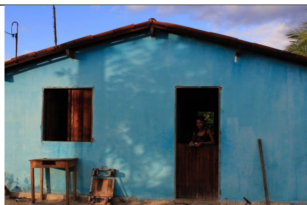
Foto 8.3.3-12 - Casa na Comunidade Sítio São Domingos.
