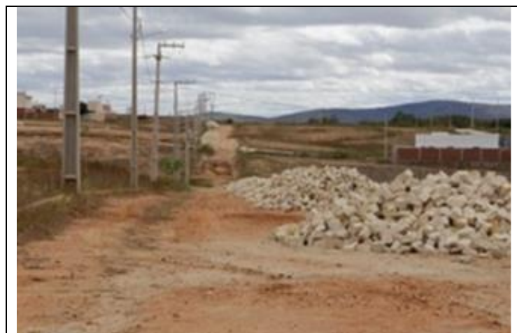
Foto 8.3.3-69 – Construções em loteamento urbano às margens da BR-230, expansão do perímetro urbano de Cajazeiras (PB)
