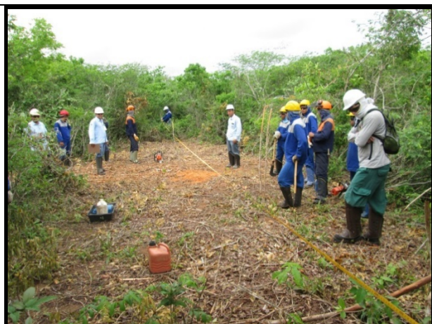
Foto 3-3 - Conferência das dimensões em área de torre
