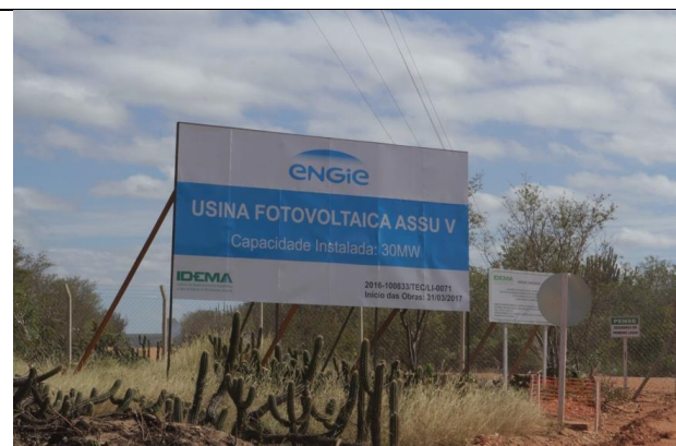
Foto 8.3.3-62 – Usina Fotovoltaica Assú V, em construção. Município de Assu (RN).
