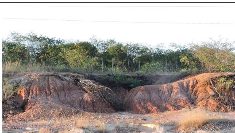
Foto 8.1.7-12 – Processos erosivos em talude exposto na Rod. BR-304
