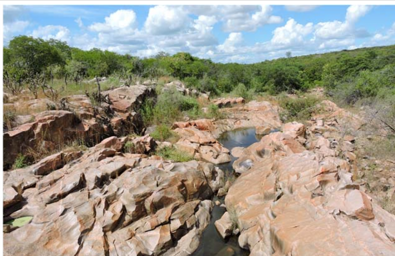
Foto 8.1.2-12 – Poço de Captação de Água (CH650/PRODEEM) para Abastecimento Doméstico / Animal.
