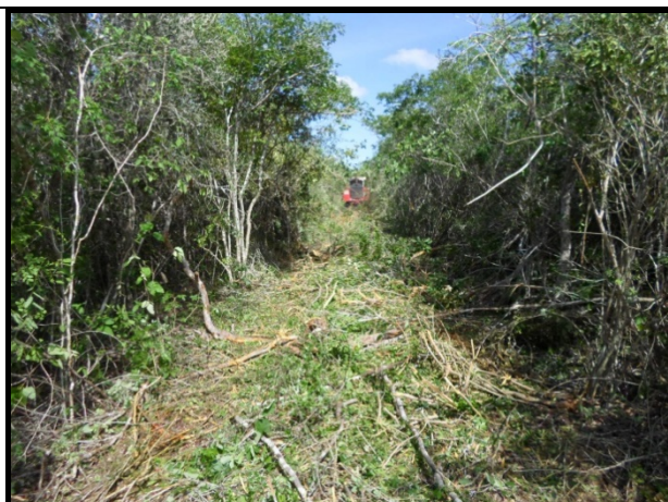
Foto 3-9 - Supressão mecanizada em faixa de serviço.
