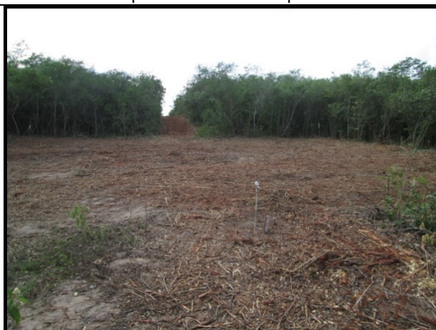
Foto 3-17 - Supressão realizada em área de torre autoportante
