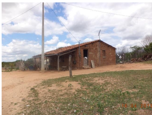
Foto 8.3.2.6-8 - Casa de morador de Lagoa Rasa (Coordenadas: S06°18'50.6"/W037°39'16.6") Fonte: ATE XVII/BOURSCHEID, 2013
