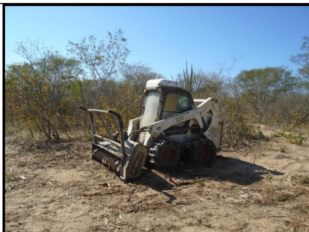
Foto 3-11 - Bobcat com cabeçote desbastador florestal, utilizado para supressão nessa área
