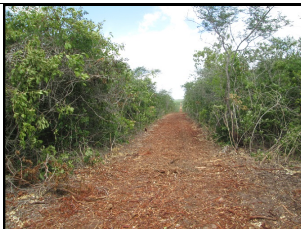
Foto 3-18 - Supressão em faixa de serviço
