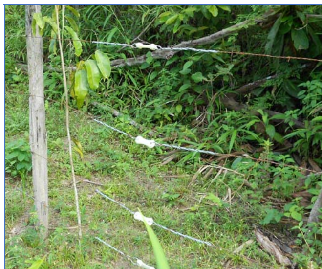
Figura 3.3.5.4-2 – Exemplo de cerca seccionada e aterrada.
