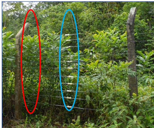
Figura 3.3.5.4-1 – Exemplo de cerca seccionada e aterrada. Destacam-se, na cor azul, o seccionamento da cerca e, na cor vermelha, o aterramento
