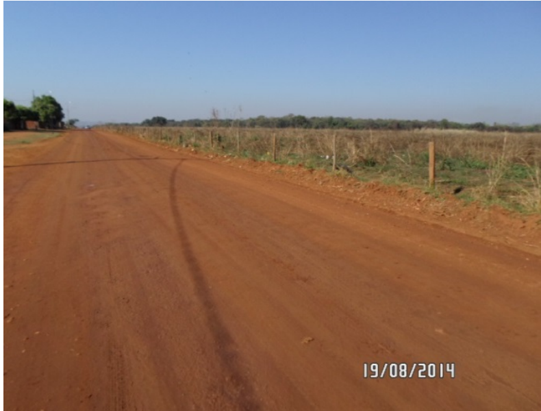
Figura 170 – Via de acesso a área de implantação do canteiro de obras.
