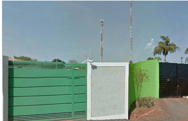
Figura 135 – Padrão construtivo da área 01 e torre de telecomunicação.
