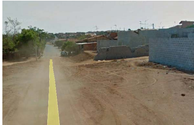
Figura 141 – Vias de deslocamento e sistema de iluminação residencial ao fundo, área 02.
