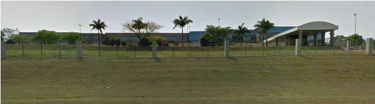
Figura 158 – Instalações da Motorola.
