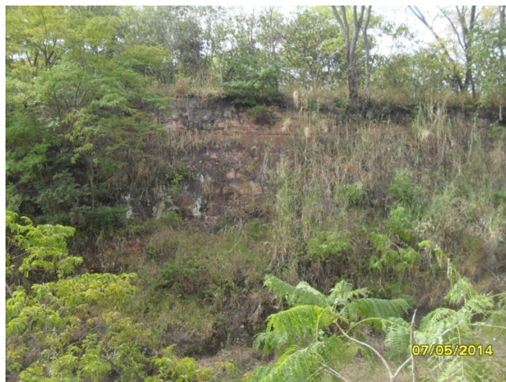
Figura 48 - Escarpas serranas (unidade de relevo R4d) cortadas pela rodovia SP-323 na AID, proximidades da cidade de Monte Alto/SP.
