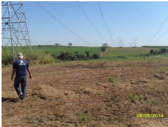
Figura 13 – Inspeção do tipo de terreno em que se localizarão as torres da LT.
