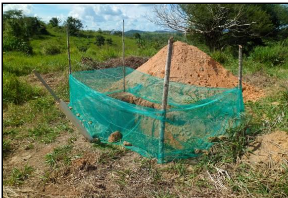
Figura 4.2.4-1 - Cercamento e cobertura de cavas de fundações
