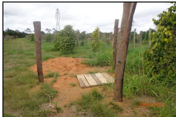
Figura 4.2.4-1 - Cercamento e cobertura de cavas de fundações
