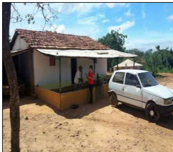
Figura 2.2.4.6-195 – Casa no Povoado Junco (Francisco Sá-MG)
