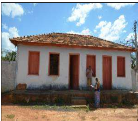
Figura 2.2.4.6-88 - Residência no Povoado Torquato Leite/MG
