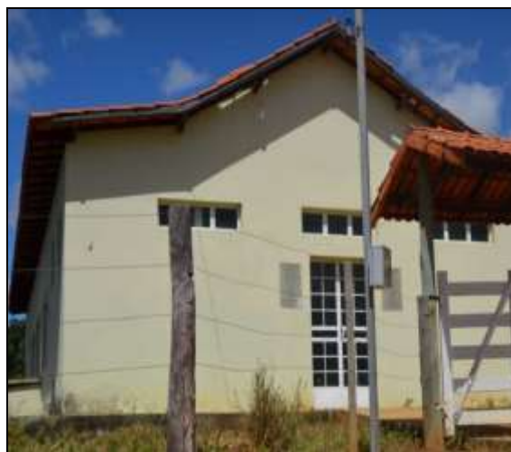
Figura 2.2.4.6-43 - Sede da Associação Comunitária do Vale Fundo, Santo Hipólito/MG
