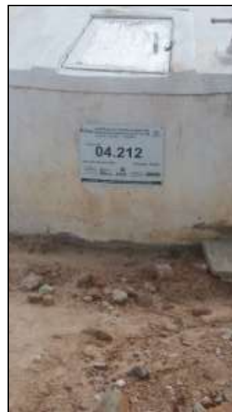
Figura 2.2.4.6-477 – Construção de cisterna no Semi-Árido – MDS – Tabuleiro - Espinosa (MG).
