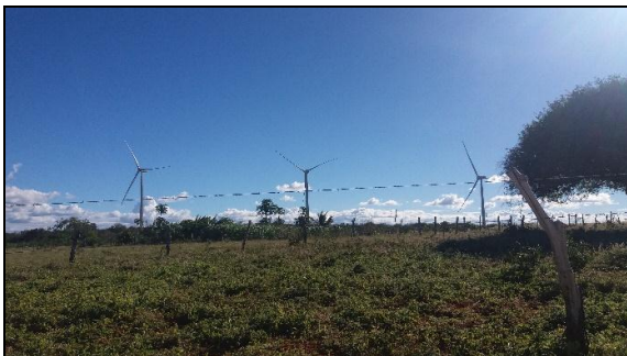
Figura 2.2.4.5-37 - Energia Eólica em Urandi.
