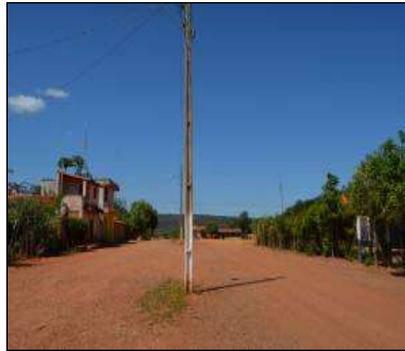
Figura 2.2.4.6-78 - Rua do Bairro Nova Dolabela/MG
