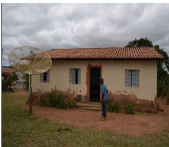
Figura 2.2.4.6-186 - Residência no Povoado São Paulinho (Francisco Sá-MG)
