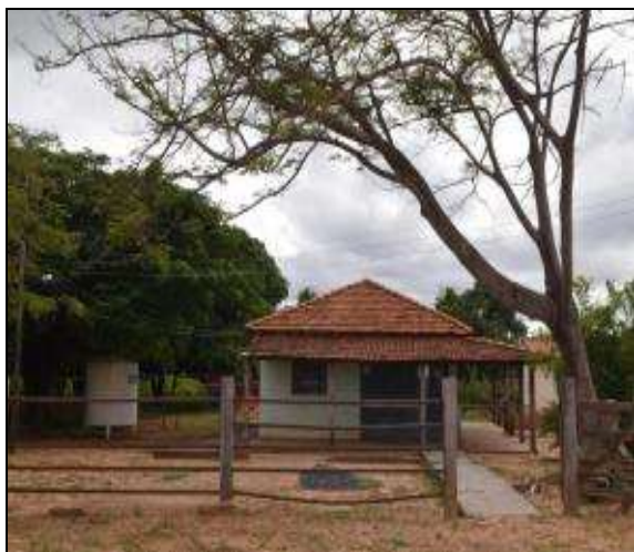
Figura 2.2.4.6-461. Caixa d’água – CODEVASF – PA Serrador – Francisco Sá
