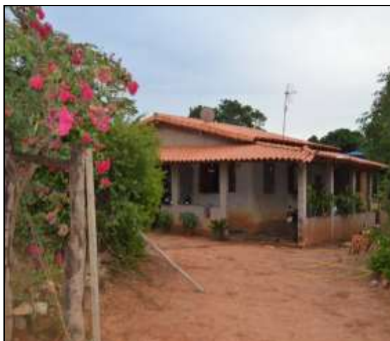
Figura 2.2.4.6-48 - Residência no Distrito Rodeador, Monjolos/MG
