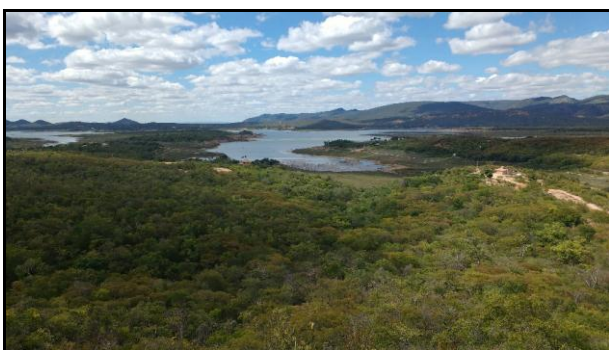
Figura 2.2.4.5-24 - Barragem Pico da Pedra – Janaúba/MG
