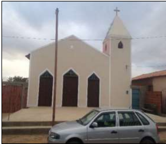
Figura 2.2.4.6-398 – Igreja em Tanque (Pindaí-BA).
