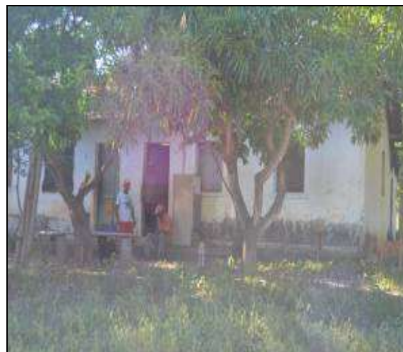
Figura 2.2.4.6-102 - Residência no PA Professor Mazan/MG
