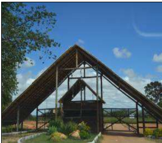
Figura 2.2.4.6-135 - Entrada da Comunidade Rural Hollywood/MG
