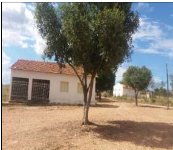
Figura 2.2.4.6-251 – Igreja ao fundo no povoado de Rio Abaixo (Monte Azul-MG).
