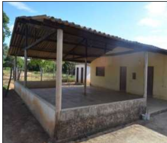
Figura 2.2.4.6-32 - Sede da Associação Comunitária de Malhada Alta, Augusto de Lima/MG
