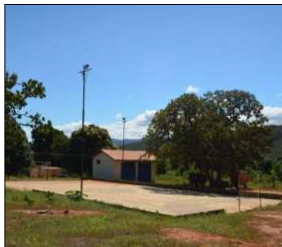
Figura 2.2.4.6-45 - Campo de Futebol em Quebra Pé, Monjolos/MG
