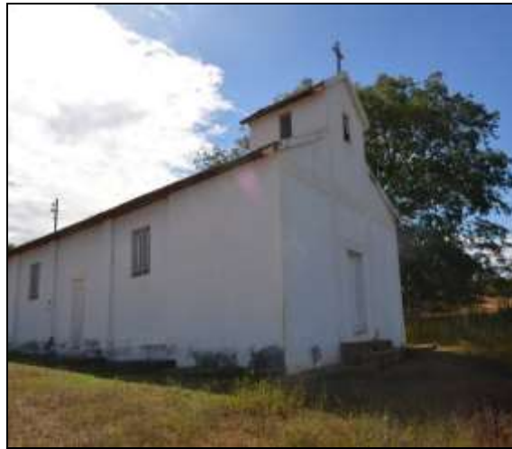
Figura 2.2.4.6-29 - Igreja Católica Povoado Sumidouro, Augusto de Lima/MG.
