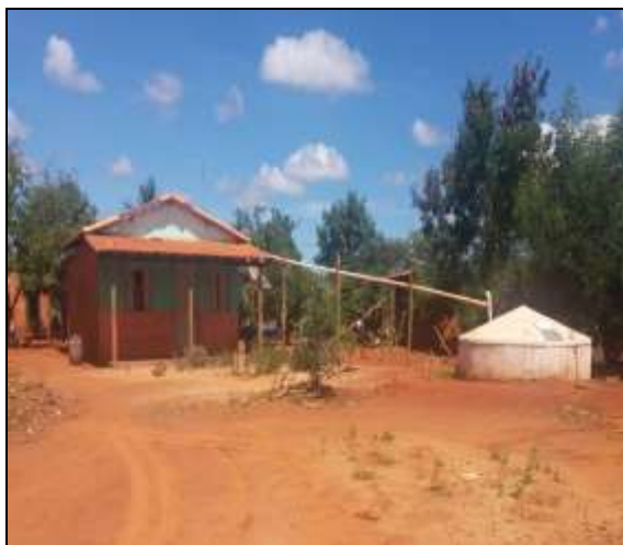
Figura 2.2.4.6-469. Cisterna instalada pelo Programa Água Para Todos em Junco (Francisco Sá/MG)
