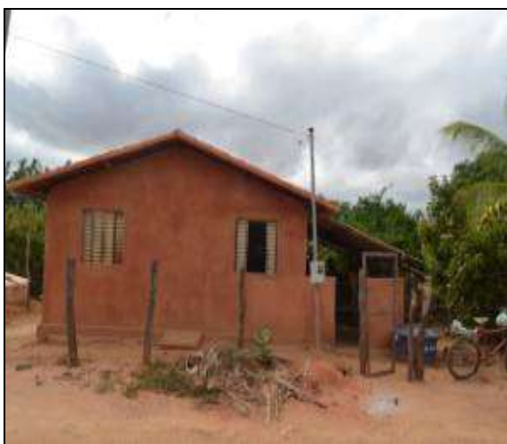
Figura 2.2.4.6-188 - Residência de assentado (Francisco Sá-MG)
