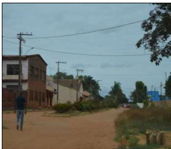
Figura 2.2.4.6-71 - Distrito de Engenheiro Dolabela, Bocaiúva/MG.
