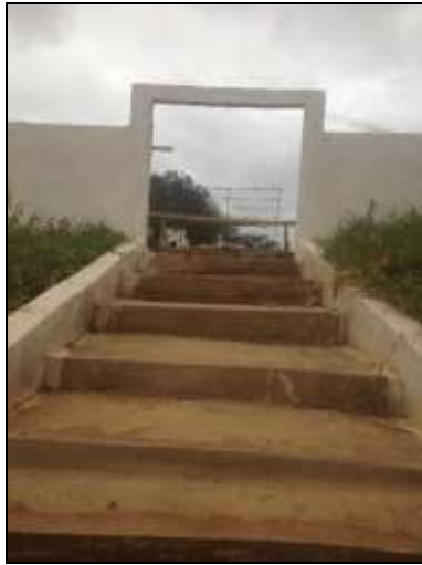
Figura 2.2.4.6-404 – Cemitério em Lagoa Velha (Pindaí-BA).
