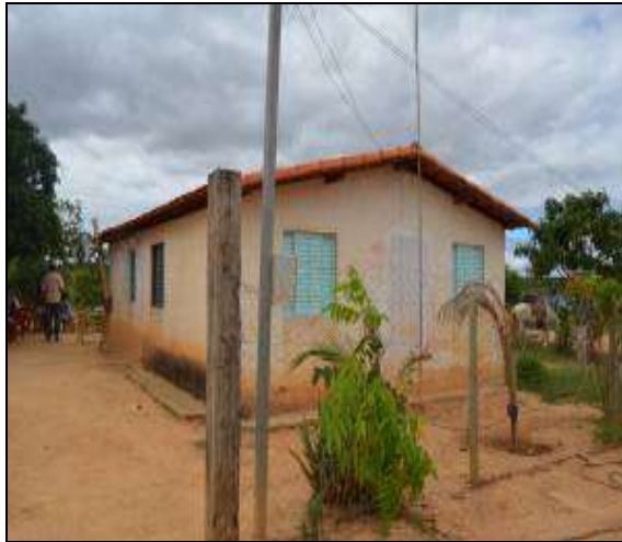
Figura 2.2.4.6-182 - Residência no Assentamento Serafim (Francisco Sá-MG)
