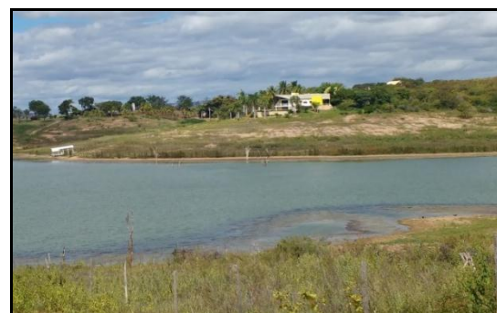
Figura 2.2.4.5-25 - Sítio em Barragem Pico da Pedra – Janaúba/MG
