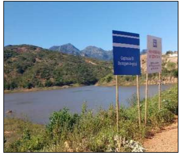
Figura 2.2.4.6-471 – Captação 01 – Barragem Angical – COPASA – Vila Angical - Monte Azul (MG).
