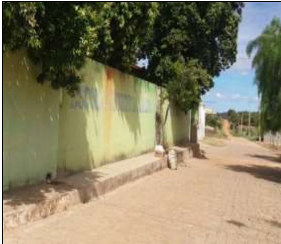
Figura 2.2.4.6-355 - Escola Municipal em Salinas (Urandi-MG).
