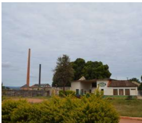
Figura 2.2.4.6-70 - Antiga Usina Malvina, no Distrito de Engenheiro Dolabela, Bocaiúva/MG.
