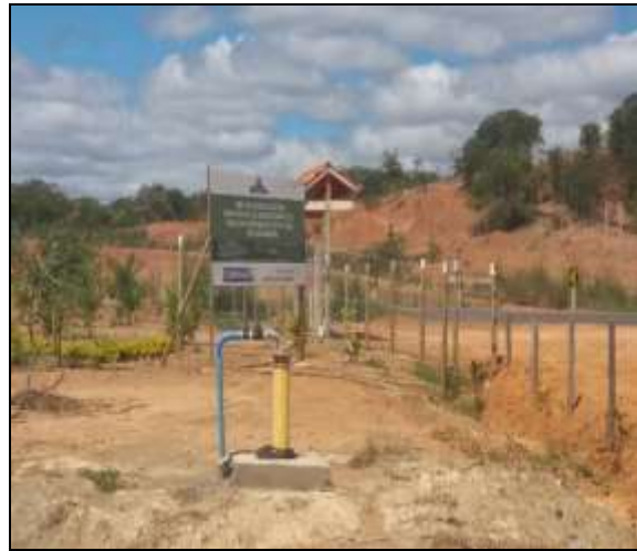
Figura 2.2.4.6-475 – Implantação do Sistema Simplificado de Abastecimento de Água na comunidade de Santa Cruz – Janaúba – CODEVASF com Cisterna Comunitária (MG).
