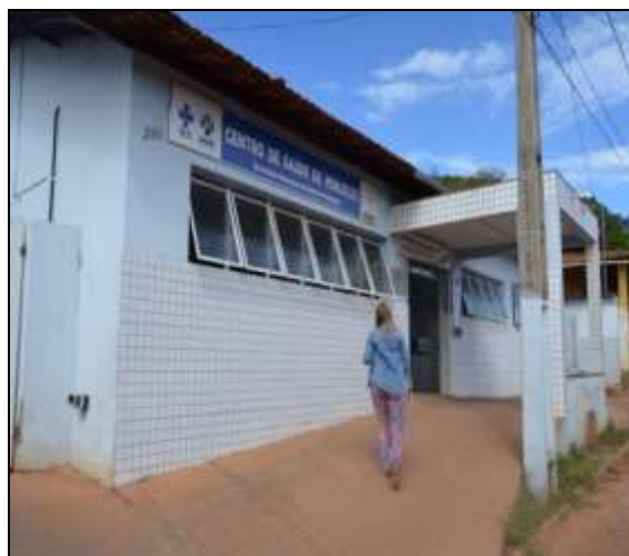
Figura 2.2.4.6-47 - Centro de Saúde da sede municipal de Monjolos/MG
