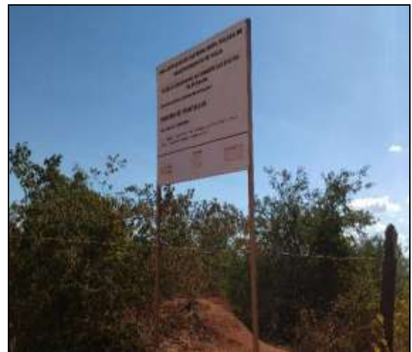
Figura 2.2.4.6-473 – Implementação de Sistema Simplificado de Abastecimento de Água – Ações Emergenciais aos efeitos da estiagem – Francisco Sá (MG).
