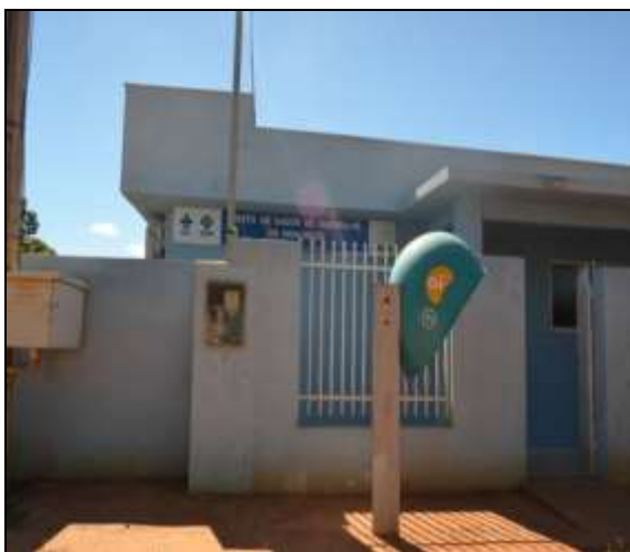
Figura 2.2.4.6-44 - UBS em Quebra Pé, Monjolos/MG
