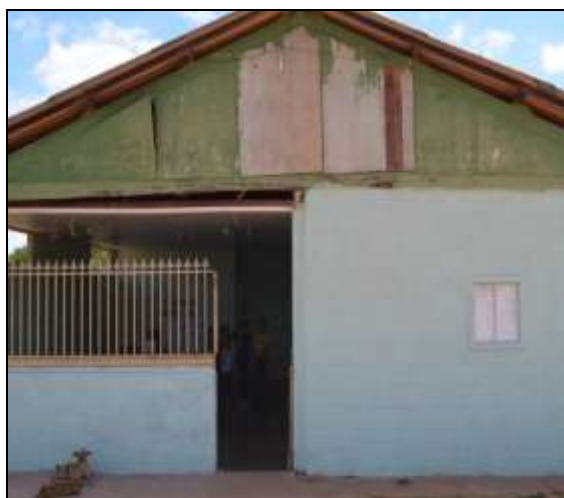
Figura 2.2.4.6-75 - Escola de Ensino Fundamental I, do PA Betinho - setor Lagoa Grande, Bocaiúva/MG.
