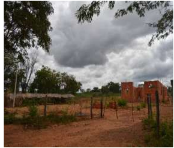
Figura 2.2.4.6-154 - Igreja em construção - Boa Sorte – Francisco Sá /MG
