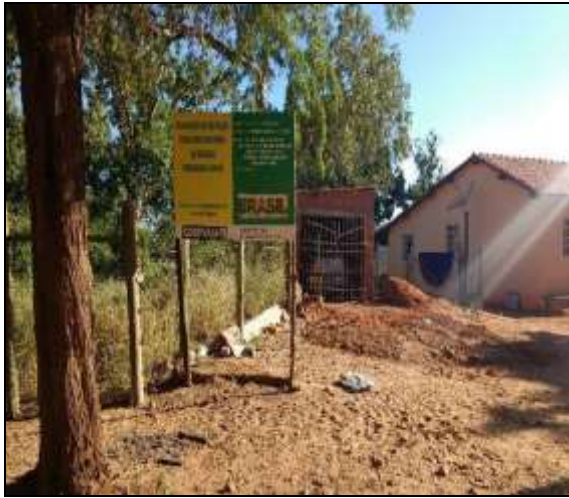
Figura 2.2.4.6-470 – Placa da CODEVASF informando a perfuração de 100 poços tubulares profundos – Vila Angical – Monte Azul (MG).
