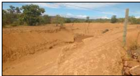
Figura 2.2.2.10-7 - Ravinamento em terreno aplainado sobre o saprolito e solos de metacalcilutito da Formação da Santa Helena, na região de Bocaiúva e Engenheiro Navarro (MG). UTM (SIRGAS-2000: 595018 / 8003461)
