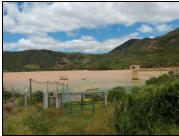
Figura 2.2.3.2-9 - Barramento do reservatório de Ceraima, de propriedade da CODEVASF.
