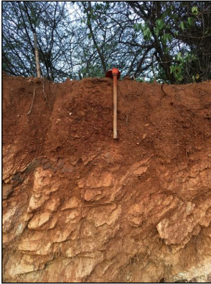
Figura 2.2.2.8-15 - Perfil de Neossolo Litólico Tb distrófico A moderado, fase cascalhenta, textura argilo-arenosa, relevo forte ondulado (UTM: 752661 / 8367776).
