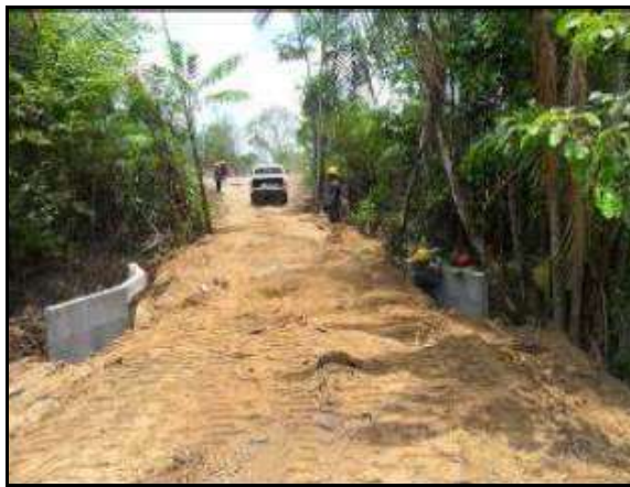
Figura 1.4-11 - Manilhamento de curso d'água com aterro.
