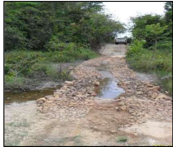
Figura 1.4-12 - Passagem molhada
