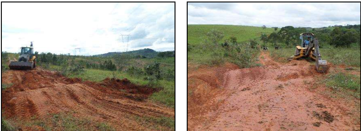
Figura 1.4-10 - Construção de camalhão com caixa de captação e construção de camalhão com saída d'água ("bigodes").
