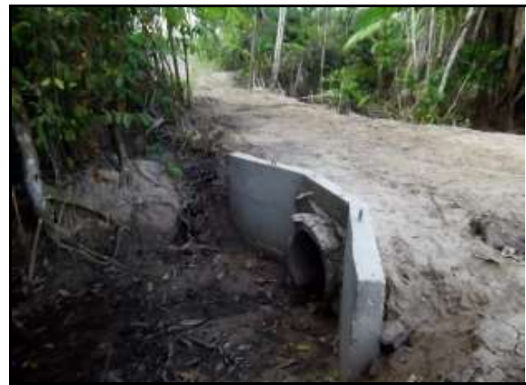
Figura 1.4-11 - Manilhamento de curso d'água com aterro.
