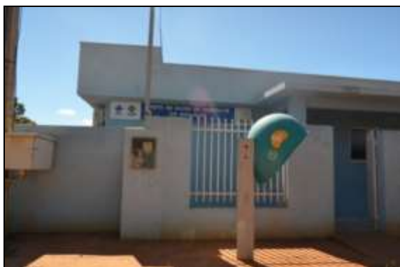
Figura 2.2.4.4.1-5 - Posto de Saúde do distrito de Quebra Pé (Monjolos)
