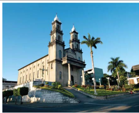
Foto 6.4.4-9 - Igreja de Nossa Senhora da Penha, em Castelo (ES).
