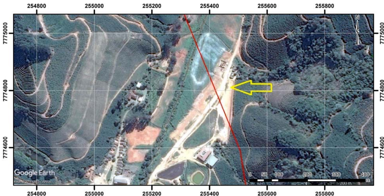
Figura 6.4.3-6 - Área de construção das casas, na Fazenda Leogildo, em Brejetuba (ES) Coord.: 24 k 255.471 E / 7.774.836 S
