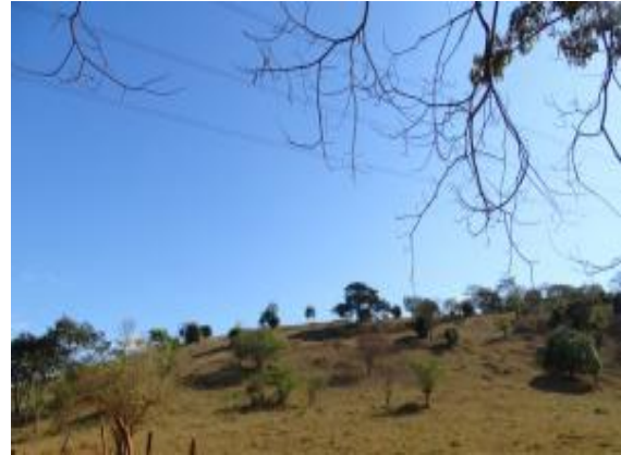
Foto 6.3.3-56 – PV19. O traçado da LT aproximada de uma LT 500 kV Mesquita – Viana 2, existente. Município de Mutum / MG. Coordenadas: 24K 245.400 E / 7.794.797 S.
