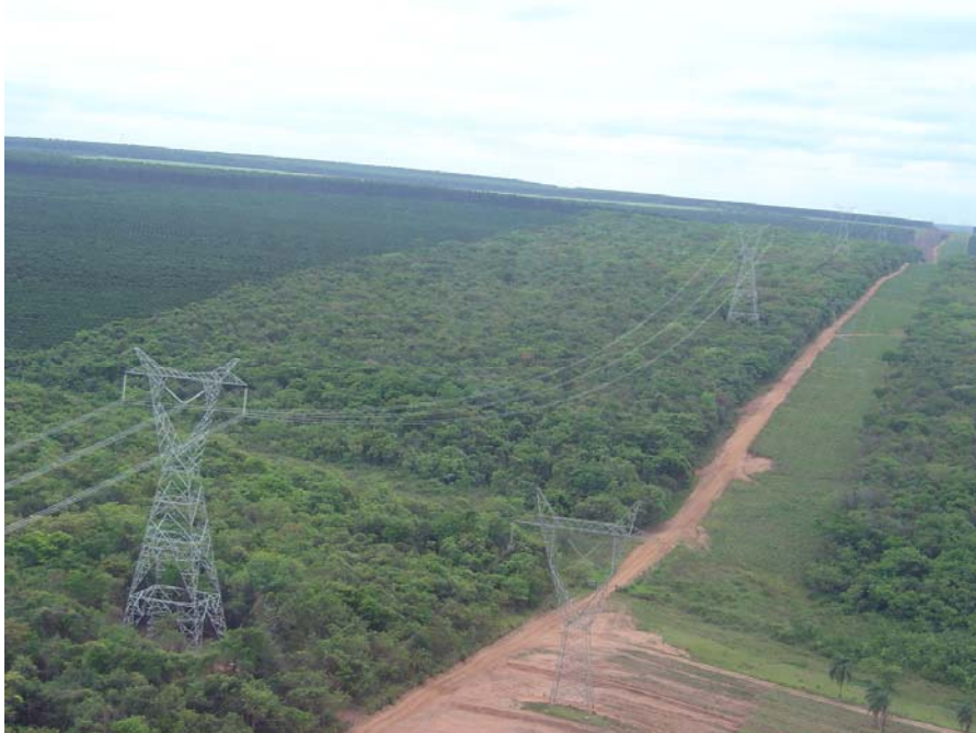
Figura 3.2.15 – Nota-se que as torres da LT mais recente (à esquerda), foram alteadas, preservando a vegetação nativa existente.
