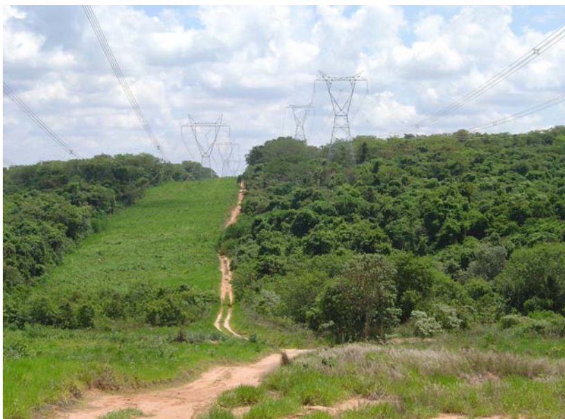
Figura 3.2.13 – Nota-se que as torres da LT mais recente (à direita), foram alteadas, preservando a vegetação nativa existente.
