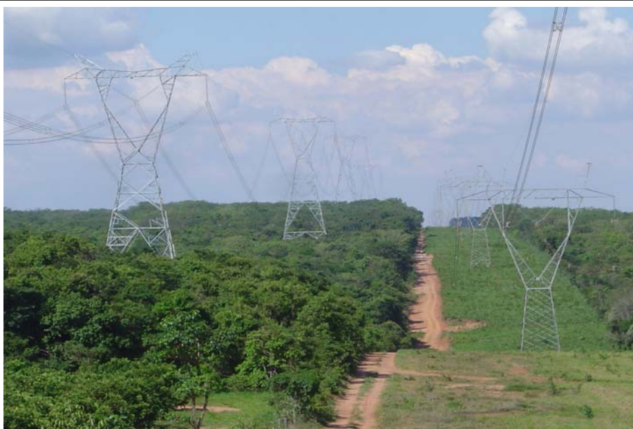
Figura 3.2.14 – Nota-se que as torres da LT mais recente (à esquerda) foram alteadas, preservando a vegetação nativa existente.
