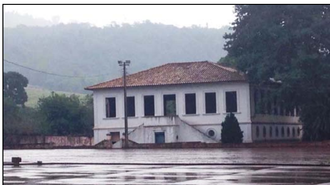
Figura 6.2-6 - Sede da Fazenda da Serra, Monte Santo de Minas
