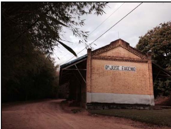
Figura 3.4.8-9 - Município de São José do Rio Pardo - Antiga estação de trem desativada da Fazenda Santa Helena
