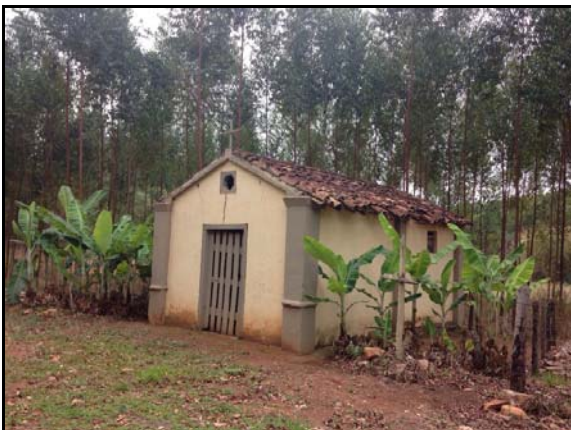
Figura 3.4.8-13 -Município de Itapira - Capela com tumulo ao lado
