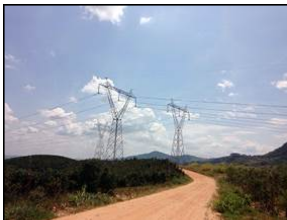
Figura 3.4.6-42 - Linha de Transmissão e Estrada em Serra Negra (SP)
